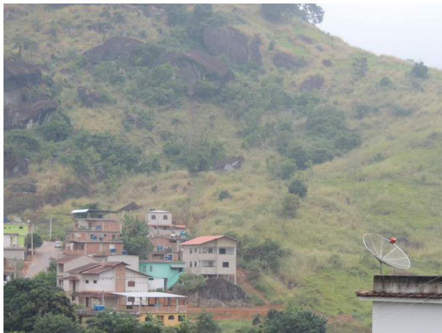
Foto 37 – Depósito de tálus e domicílios construídos sobre o mesmo.
