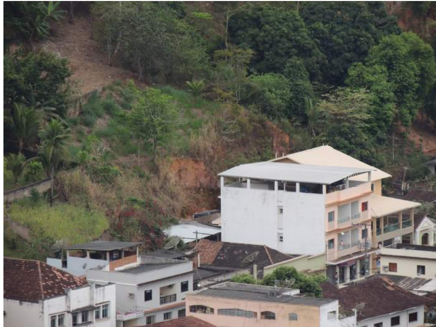
Foto 32 – Vista aproximada de trecho com maior instabilidade.
