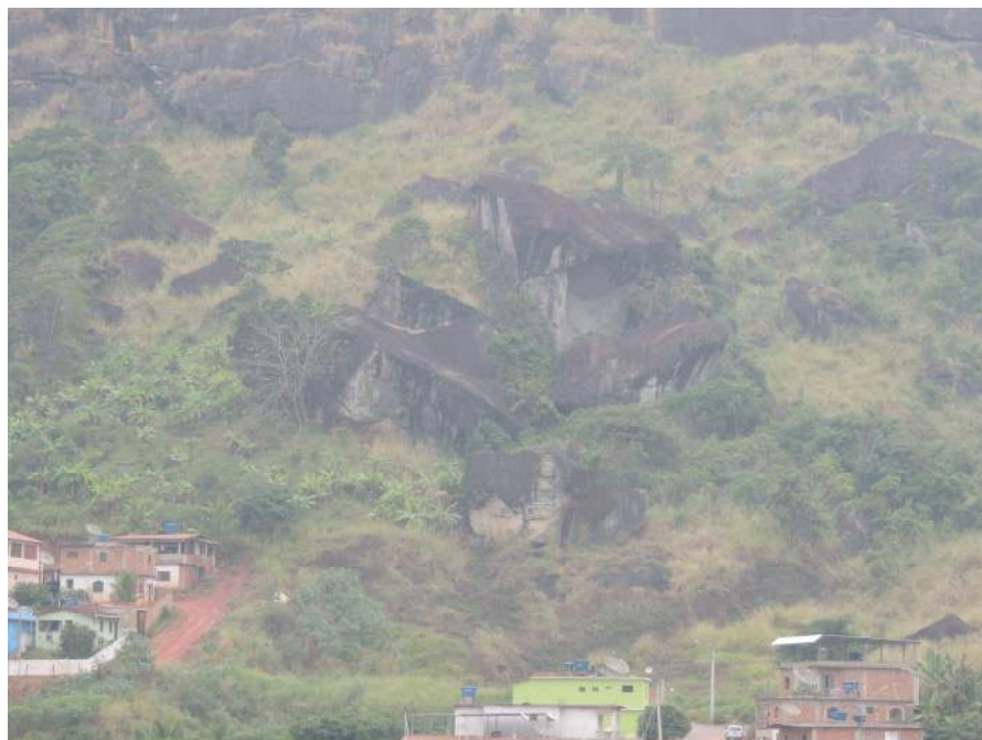
Foto 36 – Depósito de tálus com blocos de grandes dimensões e avanço da ocupação para montante.
