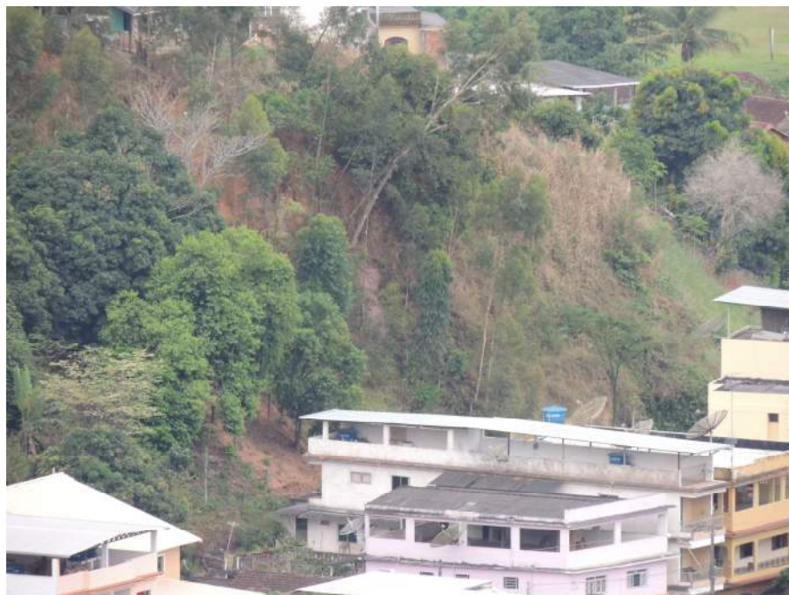
Foto 34 – Trecho complementar da encosta que compõem o setor de risco.
