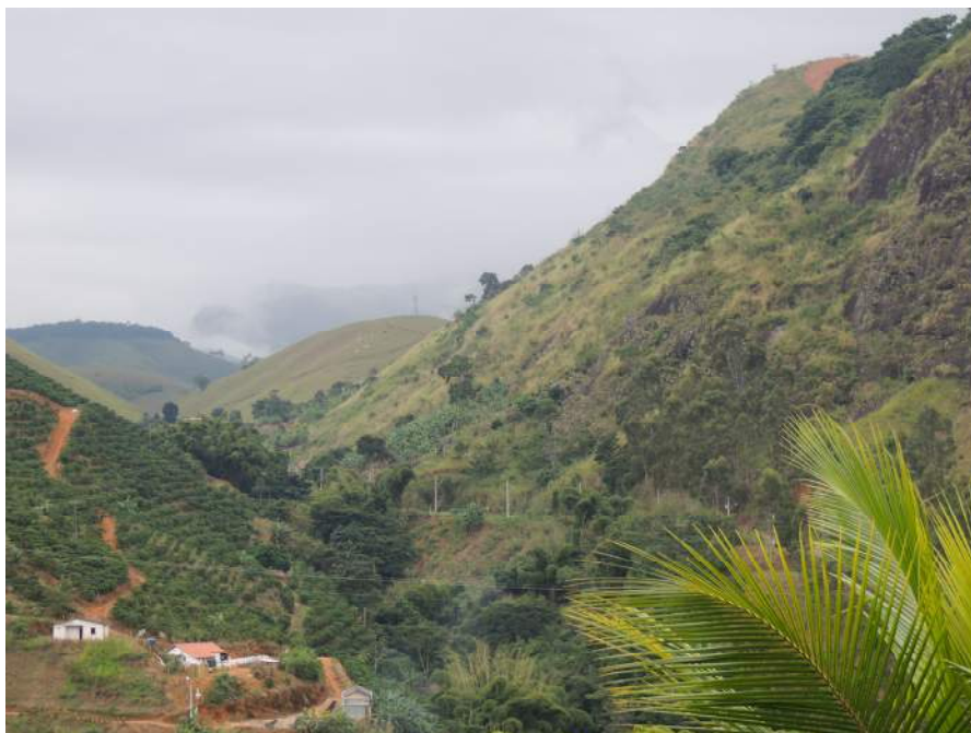
Foto 5 – Encosta que compõem o setor de risco com inclinação elevada e diversos blocos e lascas rochosas apoiados irregularmente.
