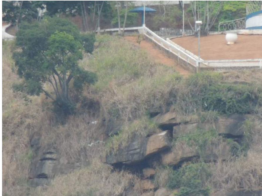
Foto 16 – Detalhe aproximado da mesma encosta destacando trecho com lascas rochosas instáveis.
