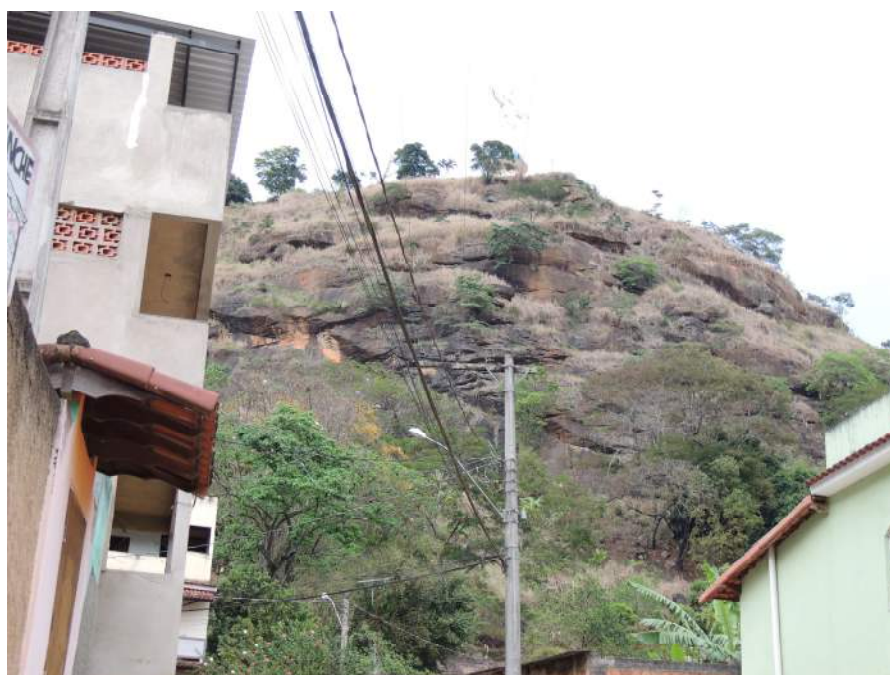
Foto 19 – Vista complementar de outro ângulo permitindo visualizar as lascas rochosas instáveis e a ocupação na base da encosta.
