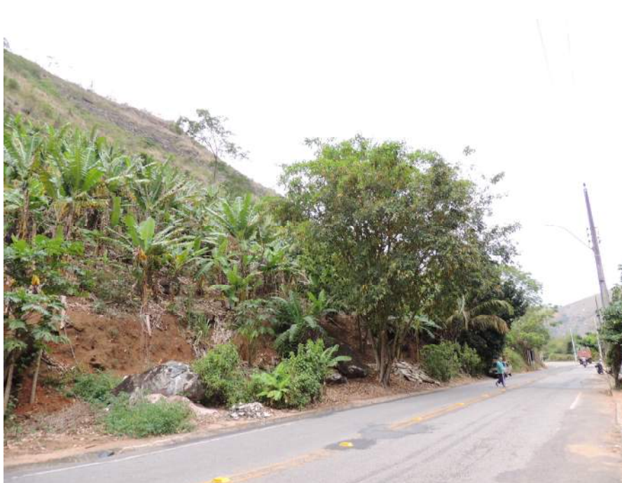
Foto 8 – Vista complementar a foto anterior com detalhe para os blocos rolados até a base da encosta.
