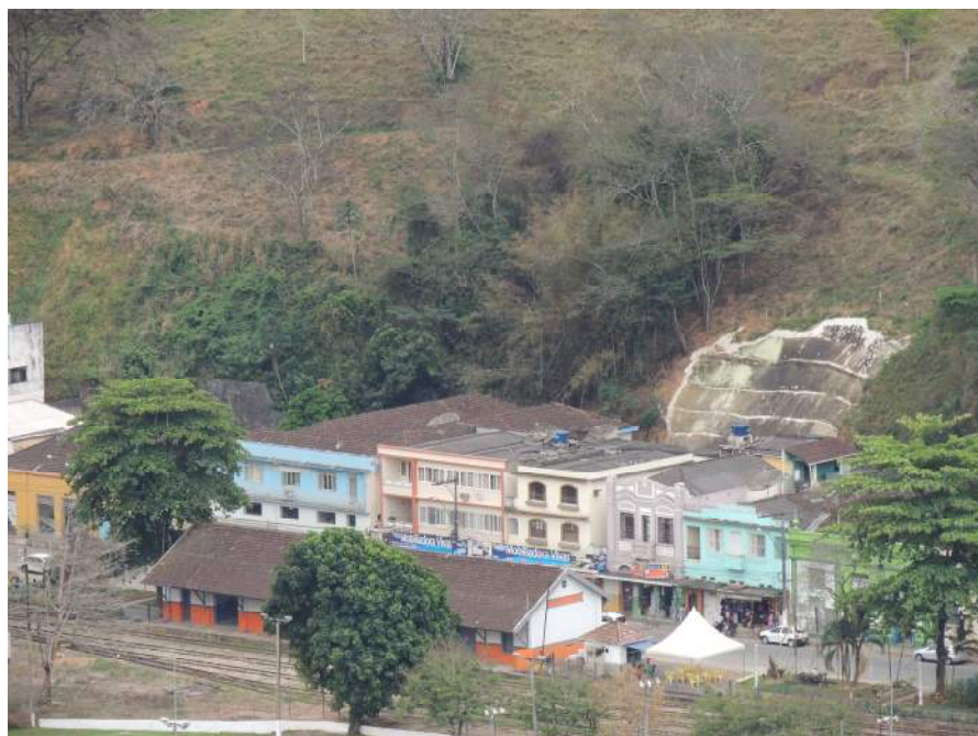
Foto 30 – Vista de trecho estabilizado ao lado de trecho instável.
