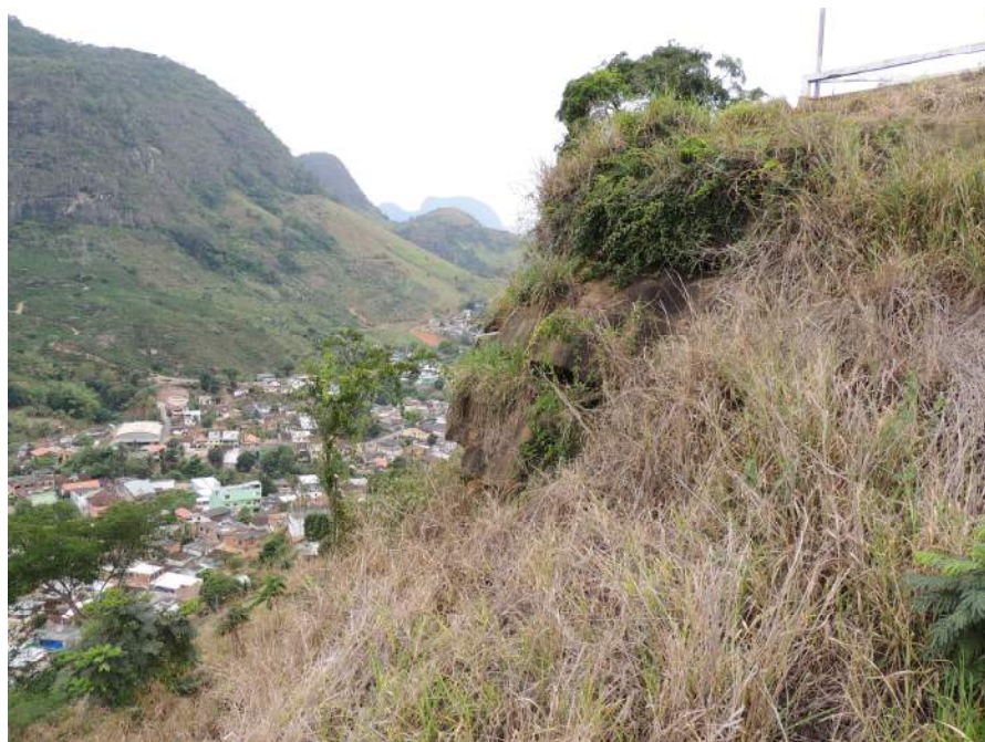
Foto 18 – Detalhe do trecho da encosta a partir do próprio maciço.
