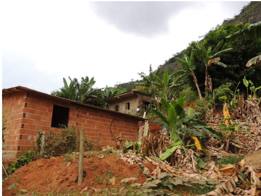
Foto 40 – Notar adensamento da ocupação sobre o depósito de tálus.
