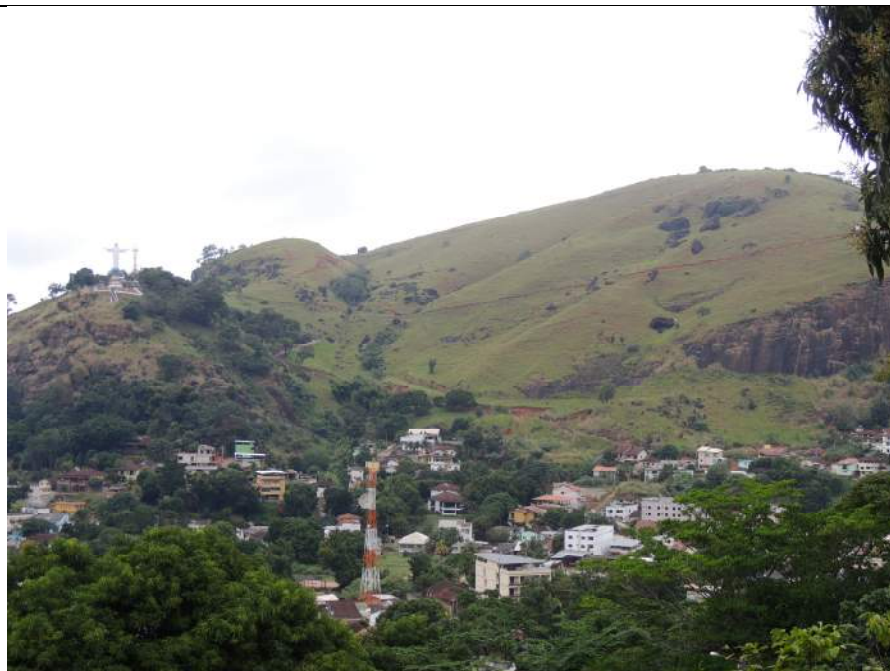
Foto 21 – Encosta a direita do maciço da estátua do cristo onde o setor de risco foi delimitado.
