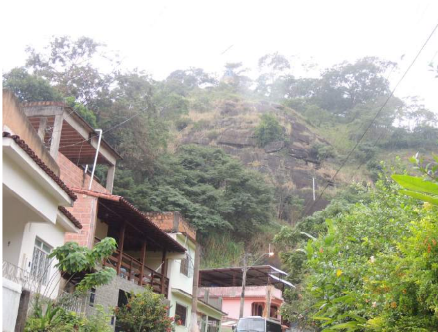
Foto 14 – Trecho da encosta a jusante do cristo com lascas rochosas instáveis.
