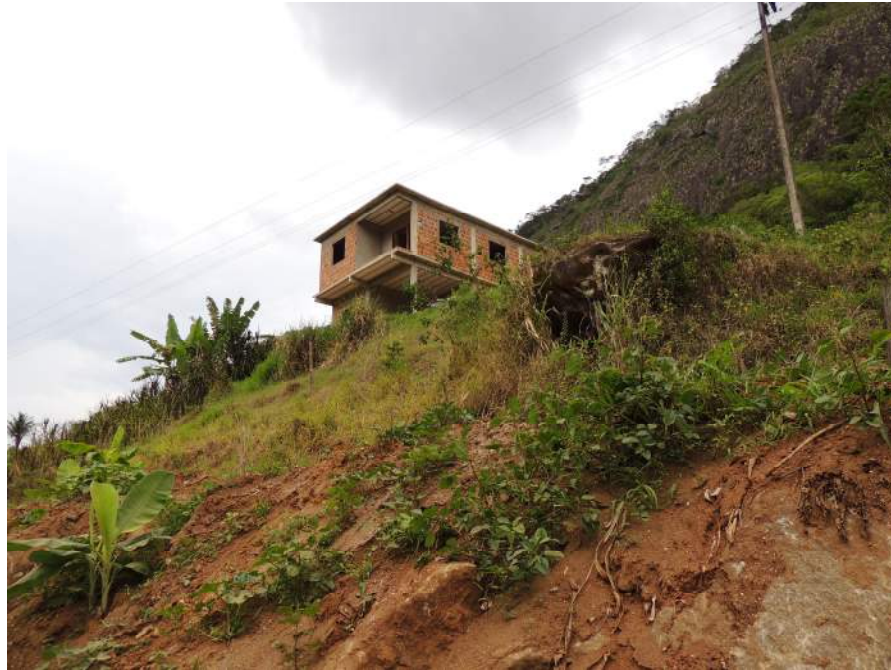
Foto 39 – Depósitos de tálus e novos domicílios sendo construídos.
