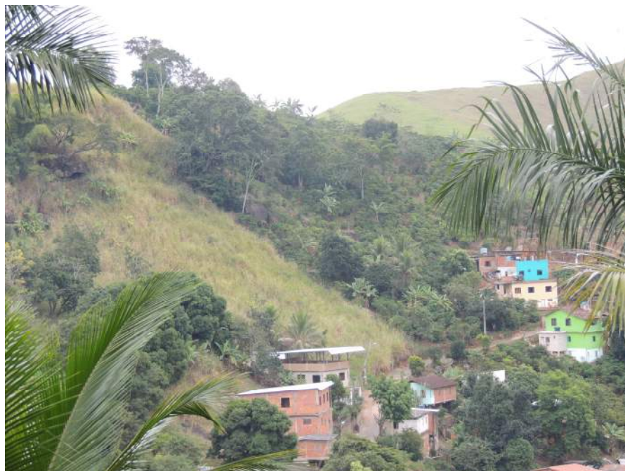
Foto 10 – Blocos rochosos de grandes proporções apoiados sobre uma camada delgada de solo em uma encosta com inclinação acentuada.
