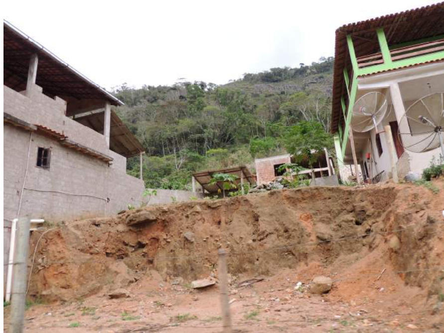
Foto 41 – Detalhe para o tipo de substrato: solo residual transportado com lascas rochosas.
