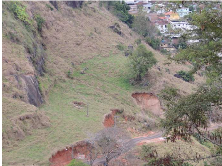
Foto 25 – Feições de instabilidade ao longo de toda encosta.
