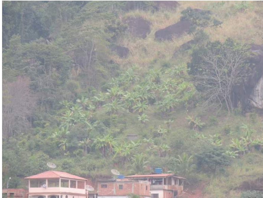
Foto 38 – Detalhe para a inclinação acentuada da encosta.
