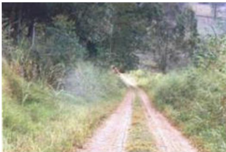
Figura 11-4 – Taludes de corte e aterro e áreas não transitáveis recoberto com espécies herbáceas em estrada vicinal.
