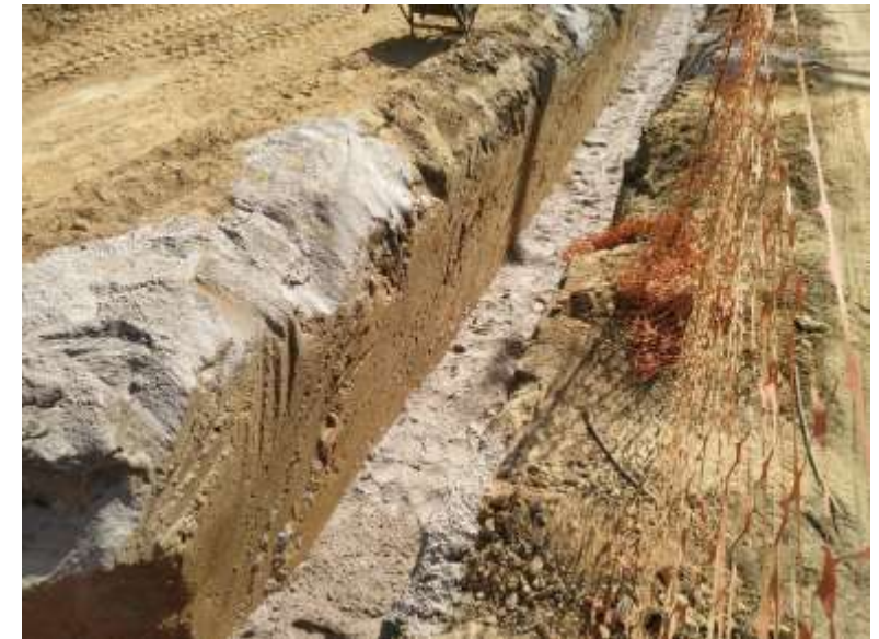
Reaterro com areia.
