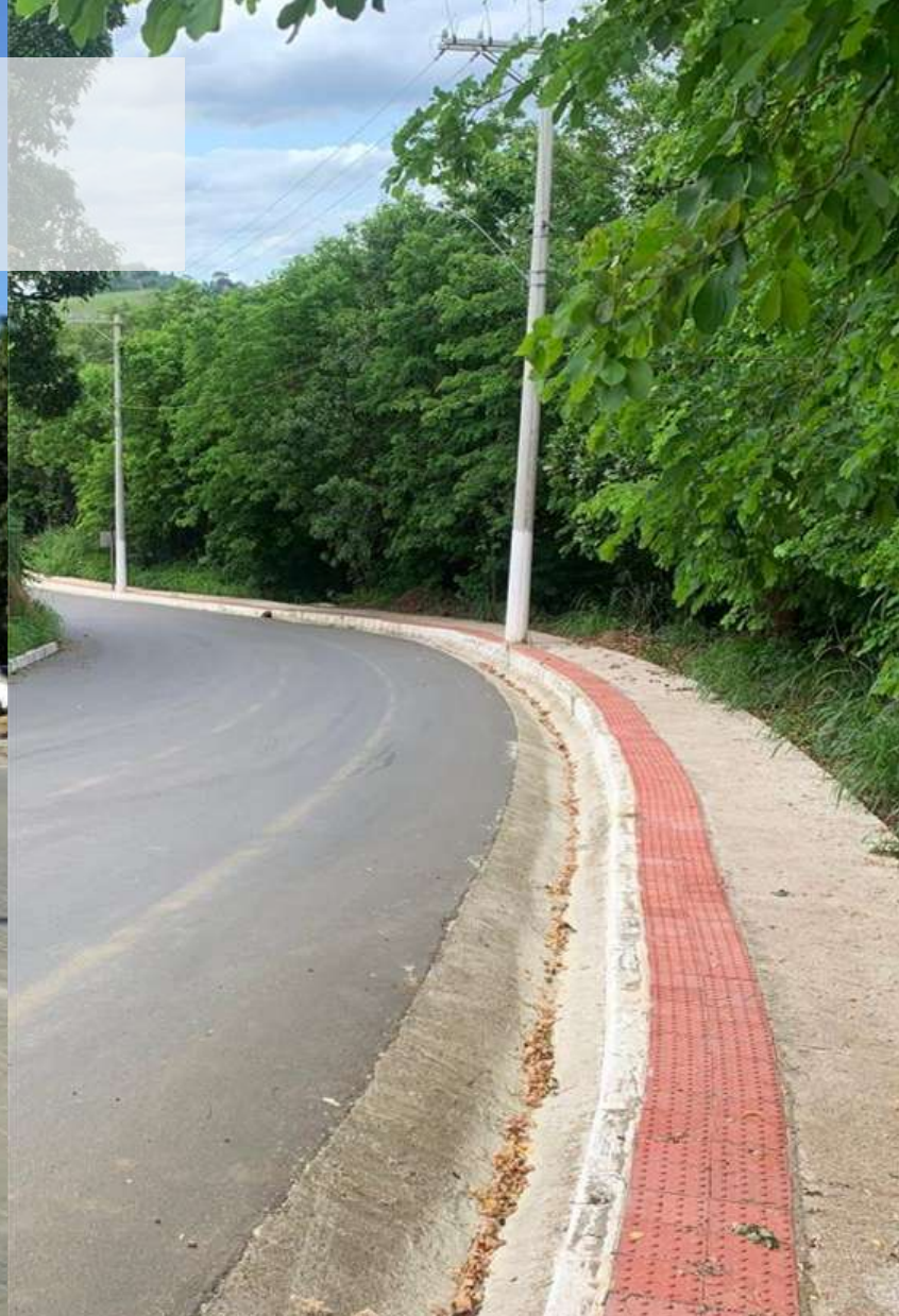
Drenagem e pavimentação asfáltica
