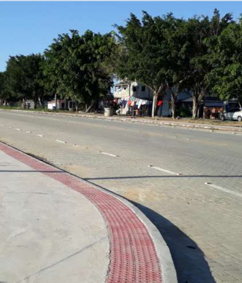
Pavimentação em blocos, calçadas e sinalização
