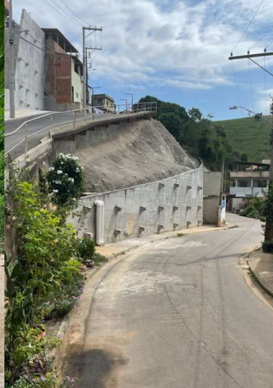
Proteção, contenção e estabilização de encostas
