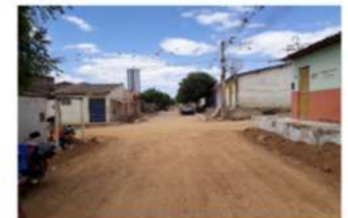
Foto-06 (RUA SEVERINO VALETIM-Valetim-II)
