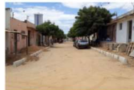
Foto-05 (RUA SEVERINO VALETIM-Valetim-II)
