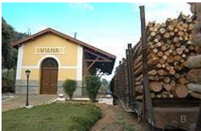
Figura 19 - Estação Ferroviária de Viana
