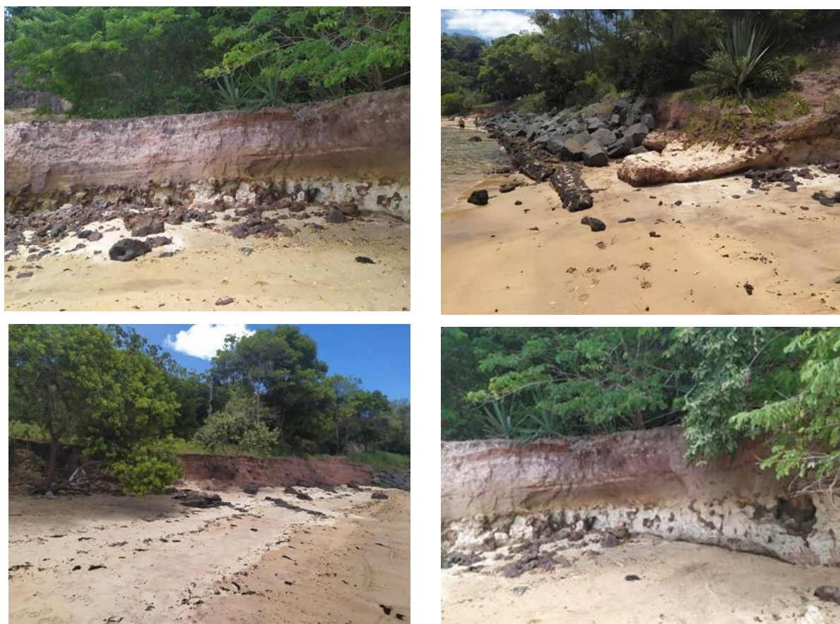
Figura 2 - Processo erosivo da Orla Praia Grande
