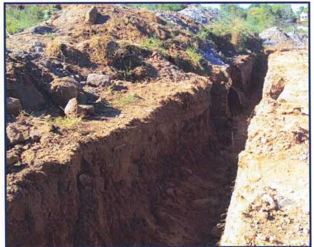
Foto 35: Material escavado impróprio para reaterro
