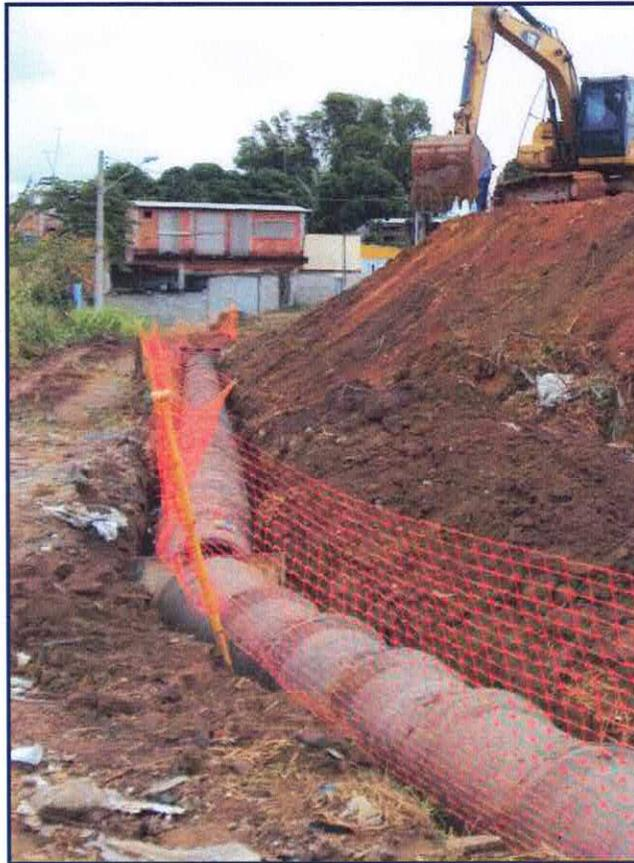
Foto 21: Material escavado impróprio para reaterro (contaminado por entulho)
