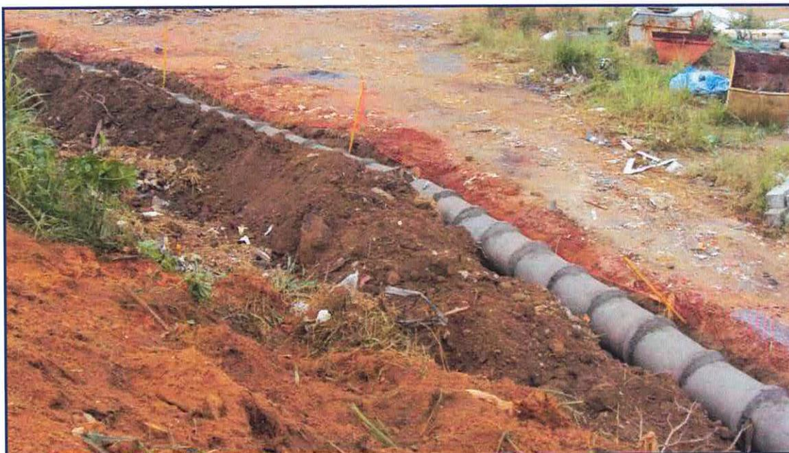
Foto 20: Material escavado impróprio para reaterro (contaminado por entulho)
