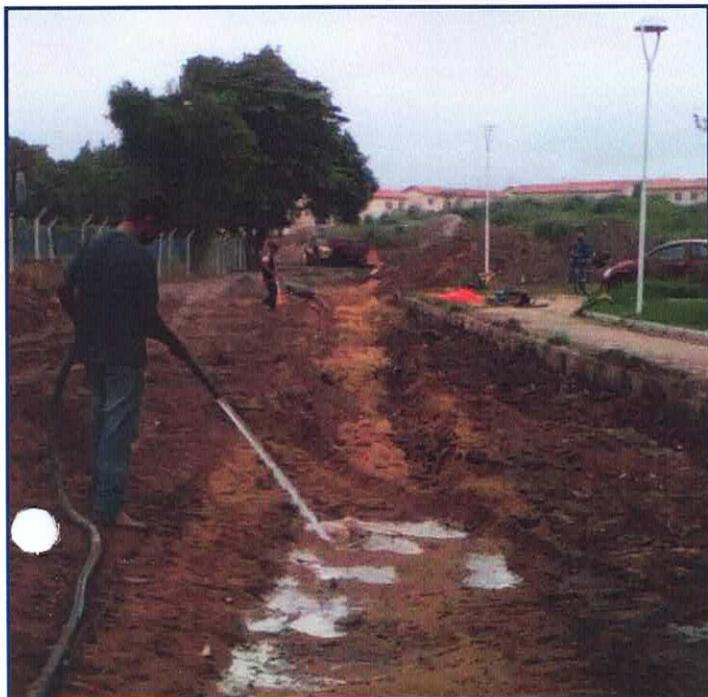
Foto 36: Reaterro da rede de esgoto com areia
