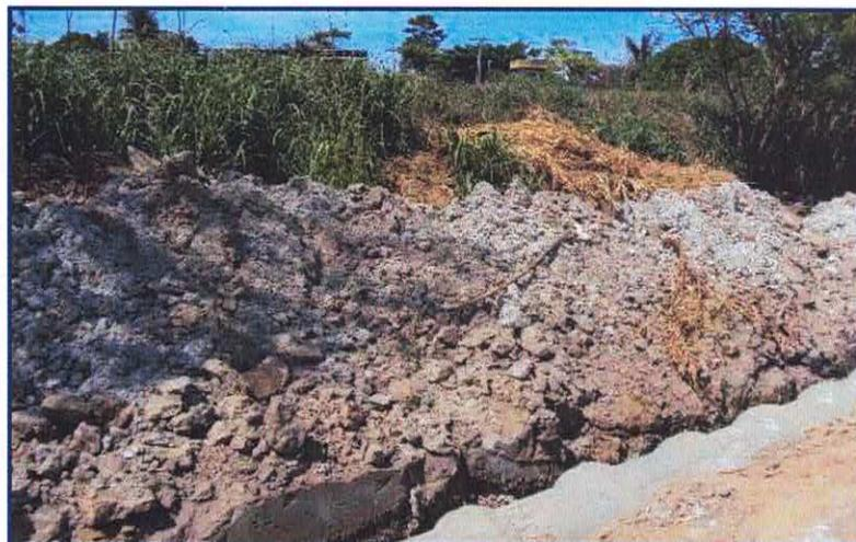
Foto 18: material escavado impróprio para reaterro
