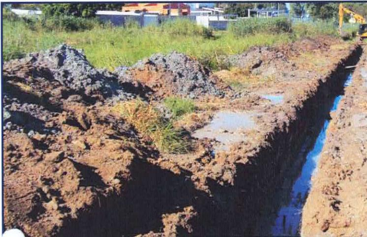
Foto 34: Material escavado impróprio para reaterro
