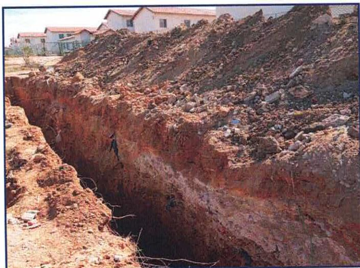
Foto 30: Material escavado impróprio para reaterro
