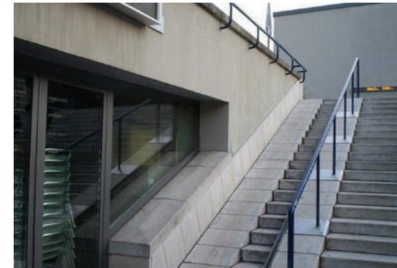
Figura 57 - Exemplos de dispositivos para bicicletas em escadarias
