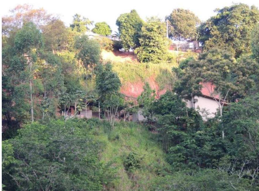
**Foto 56** - Ocupação ao longo da base e cicatrizes de movimentos de massa e processos erosivos ao longo da encosta.
