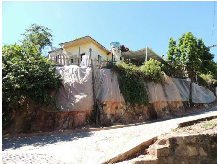
**Foto 93** - Vista aproximada de um segundo talude de corte parcialmente protegido de forma paliativa.
