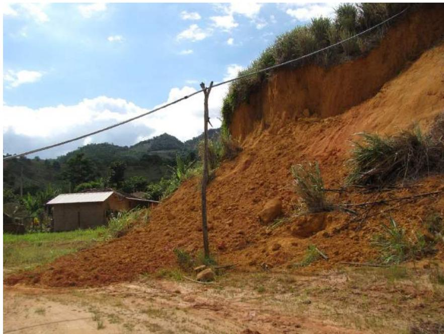
**Foto 94** - Talude de corte verticalizado instável que teve a base posteriormente ocupada.
