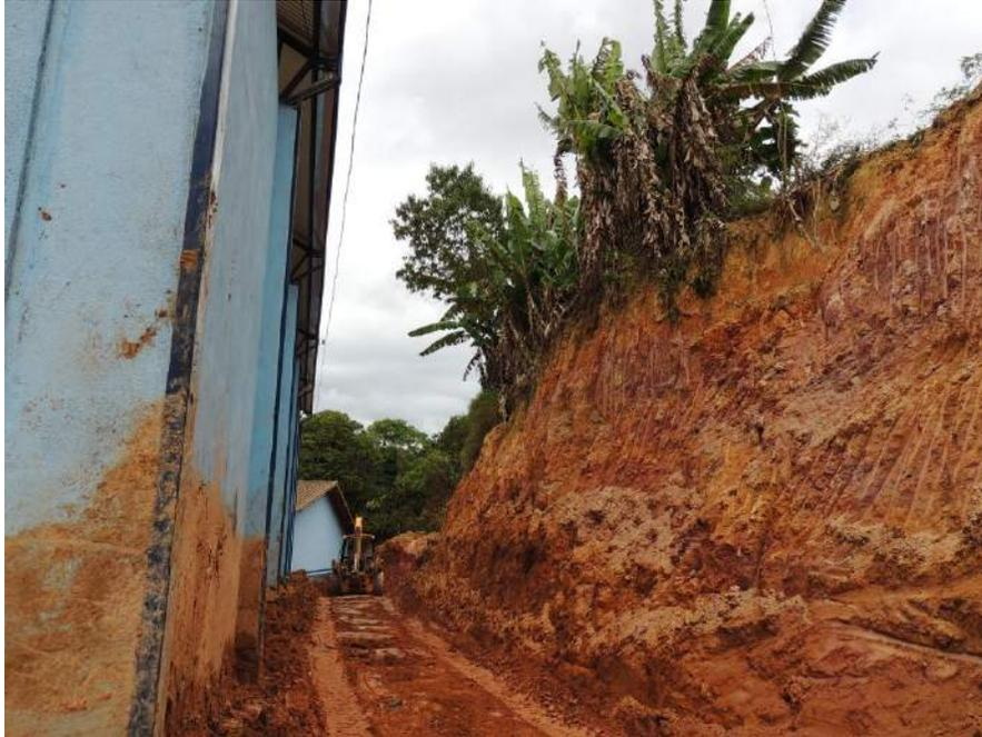
**Foto 97** - Talude nos fundos da escola com trabalho de limpeza da base em andamento.
