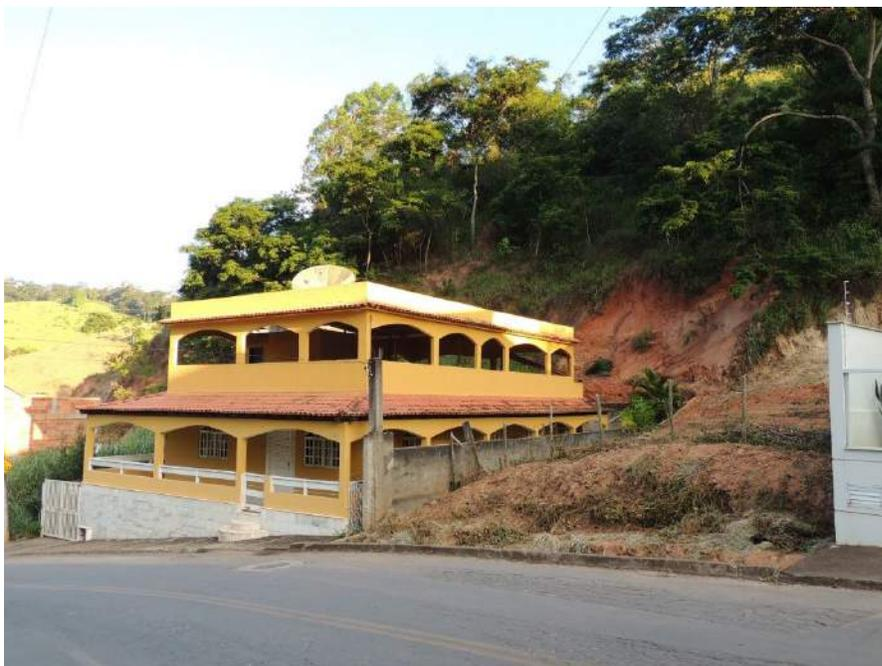
**Foto 51** - Vista parcial da encosta com detalhe para cicatrizes de movimentos de massa e volumes de solo já rompidos em eventos anteriores.
