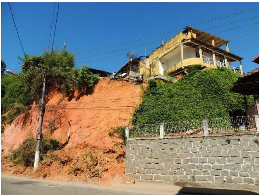
**Foto 85** - Trecho instável onde ocorreu deslizamento de solo com atingimento Av. Marfisa de Barros Leite e instabilização da crista.
