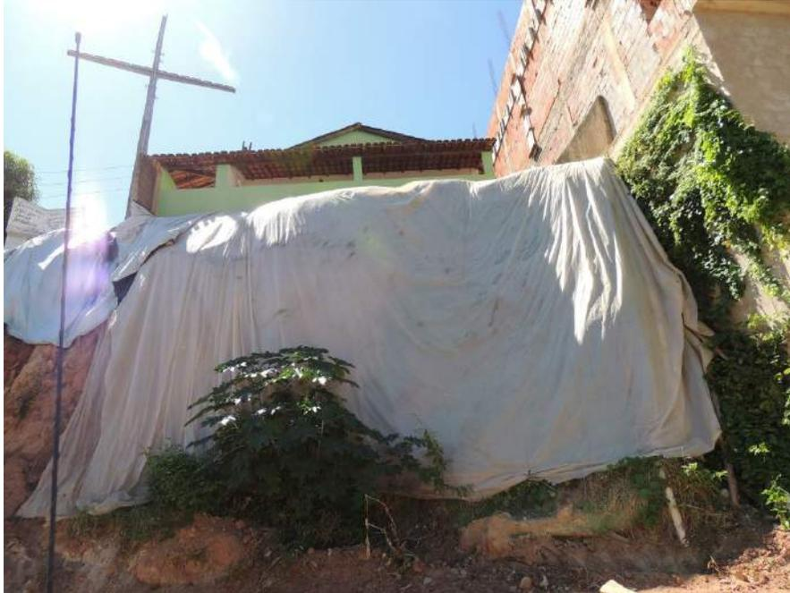
**Foto 92** - Vista aproximada do talude de corte parcialmente protegido de forma paliativa.
