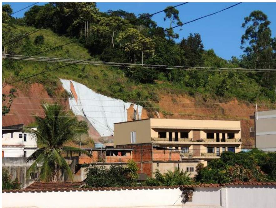
**Foto 53** - Vista parcial da encosta que compõe o setor de risco com detalhe para trecho parcialmente protegido após ocorrência de movimentos de massa.
