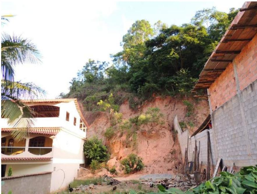
**Foto 50** - Vista parcial da encosta com detalhe para cicatrizes de movimentos de massa e volumes de solo já rompidos em eventos anteriores.
