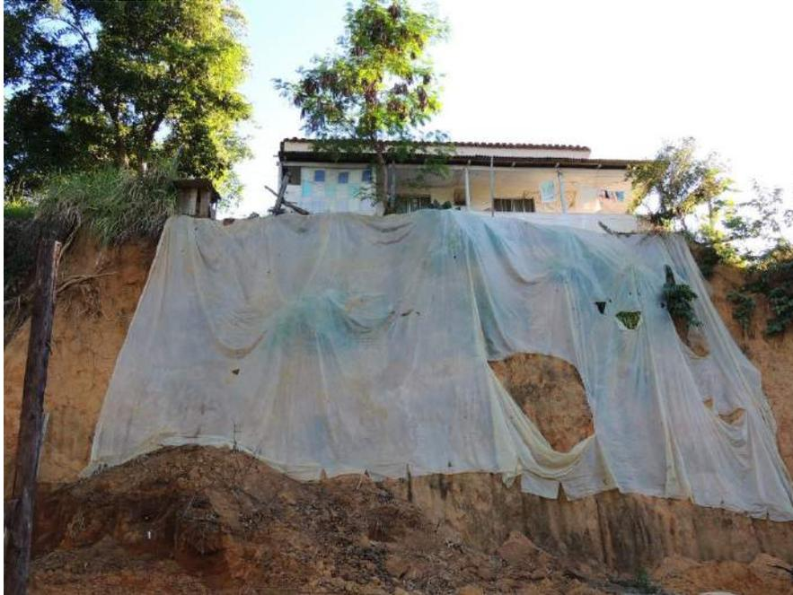
**Foto 70** - Tipologia de ocupação com a geração de cortes verticalizados com alturas superiores a 5,0m adjacente a Rua das Margaridas.
