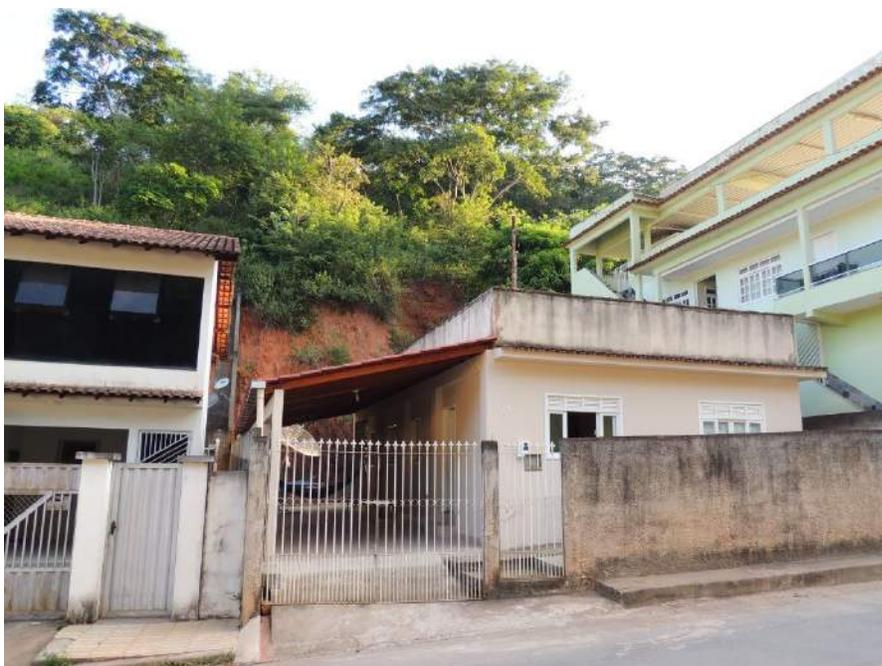
**Foto 52** - Tipologia comum de ocupação por meio de cortes verticalizados não estabilizados.
