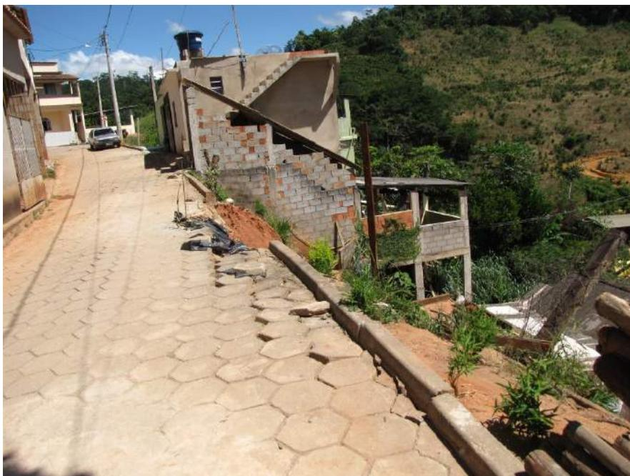
**Foto 107** - Trecho a Rua parcialmente em ruptura com progressão do processo.
