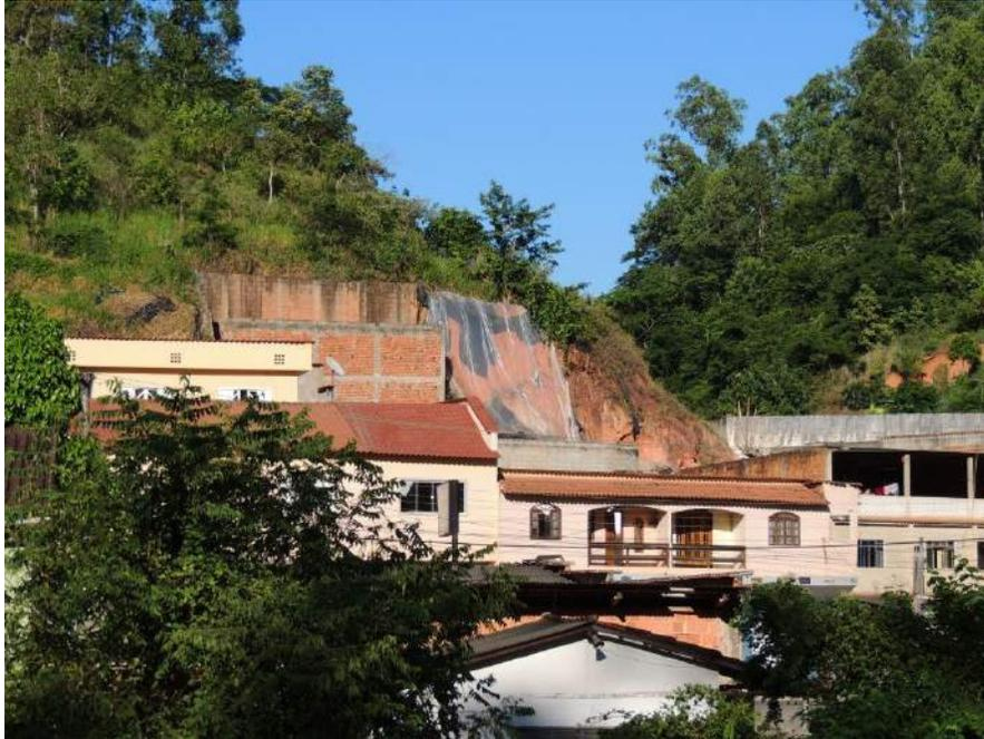
**Foto 49** - Vista parcial da encosta que compõe o setor com detalhe para trecho rompido e ação paliativa de proteção com uso de lona plástica.
