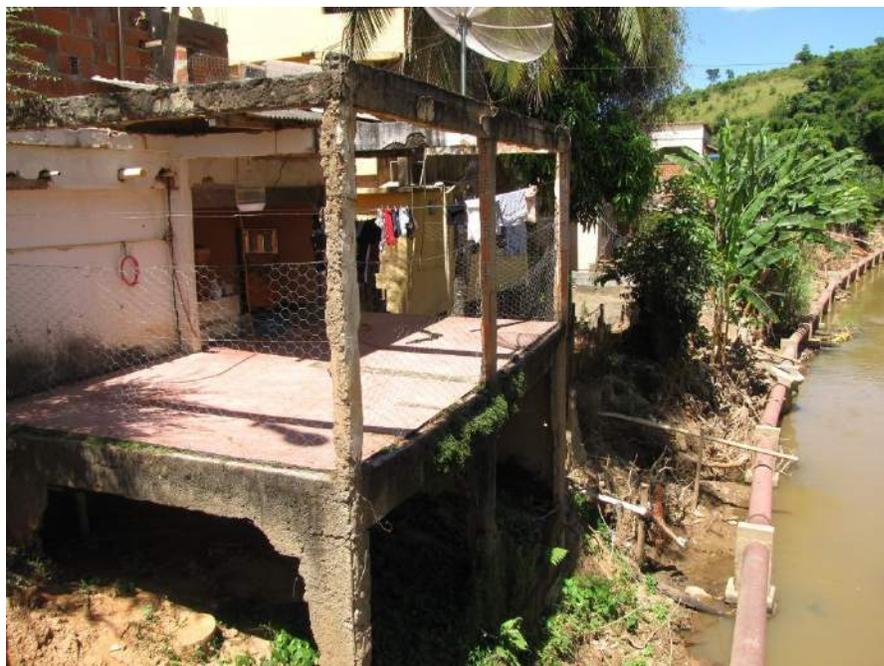
**Foto 114** - Domicílios construídos adjacentes ao canal fluvial em trecho suscetível a inundação e solapamentos de margem.
