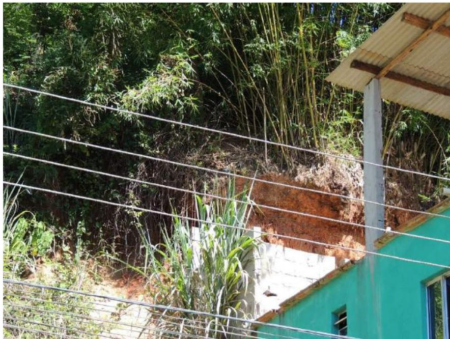
**Foto 88** - Vista aproximada em relação a foto anterior com detalhe para corte executado na base de bambuzal instabilizando o talude.
