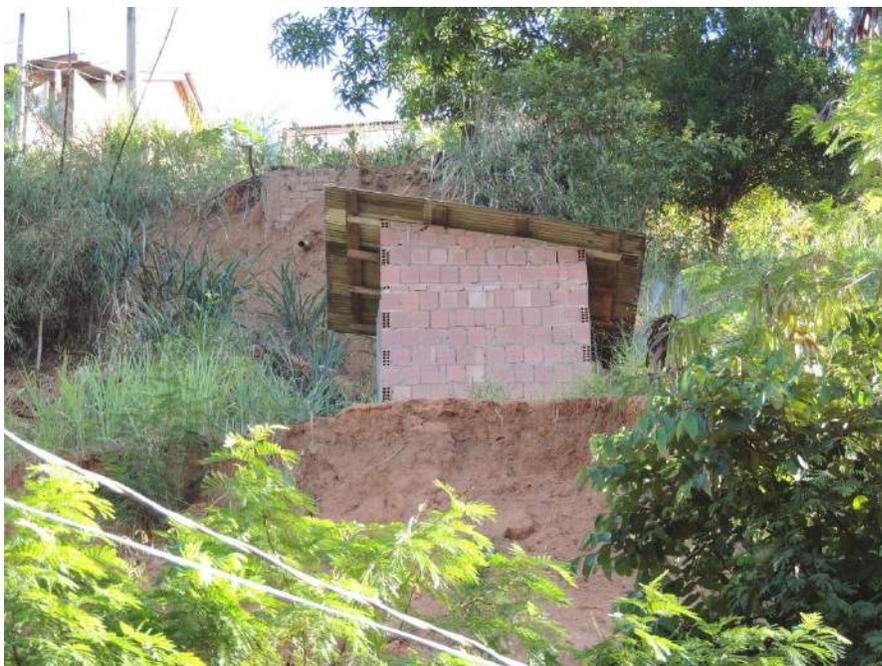
**Foto 76** - Talude instável e baixo padrão construtivo ao longo do setor.
