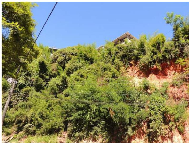
**Foto 84** - Vista parcial da encosta que compõe o setor de risco com detalhe para os indício de movimentos de massa anteriores.
