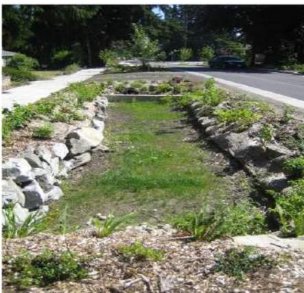
**Figura 3-9:** Trincheira de infiltração.
