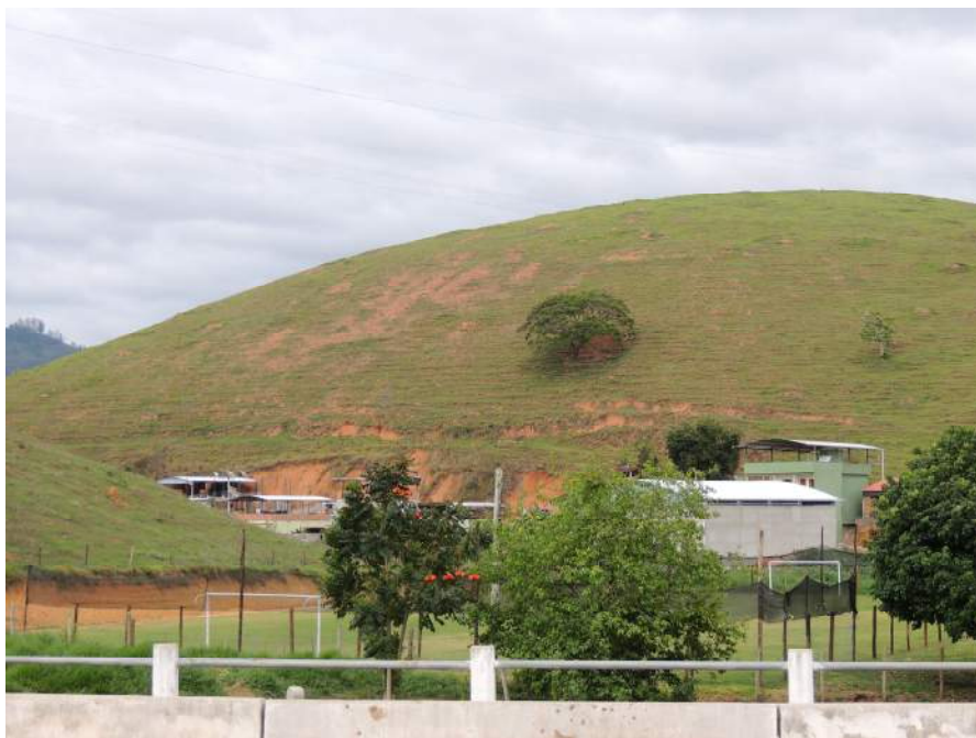
Foto 36 – Vista do início do Bairro Prainha com ocupações ao longo da base da encosta, a partir de cortes verticalizados não contidos.
