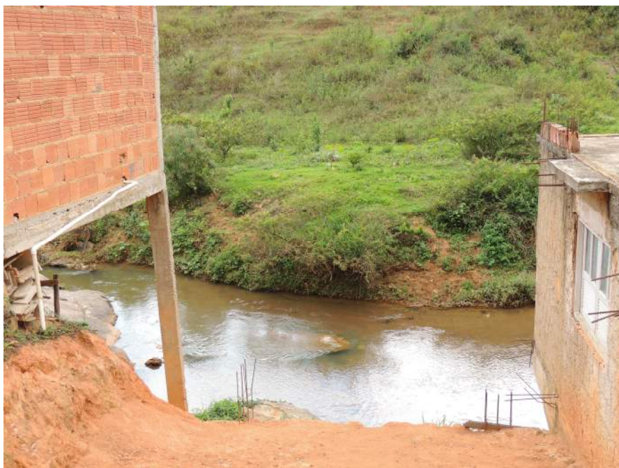
Foto 39 – Detalhe para o trecho ocupado as margens do canal com suscetibilidade a solapamentos.
