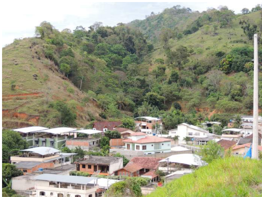
Foto 54 – Trecho da encosta com ocorrência de blocos rochosos sobre solo em terreno muito inclinado.
