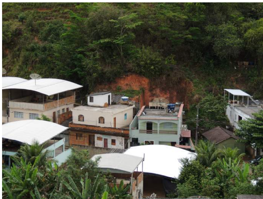
Foto 58 – Talude de corte e avanço dos domicílios em relação à encosta.
