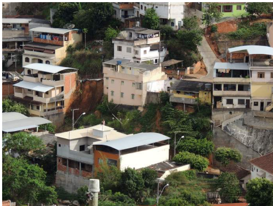
Foto 14 – Vista frontal do setor de risco que retrata áreas onde já ocorreu deslizamento.
