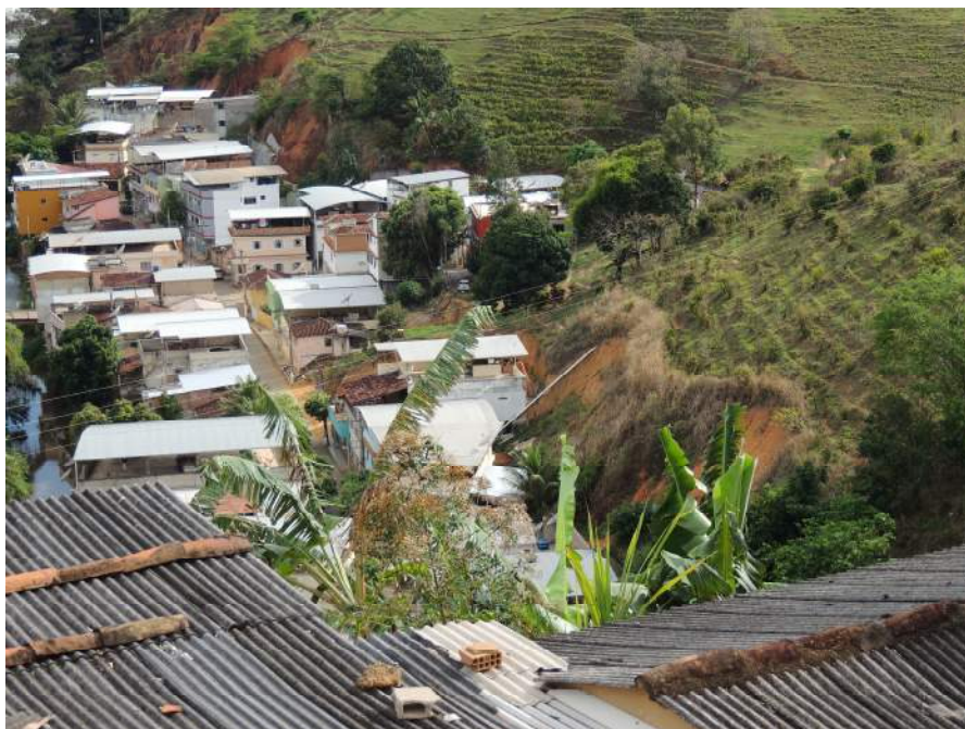
Foto 7 – Vista de montante para jusante do setor de risco com detalhe para os taludes de corte gerados com angulações inadequadas e instáveis.
