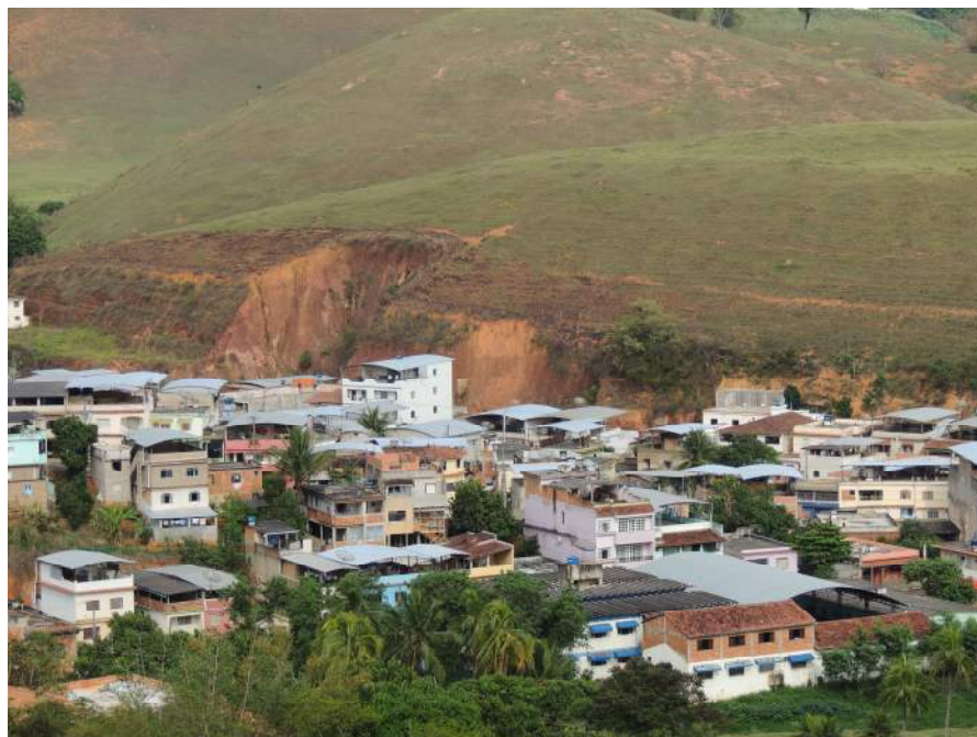
Foto 26 – Vista frontal de parte do setor de risco com detalhe para a geometria e altura dos taludes de corte.
