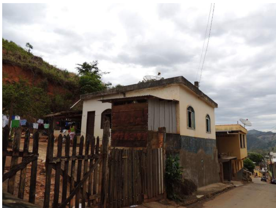
Foto 69 – Vista de outros domicílios com as mesmas tipologias de ocupação.
