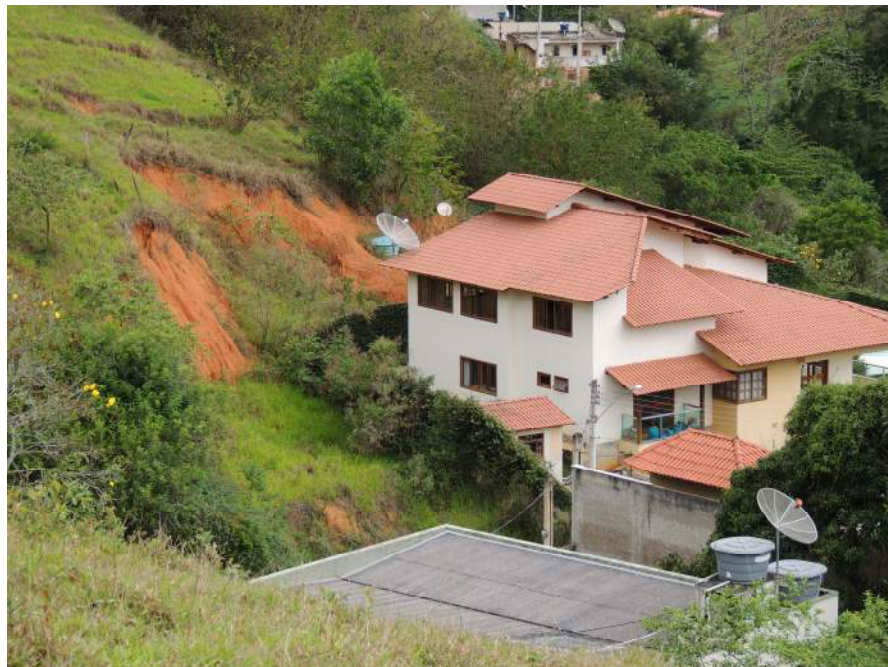
Foto 57 – Domicílio de bom padrão construtivo e taludes de corte nos fundos que devem ser monitorados.
