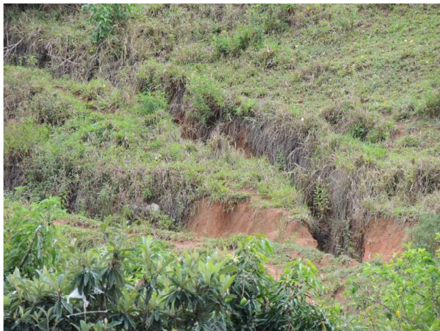
Foto 50 – Feição erosiva e trinca ao longo da encosta a montante do setor de risco.
