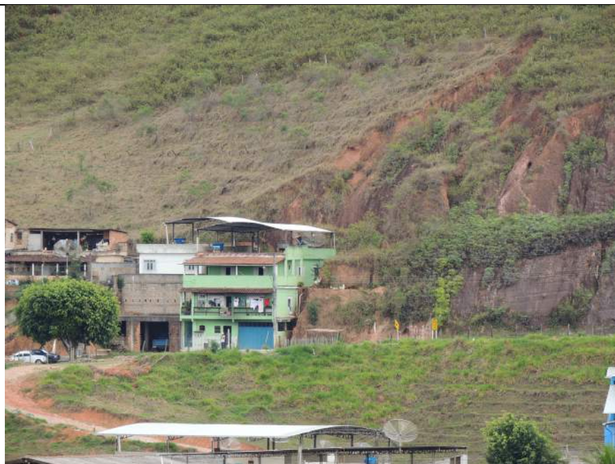
Foto 43 – Vista frontal do setor de risco. Notar os indícios de movimentos de massa ao longo da encosta a montante do domicílio.
