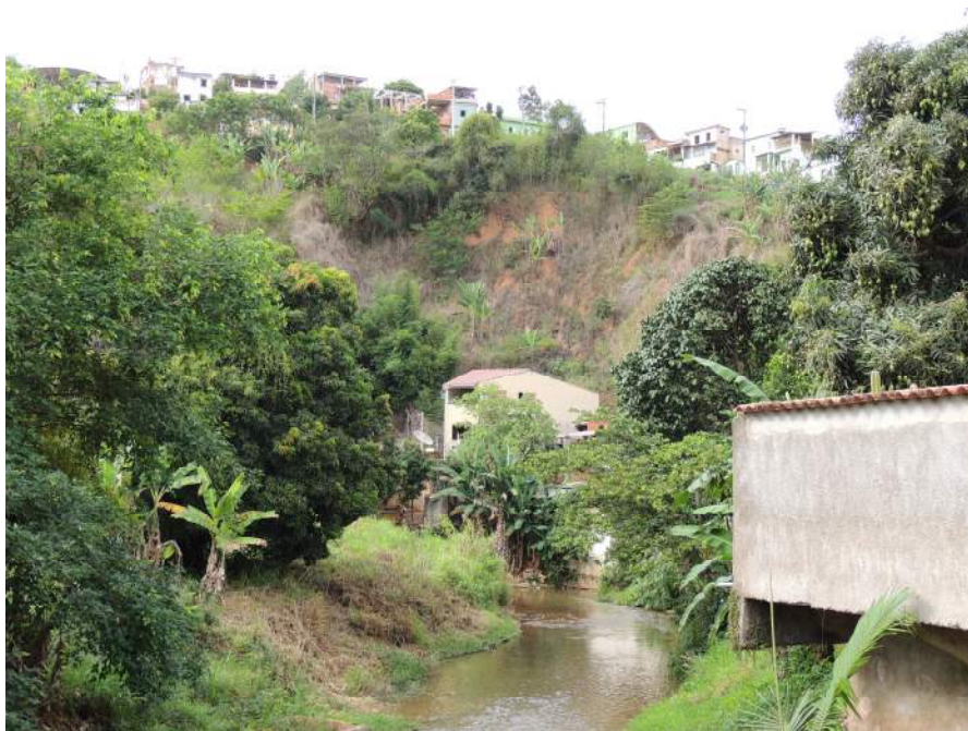
Foto 11 – Trecho do setor referente que retrata a encosta instável e ocupação da crista e a ocupação as margens do canal em trecho com suscetibilidade alta a solapamentos (erosão de margem).
