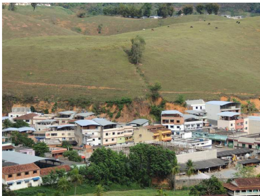
Foto 27 - Vista frontal de parte do setor de risco com detalhe para a geometria e altura dos taludes de corte.
