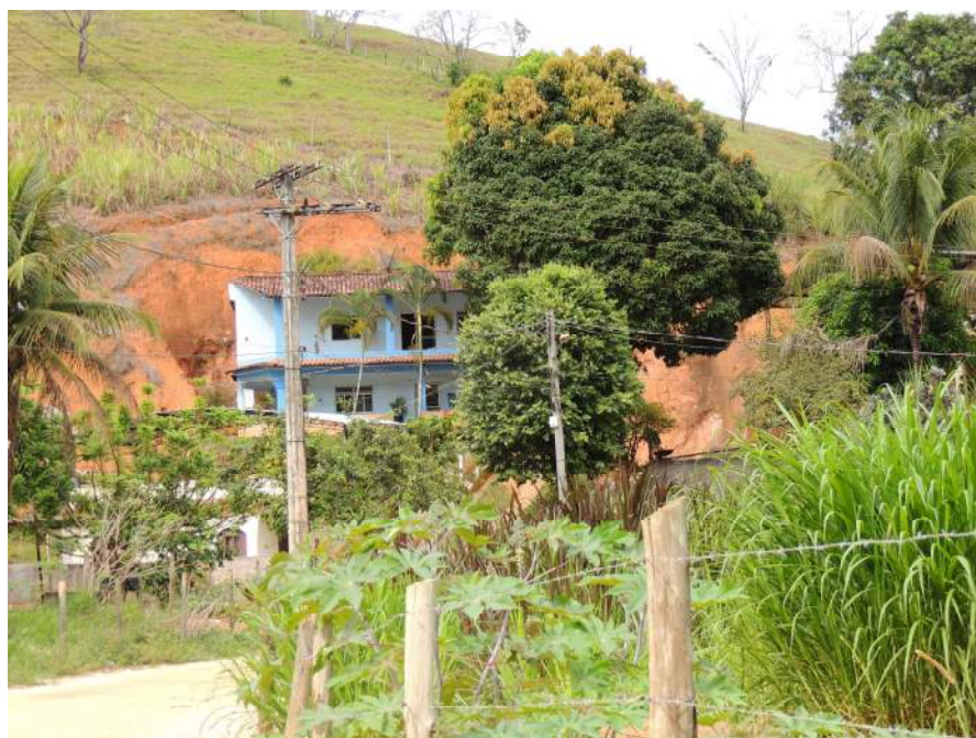
Foto 35 – Ocupação afastada em relação ao final dos bairros. Talude de corte com altura superior a 8,0m vertical com indícios iniciais de movimentos de massa.
