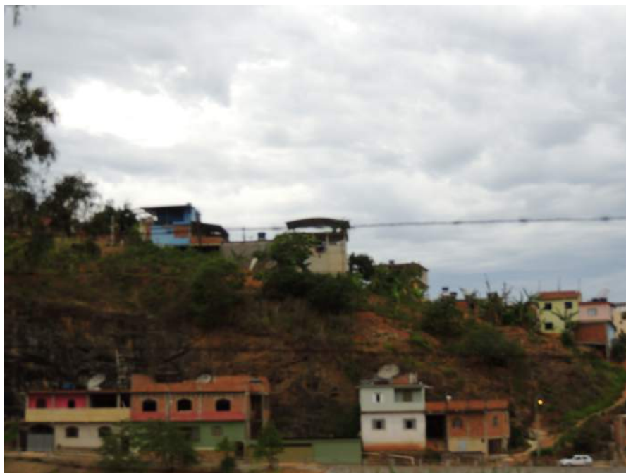
Foto 64 – Vista frontal do setor com transição entre talude vertical rochoso e camada superficial de solo alterado.
