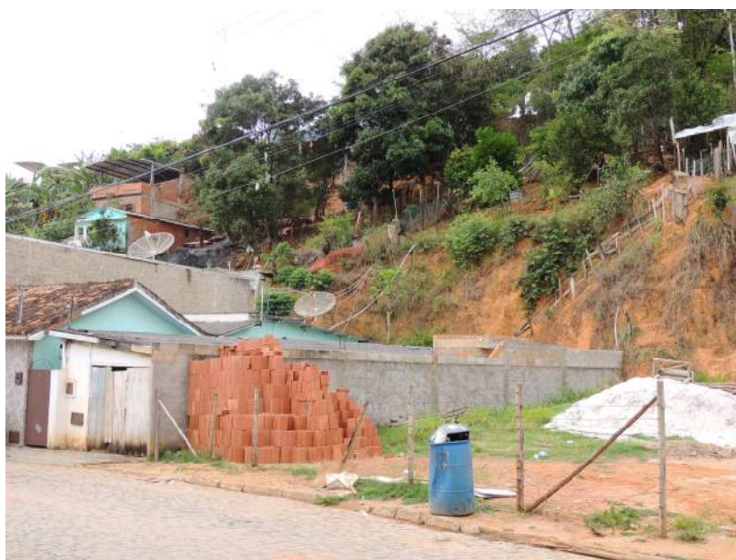
Foto 40 – Vista frontal do setor de risco médio com detalhe para o talude de corte muito próximo ao domicílio.
