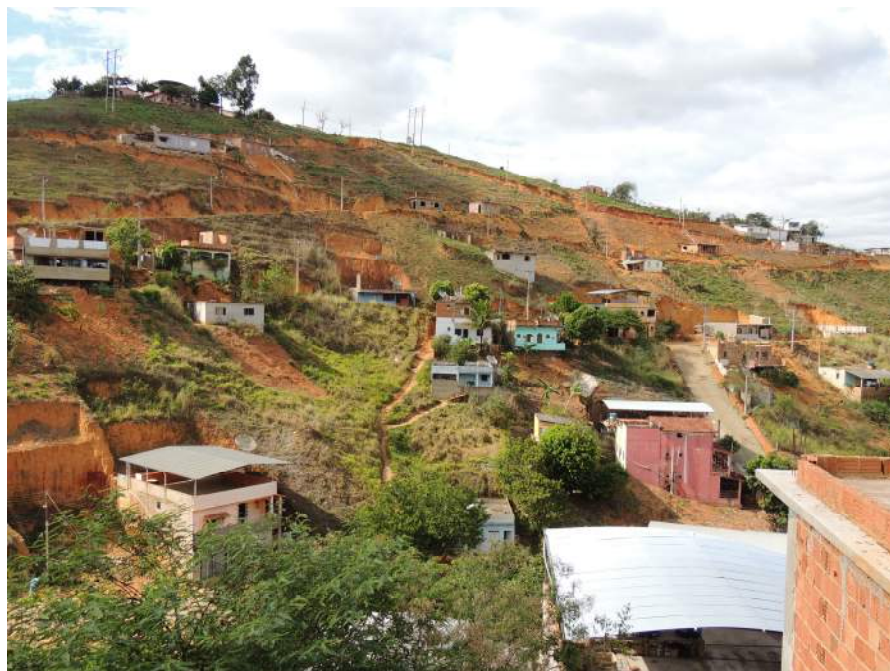
Foto 22 - Vista parcial do setor de risco que se trata de um bairro com infraestrutura deficitária e com processos de ocupação em andamento. Cortes verticalizados não estabilizados e sistema de drenagem inexistente.
