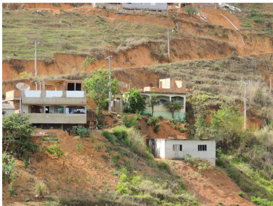
Foto 23 – Detalhe para novos domicílios de baixo padrão e taludes de corte verticais nos fundos.
