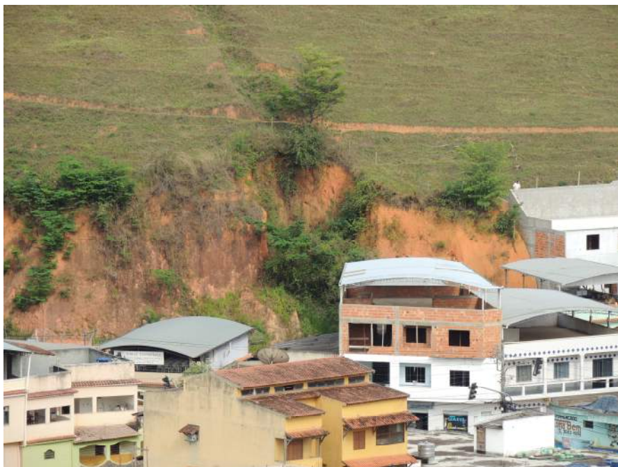
Foto 28 – Vista aproximada com detalhe para a geometria e altura dos taludes de corte.
