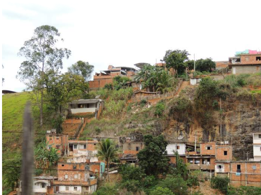
Foto 66 – Vista complementar do setor de risco.
