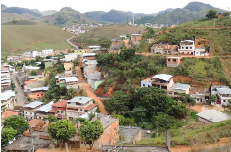
Foto 18 – Vista parcial do setor de risco que se trata de um bairro com infraestrutura deficitária e com processos de ocupação em andamento. Cortes verticalizados não estabilizados e sistema de drenagem inexistente.
