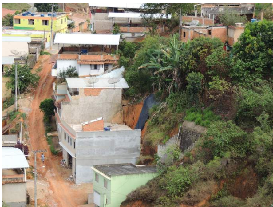
Foto 19 – Detalhe em relação à foto anterior em relação a cortes verticais instáveis nos fundos de um domicílio.
