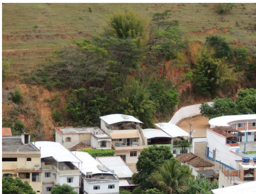
Foto 48 – Domicílios de médio padrão construtivo e taludes de corte com indícios de instabilidade.
