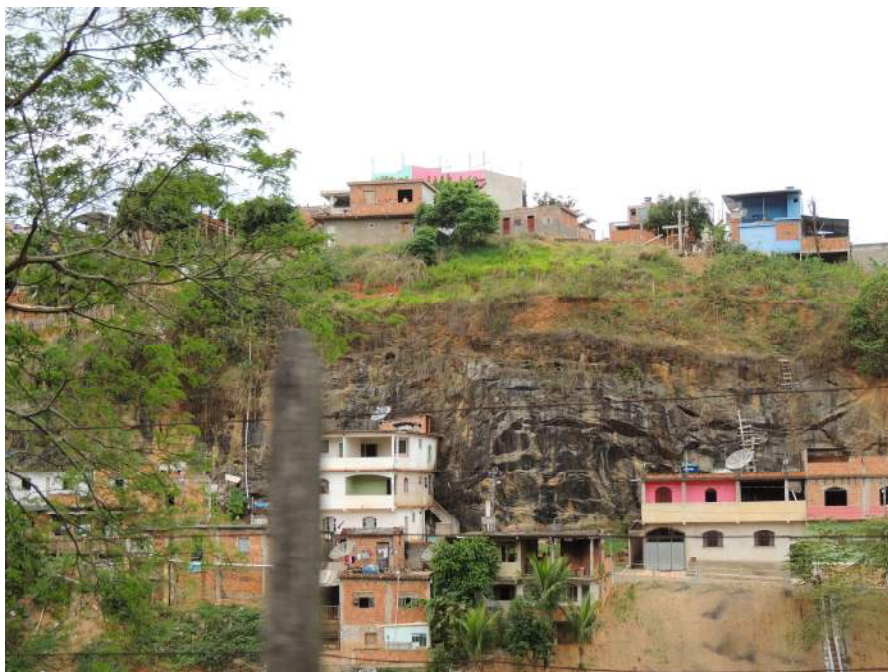
Foto 65 – Vista complementar da área com as relação solo residual no topo permeável e base rochoso impermeável.
