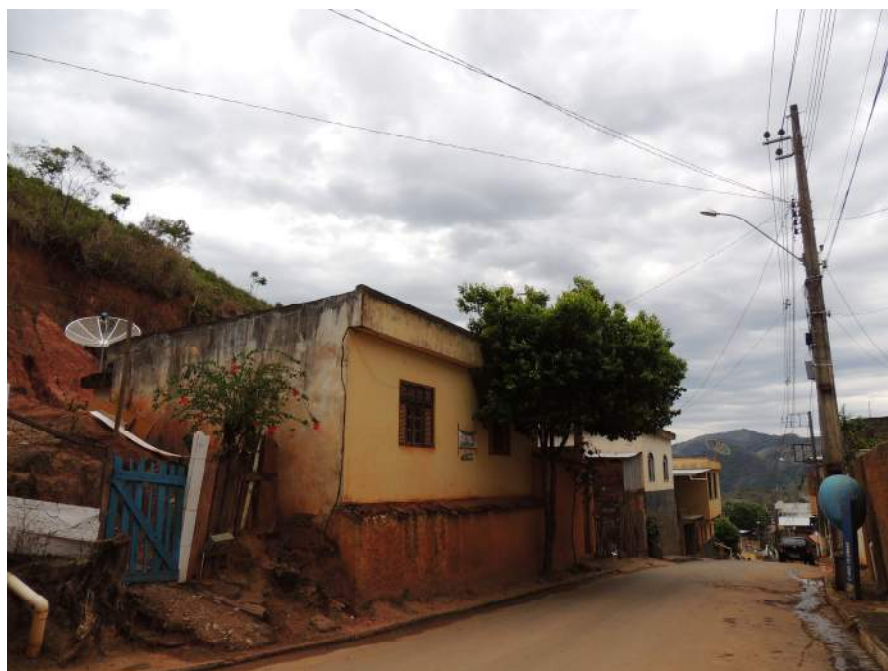
Foto 67 – Domicílio de baixo padrão construtivo e talude de corte nos fundos.
