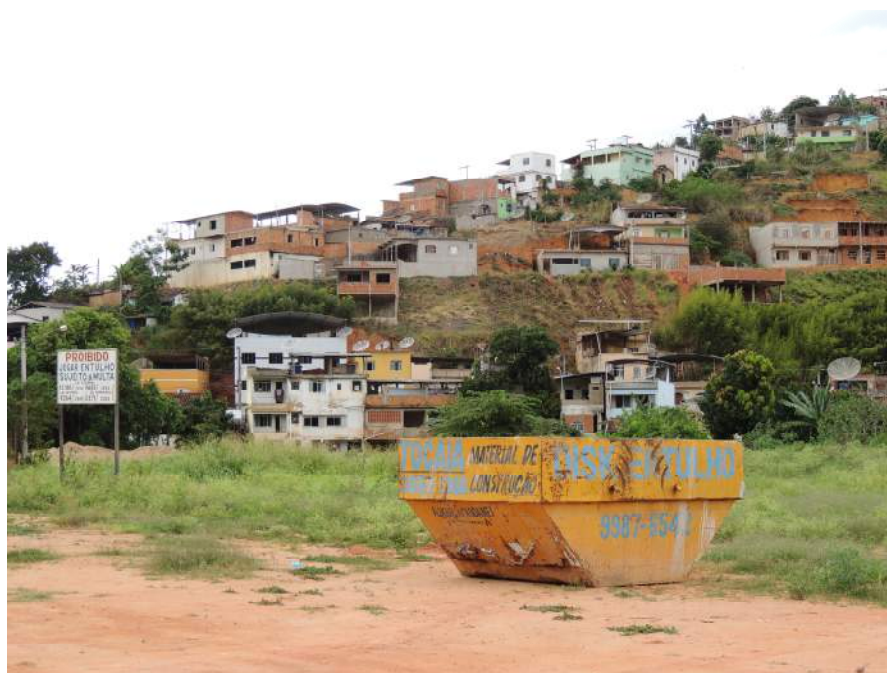
Foto 33 – Vista frontal do setor de risco que se refere à base do setor na rua Misael de Paiva.
