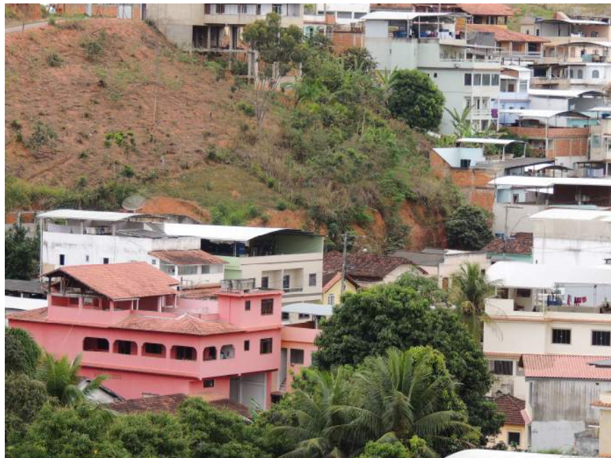
Foto 46 – Vista frontal do setor de risco com detalhe para o talude de corte não contido nos fundos dos domicílios.
