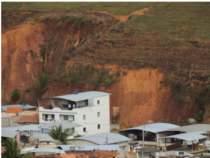
Foto 29 - Vista aproximada com detalhe para a geometria e altura dos taludes de corte. Notar feições erosivas, cicatrizes de deslizamento e pequenos degraus de abatimento ao longo da encosta.
