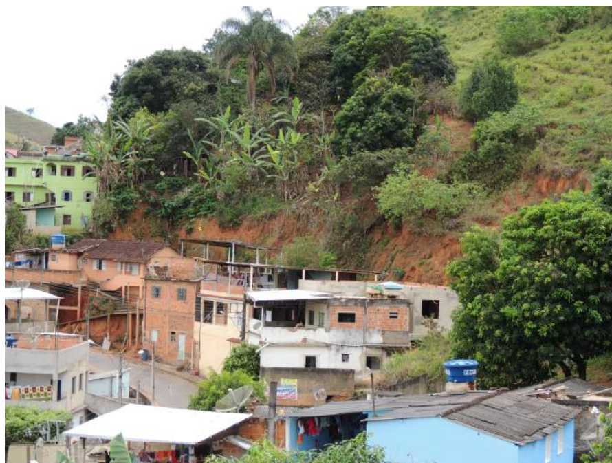
Foto 49 – Domicílios de baixo padrão construtivo, indícios de instabilidade e evidência de movimentos de massa ao longo da encosta a montante do setor.
