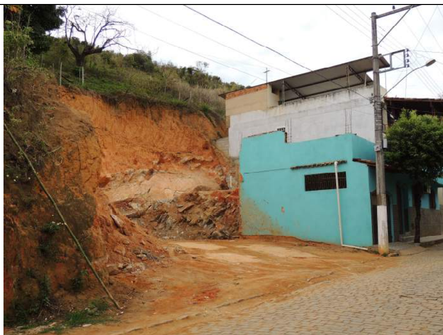
Foto 6 – Vista parcial do setor com detalhe para talude de corte em solo sobre rocha e novo lote que será ocupado.
