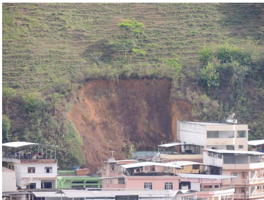
Foto 47 – Detalhe para a dimensão do talude de corte em relação aos domicílios que compõem o setor.
