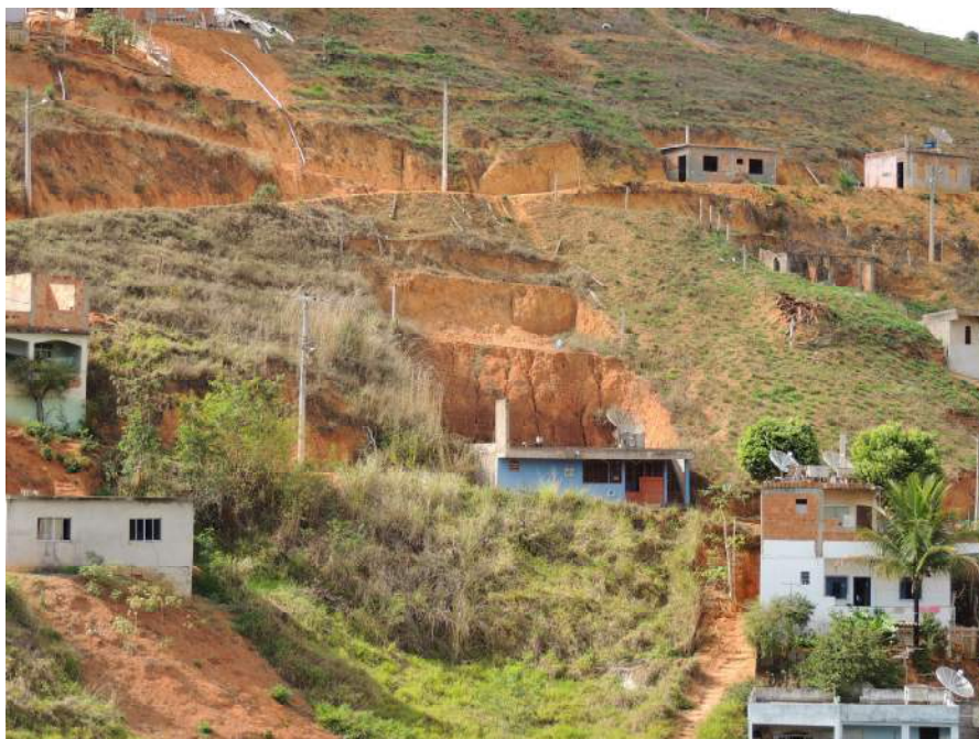
Foto 24 – Notar dimensões do talude de corte não estabilizados em relação ao domicílio na cor azul que compõem o setor.
