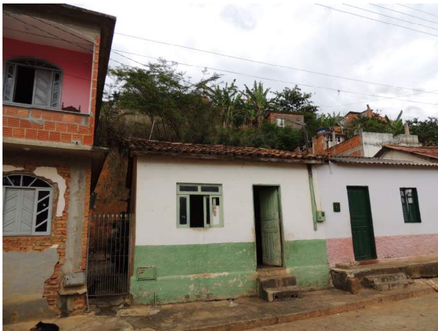
Foto 41 – Detalhe para o padrão construtivo dos domicílios e o a talude de corte nos fundos.
