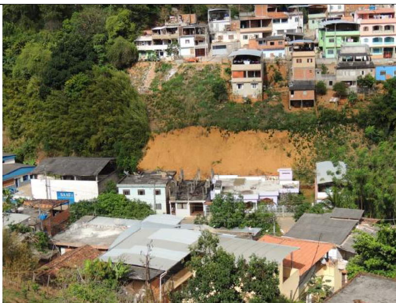
Foto 30 – Vista frontal do setor de risco. Encosta com amplitude superior a 25,0m e sem cobertura vegetal.
