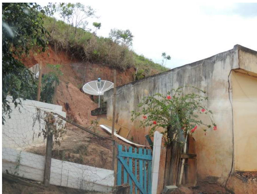
Foto 68 – Detalhe em relação à instabilidade nos fundos do domicílio.
