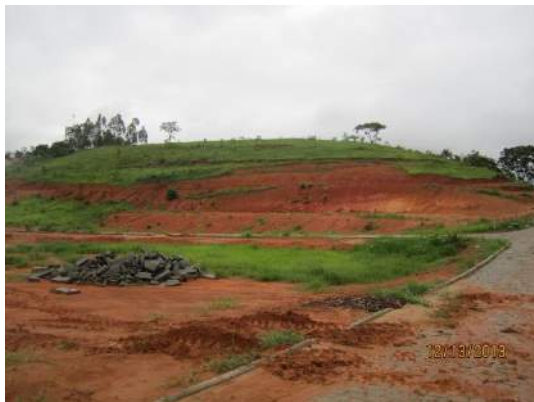
Figura 4-12: Área do loteamento Brilhante de onde foi retirado material para o aterro do talvegue.
