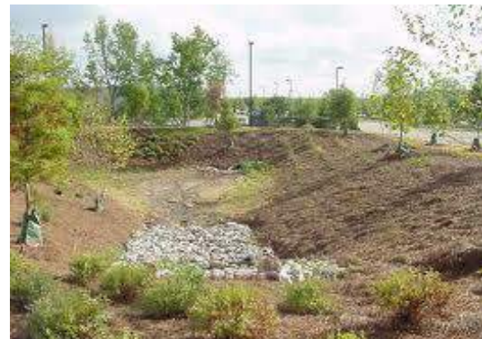
Figura 7-15: Bacia de detenção.
