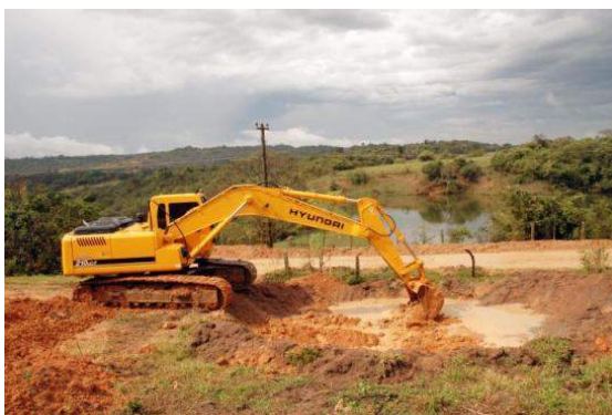
Figura 7-4: Implantação de uma bacia de contenção às margens de uma estrada vicinal
