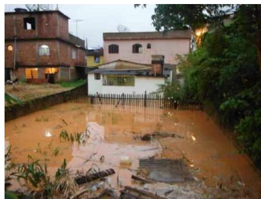
Figura 4-10: Inundação no loteamento do Juninho em Dezembro de 2013.
