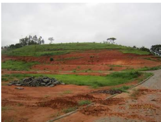
Figura 6-15: Área do loteamento Brilhante de onde foi retirado material para o aterro do talvegue.
