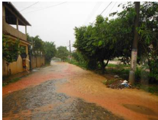
Figura 6-18: Inundação no loteamento brilhante durante as chuvas de dezembro de 2013.
