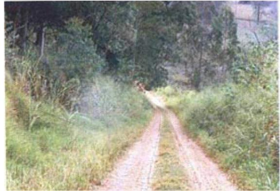
**Figura 3-5:** Taludes de corte e aterro e áreas não transitáveis recobertos com espécies herbáceas em estrada vicinal.
