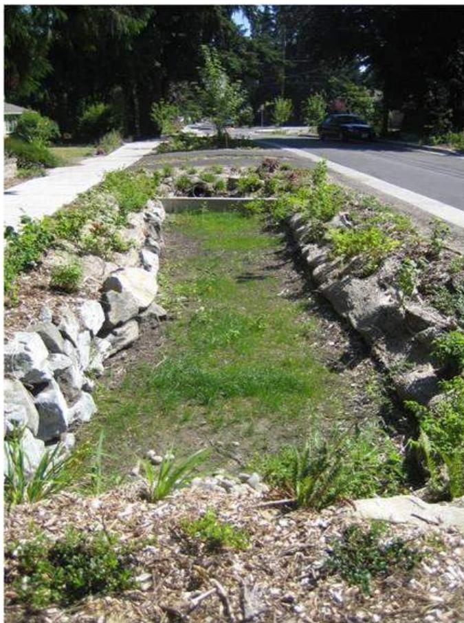
**Figura 3-9:** Trincheira de infiltração.
