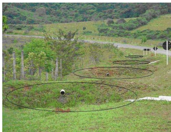
**Figura 7-3:** Bacias de contenção instaladas às margens de rodovia pavimentada.
