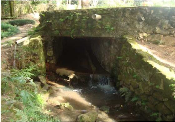
**Figura 6-9.** Galeria do Córrego Schlenz lançando águas em canal aberto. Vista montante.
