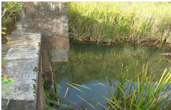
**Figura 7-23:** Estrutura do barramento existente no córrego Schlenz.
