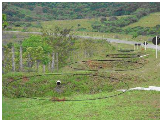
Figura 3-3: Bacias de contenção instaladas às margens de rodovia pavimentada.
