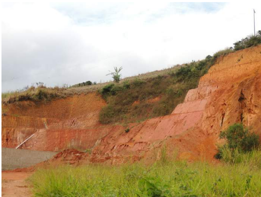
Foto 30 - Vista parcial do setor de risco. Detalhe para a altura dos taludes de corte e inclinação acentuada dos mesmos.
