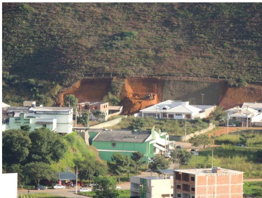
Foto 14 - Vista parcial do setor de risco. Detalhe para a altura dos taludes de corte e inclinação acentuada dos mesmos.
