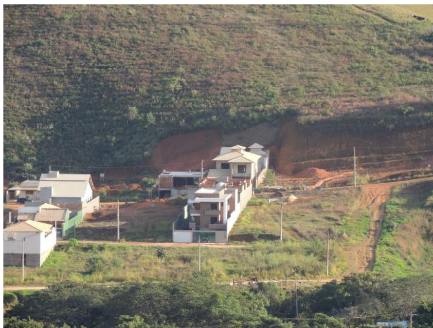
Foto 16 - Vista parcial do setor de risco. Detalhe para a altura dos taludes de corte e inclinação acentuada dos mesmos.
