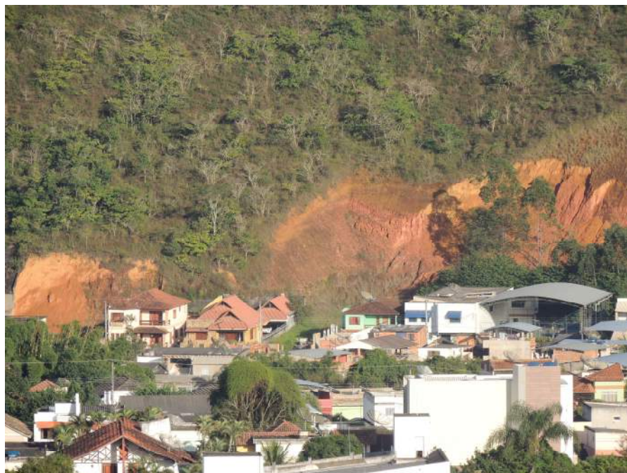
Foto 7 - Vista parcial do setor de risco. Detalhe para a altura dos taludes de corte e inclinação acentuada dos mesmos.
