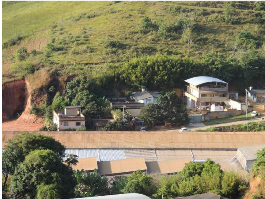
Foto 20 – Vista complementar do setor de risco com ocorrência de pequenos movimentos de massa registrado no local.
