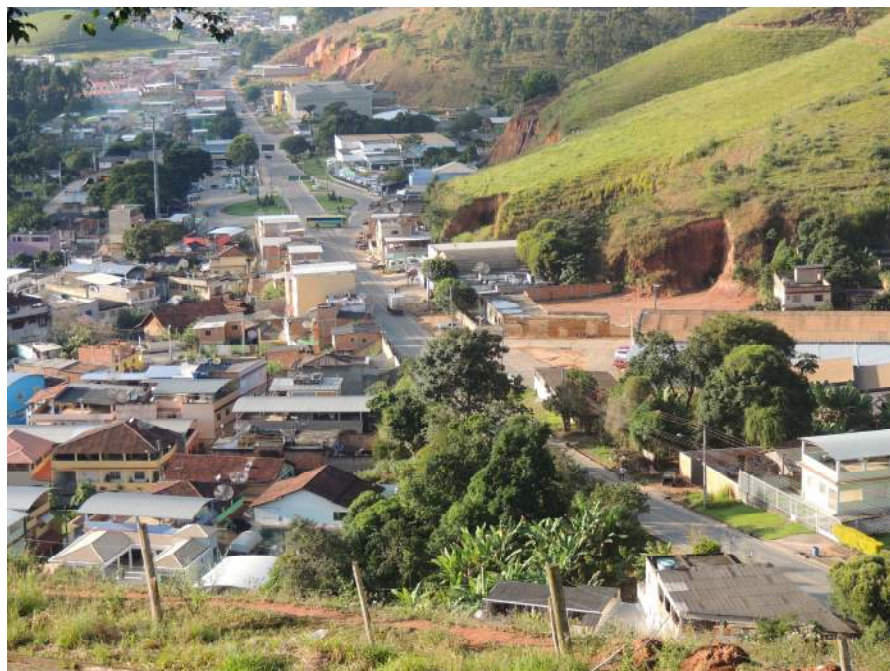
Foto 32 - Vista parcial do setor de risco. Detalhe para a altura dos taludes de corte e inclinação acentuada dos mesmos.
