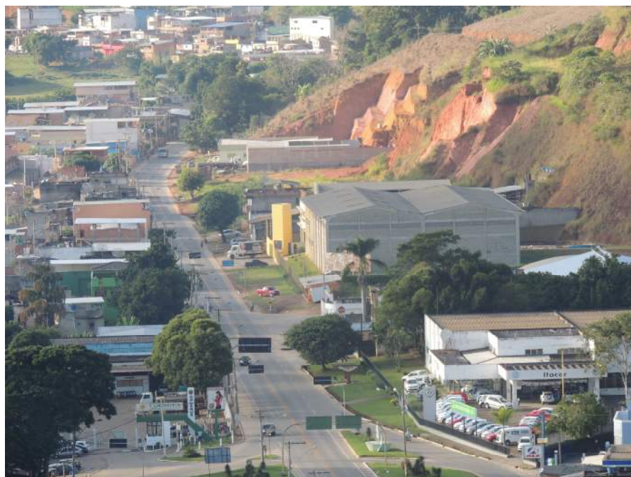
Foto 33 - Vista parcial do setor de risco. Detalhe para a altura dos taludes de corte e inclinação acentuada dos mesmos.
