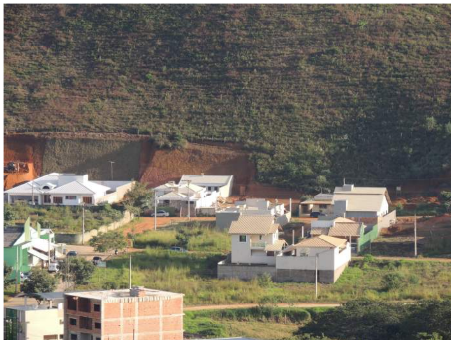
Foto 15 - Vista parcial do setor de risco. Detalhe para a altura dos taludes de corte e inclinação acentuada dos mesmos.
