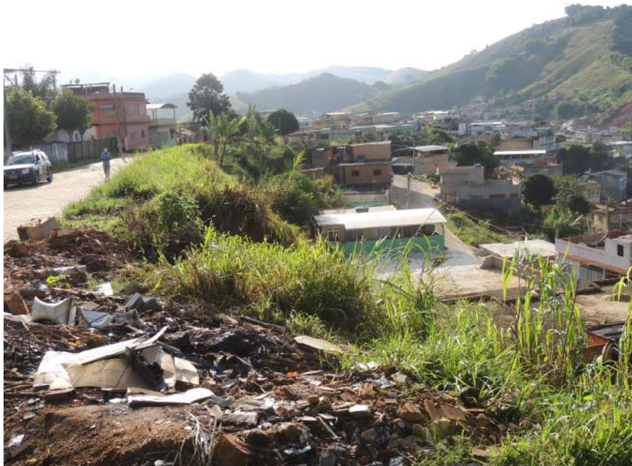
Foto 24 – Lançamento de lixo e entulho ao longo da crista. Detalhe para o talude de corte nos fundos dos domicílios.
