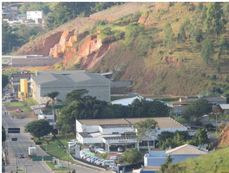
Foto 34 - Vista parcial do setor de risco. Detalhe para a altura dos taludes de corte e inclinação acentuada dos mesmos.
