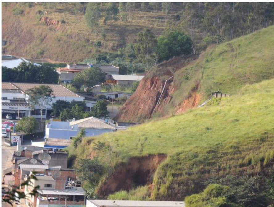
Foto 36 – Indícios de instabilidade ao longo da encosta que compõem o setor.
