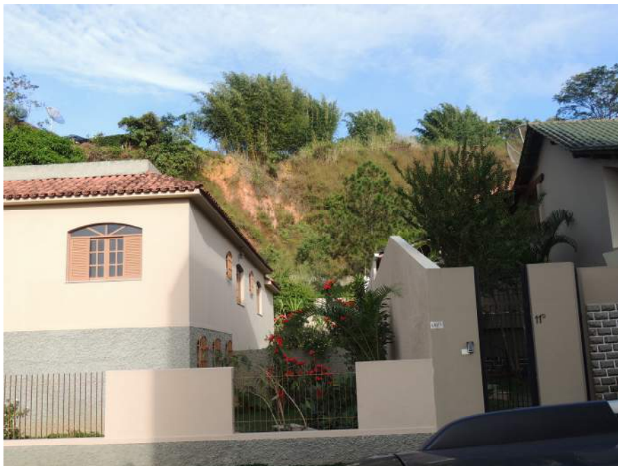
Foto 11 – Vista a partir da base do setor com detalhe para os indícios de instabilidade ao longo da encosta.
