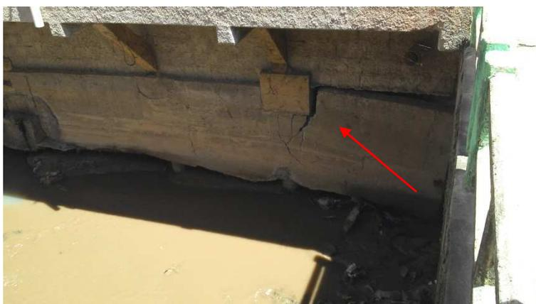
**Figura 4-13:** Muro de concreto para proteção da fundação da edificação localizada na ponte da Rua Michel Chequer. Detalhe para a rachadura causada pela força da água.
