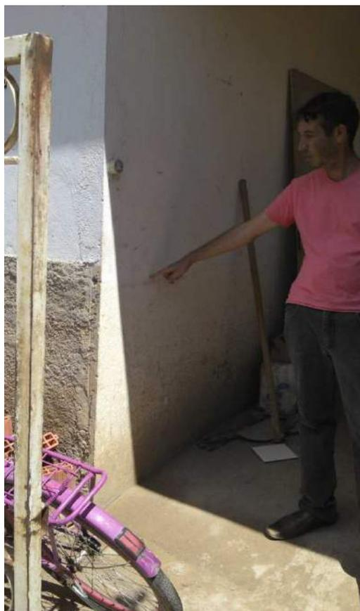
**Figura 4-15:** Marca d'água da enchente de dezembro de 2010 em uma edificação da Rua Manoel Trindade.
