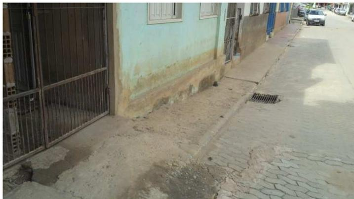
**Figura 4-16:** Marca d'água da enchente de dezembro de 2010 em uma edificação da Rua Nancife Alcure.
