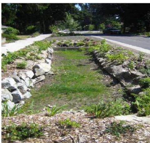
**Figura 7-13:** Trincheira de infiltração.
