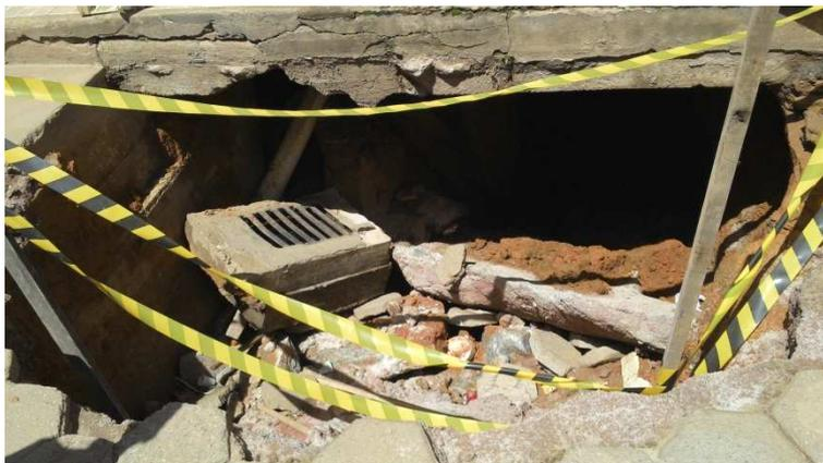
**Figura 4-14:** Efeito do escoamento d'água através do muro de proteção defeituoso.
