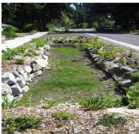
**Figura 7-13:** Trinchera de infiltração.
