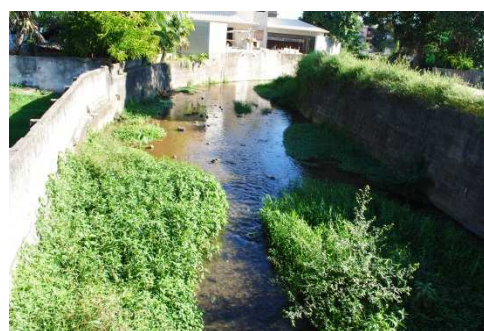
Figura 6-11: Trecho do canal do córrego São Caetano com processo avançado de assoreamento.
