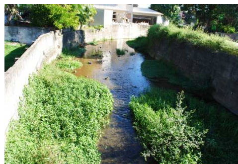
Figura 1-6: Trecho do canal do córrego São Caetano com processo avançado de assoreamento.
