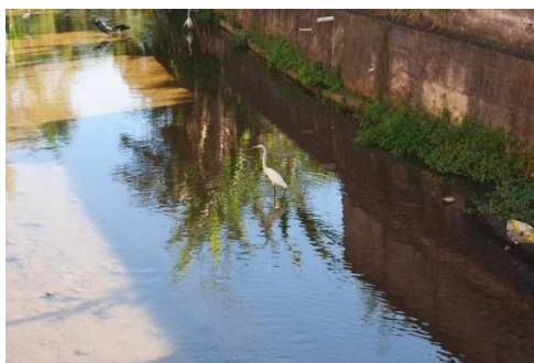
Figura 1-5: Trecho do canal do córrego Pau D'Alho com início de processo de assoreamento.
