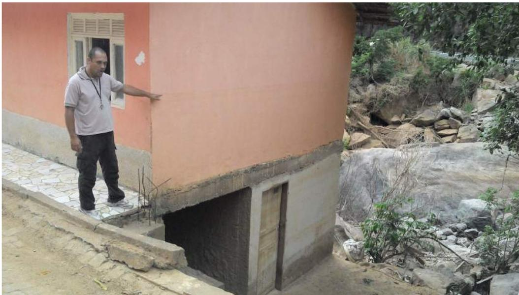
**Figura 6-17:** Marca d'água da última inundação (dezembro de 2013) em edificação a montante da OAE da ES-264.
