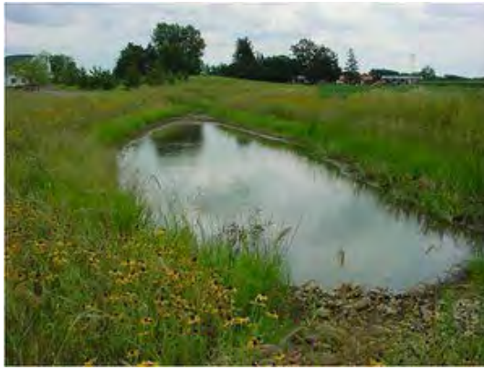
Figura 7-16: Bacia de retenção.
