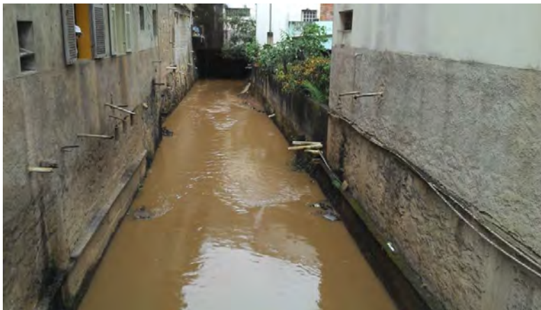
Figura 4-9: Trecho de canal aberto no Centro de Santa Teresa seguido por galeria abaixo de uma edificação.
