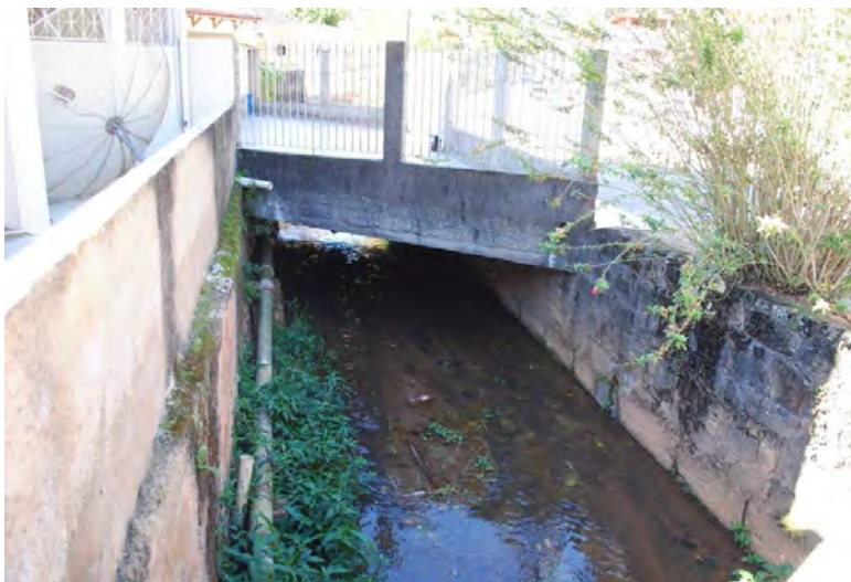
Figura 4-16: Trecho final do Valão São Pedro.
