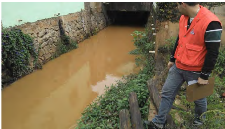
Figura 4-10: Saída de galeria do Valão São Lourenço.
