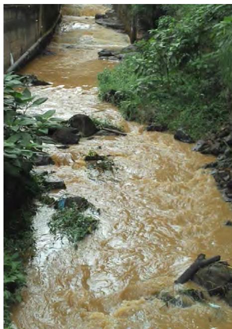
Figura 4-6: Trecho do canal do Valão São Lourenço com rochas soltas.
