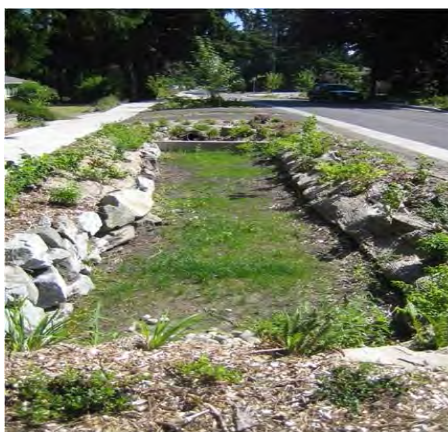
Figura 7-13: Trinchreira de infiltração.
