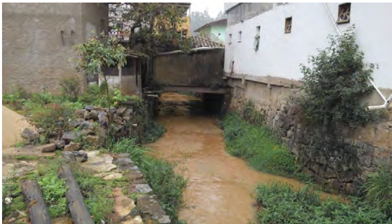
Figura 4-11: Trecho aberto do Valão São Lourenço. Detalhe para edificação construída sobre seu curso.
