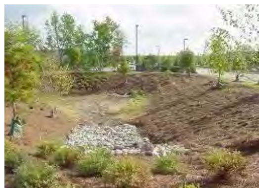
Figura 7-15: Bacia de retenção.
