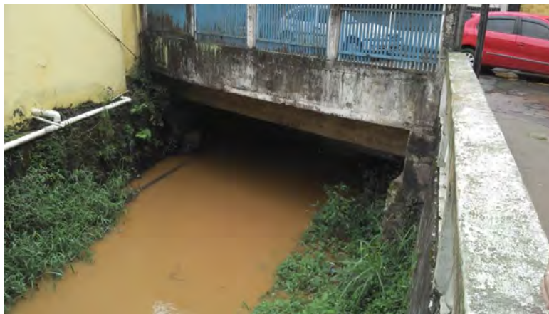
Figura 4-7: Ponte sobre o Valão São Lourenço próximo a um supermercado, no centro da cidade.
