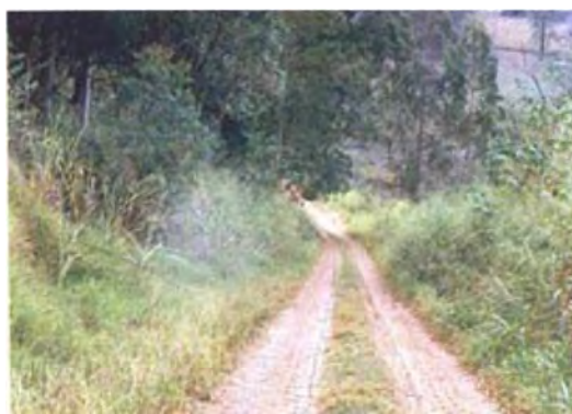
Figura 7-5: Taludes de corte e aterro e áreas não transitáveis recobertos com espécies herbáceas em estrada vicinal.
