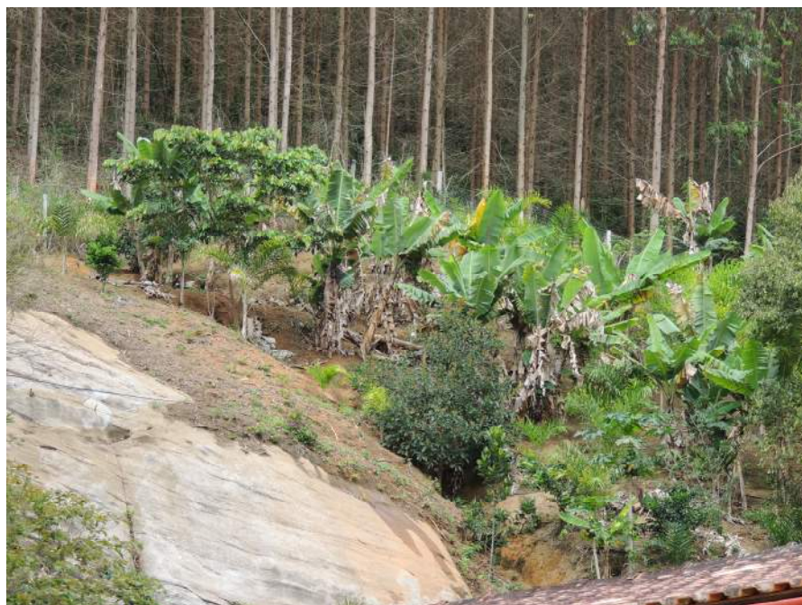
Foto 33 – Vista aproximada do contato. Área de maior instabilidade.
