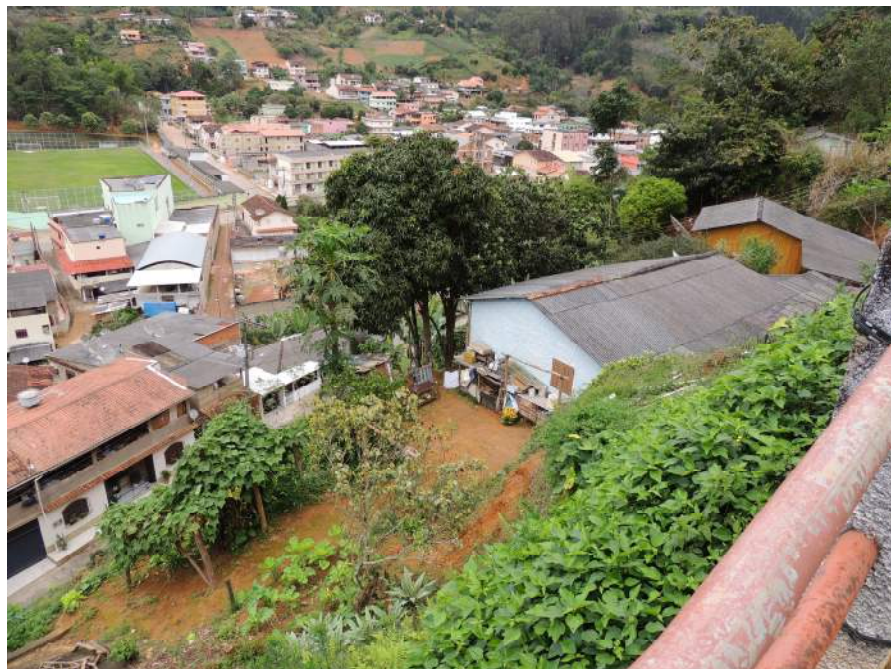
Foto 10 – Detalhe para o padrão construtivo ao longo do setor de risco.
