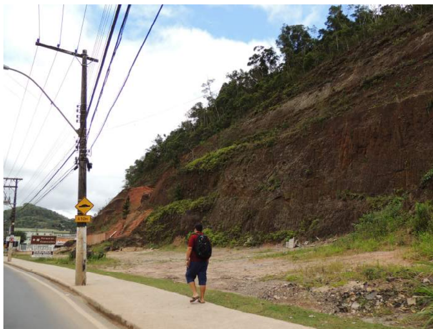
Foto 35 – Encosta com trechos onde já ocorrerem deslizamentos de grande porte.
