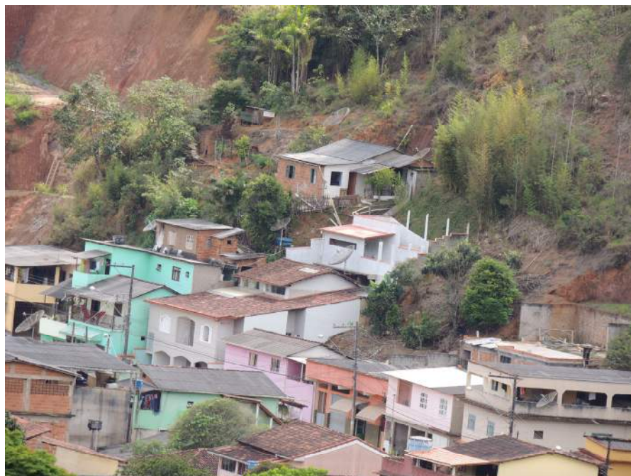
Foto 29 – Domicílios de baixo padrão construtivo e trechos instáveis da encosta.
