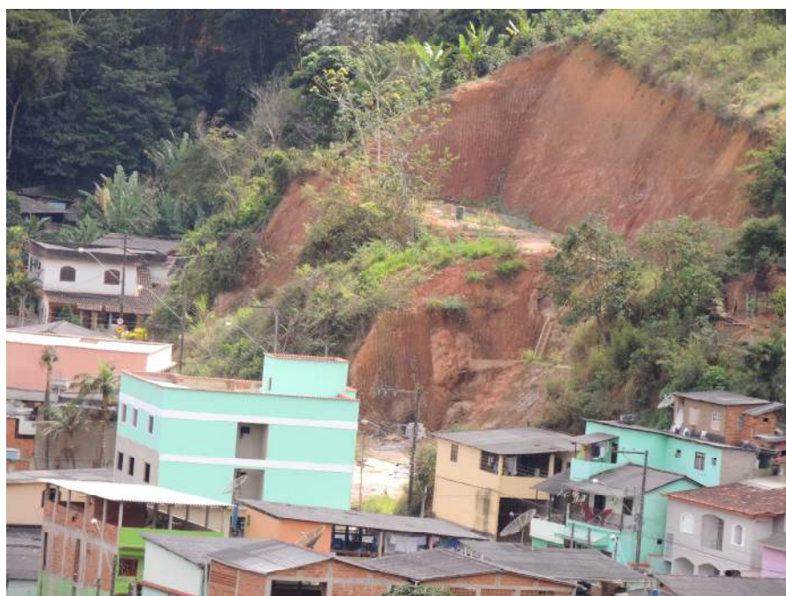
Foto 28 – Taludes de corte para novas construções.
