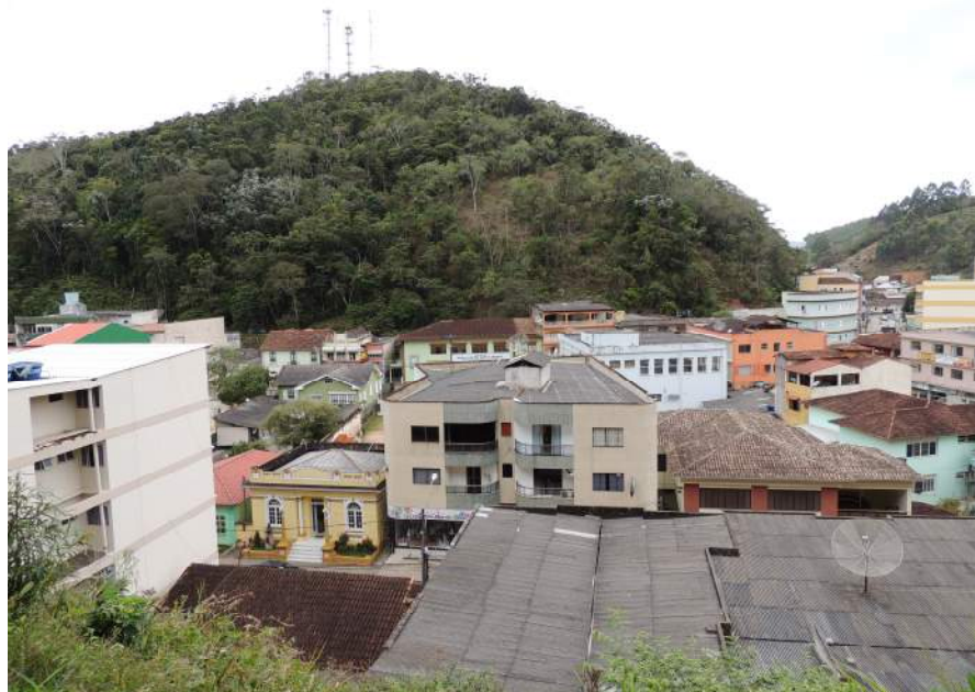
Foto 3.- Vista frontal do setor de risco. Encostada vegetada e ocupação ao longo da base.
