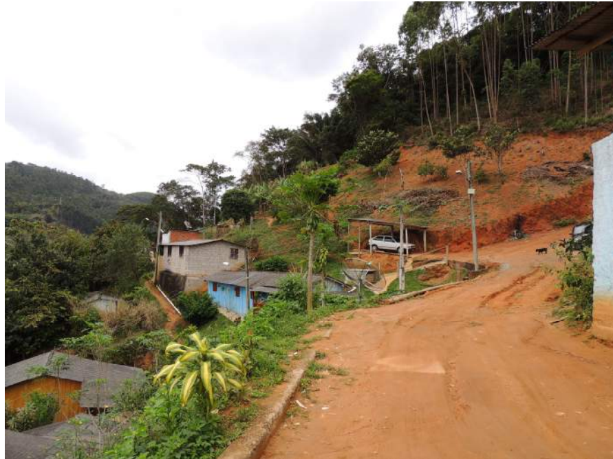
Foto 11 – Vista de parte do talvegue a da linha de drenagem ocupada.
