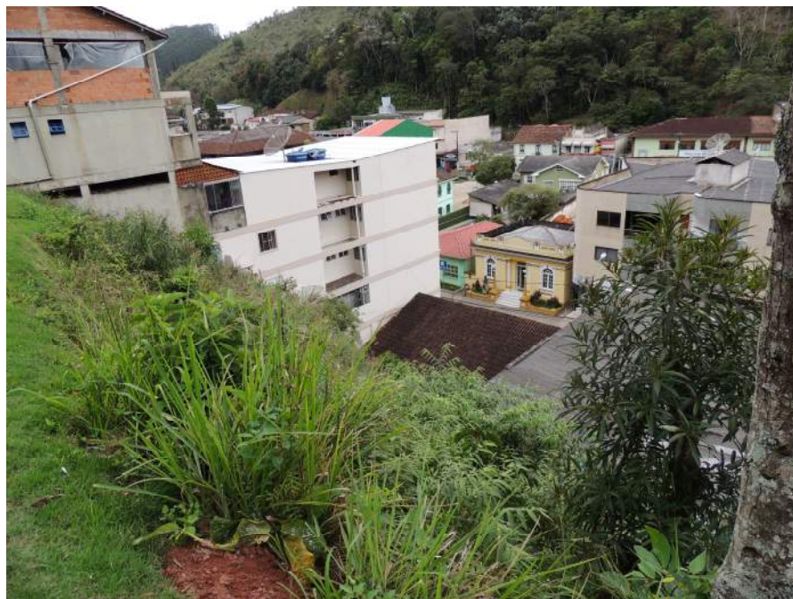
Foto 7 – Vista complementar do setor do setor de risco.
