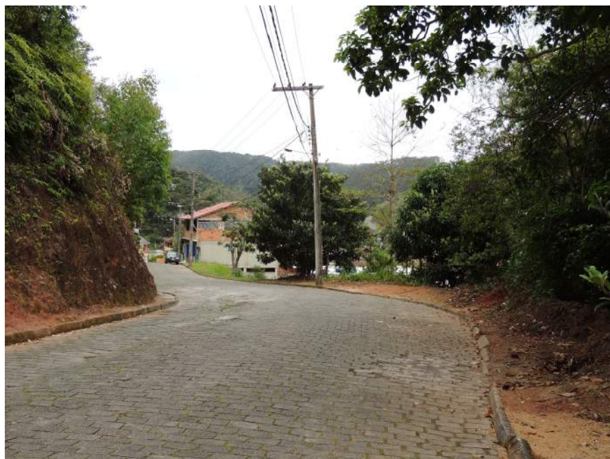
Foto 8 – Via de acesso no topo do setor de risco que controla o escoamento superficial.
