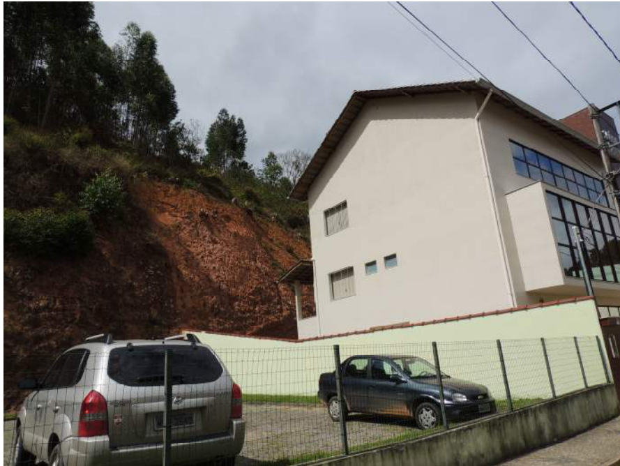
Foto 38 – Talude de corte vertical com altura de 10,0m.
