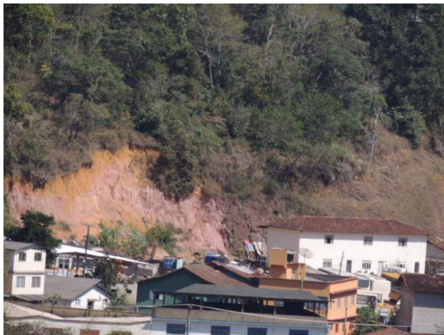
Foto 37 – Indícios de instabilidade ao longo da encosta e ocupação da base.
