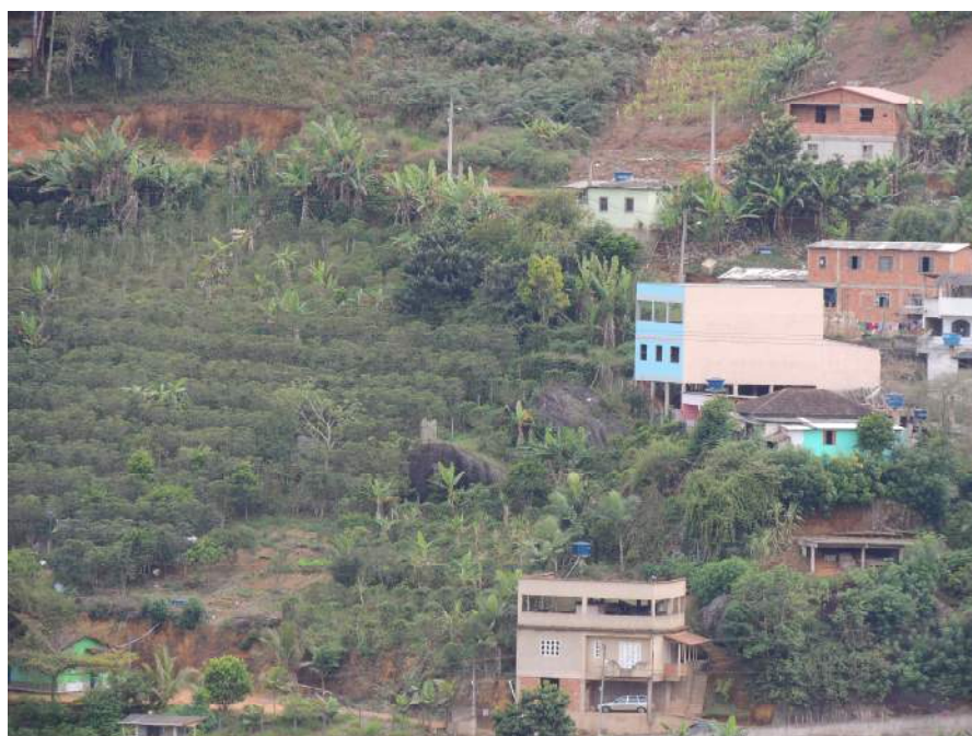
Foto 27 – Detalhe para os blocos rochosos ao longo da encosta.
