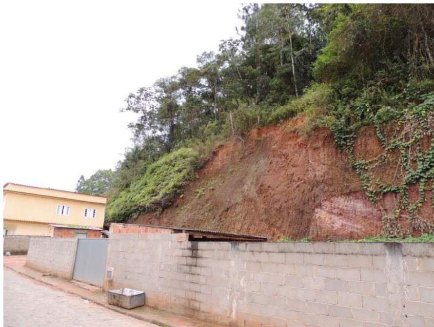
Foto 17 – Indícios de instabilidade ao longo do setor.
