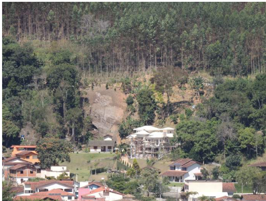
Foto 31 – Encosta íngreme e contato entre substrato rochoso são e impermeável e camada de solo delgada e permeável.
