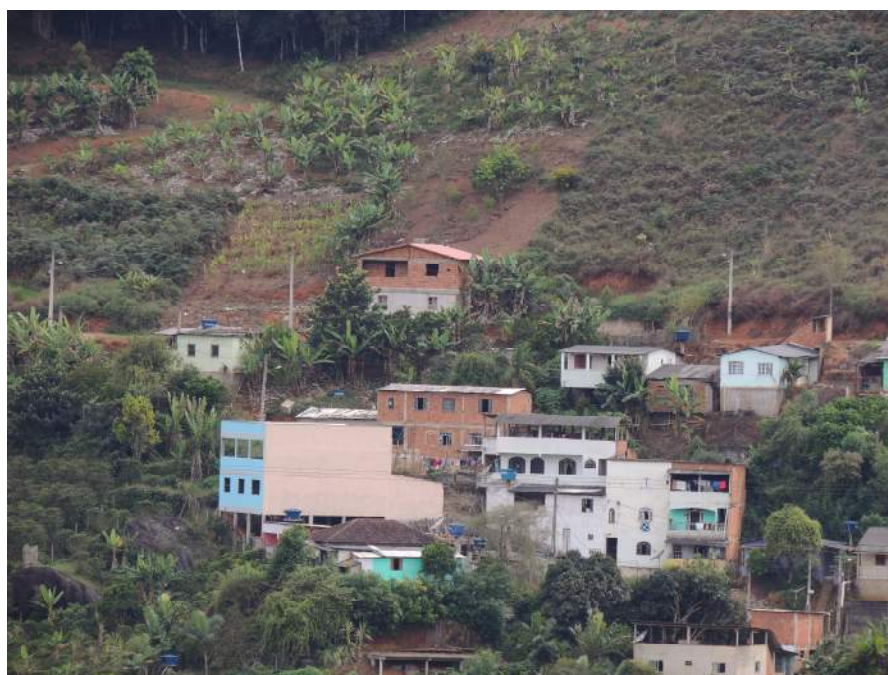
Foto 25 – Vista aproximada do setor. Talude de corte, blocos rochosos e indícios de movimentos de massa.
