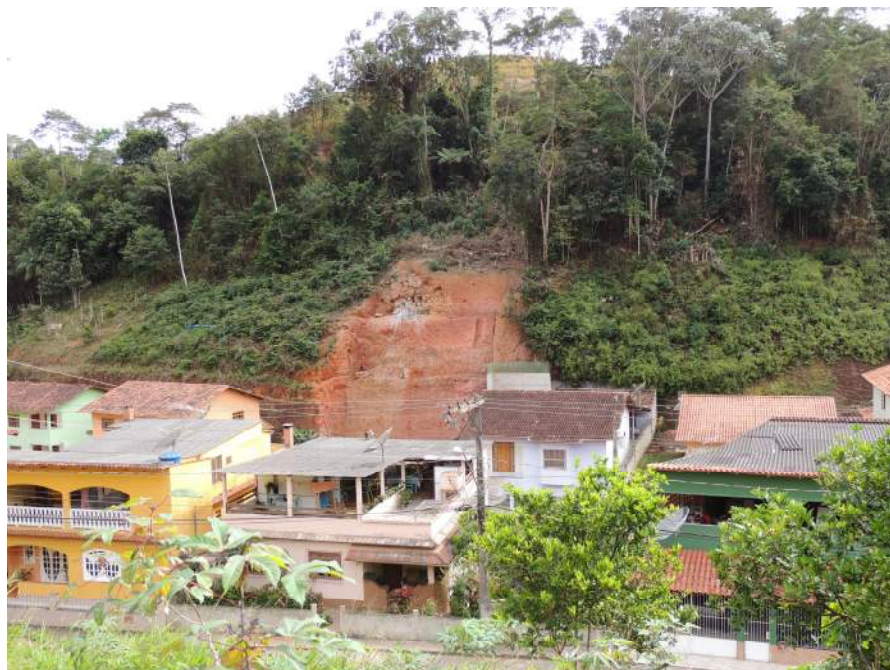
Foto 22 – Nova ocupação. Cortes verticais para construção da edificação.
