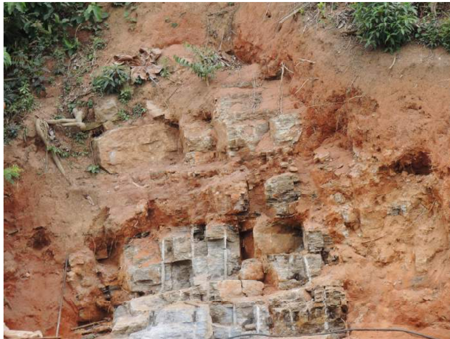
Foto 23 – Detalhe da encosta. Solo residual e maciço rochoso fraturado.
