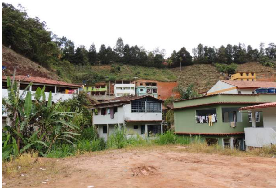
Foto 41 – Vista parcial do setor.
