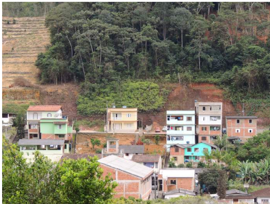
Foto 18 – Vista frontal do setor de risco.
