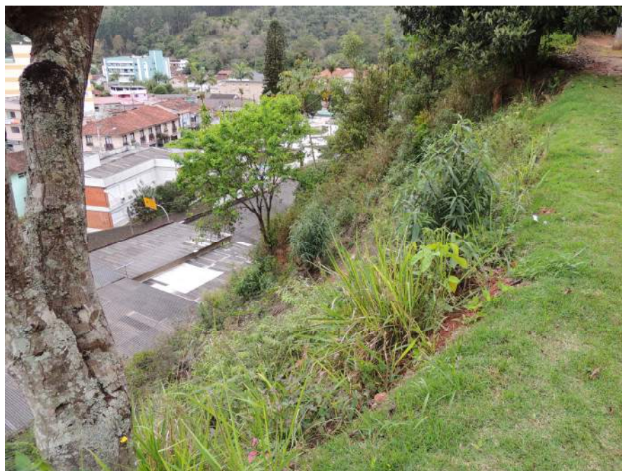
Foto 6 – Vista de montante para jusante do setor de risco. Detalhe para o desnível entre o topo e a base.
