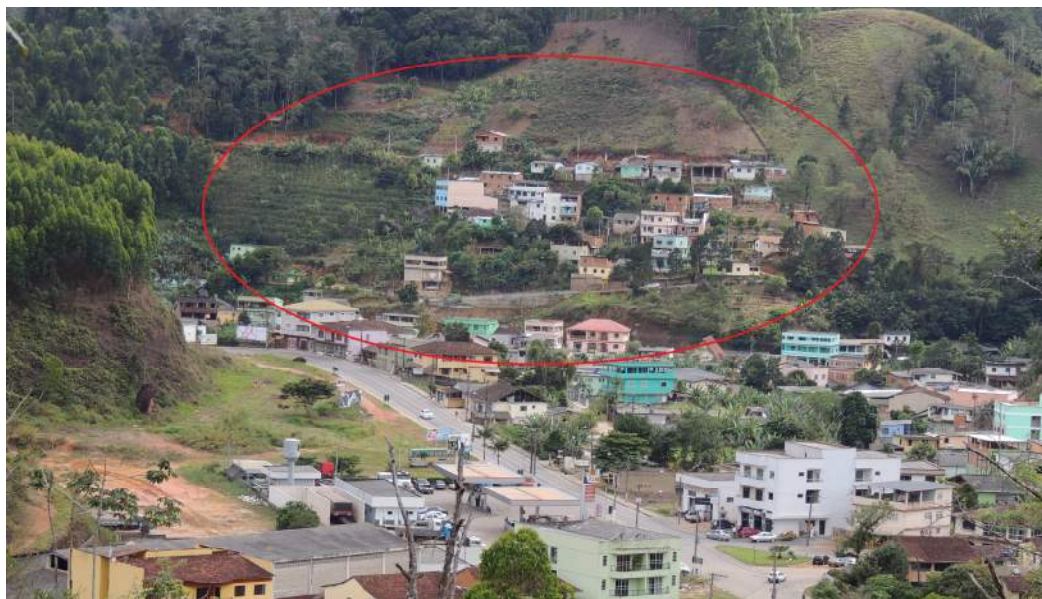
Foto 24 – Setor de risco referente a ocupação ao longo da encosta na parte superior da foto.
