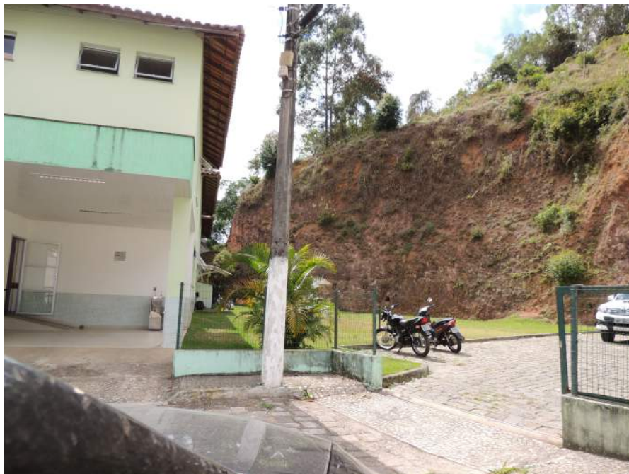
Foto 39 - Talude de corte vertical com altura de 10,0m próximo a edificação.
