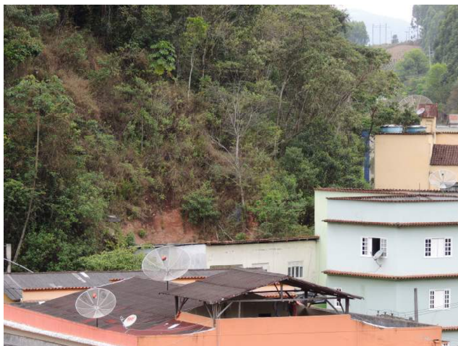
Foto 5 – Indícios de instabilidade pontuais ao longo da encosta.
