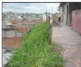
Talude de oorte com geometria inadequada e sem obras de drenagem e proteção superficial. Moradias junto a orla e base do talude
