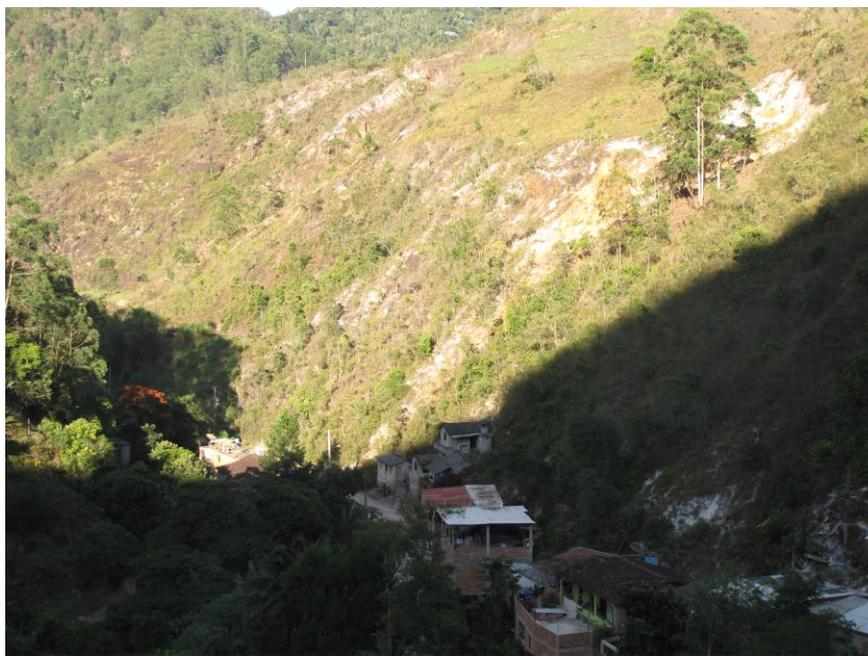
Foto 49 – Movimentos de massa deflagrados a montante do setor de risco.
