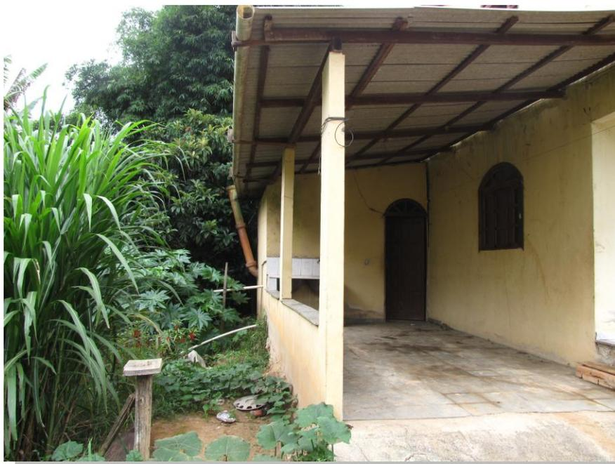
Foto 20 – Recalque em decorrência de solapamento de margem evidenciado por trincas na alvenaria e piso do domicílio.
