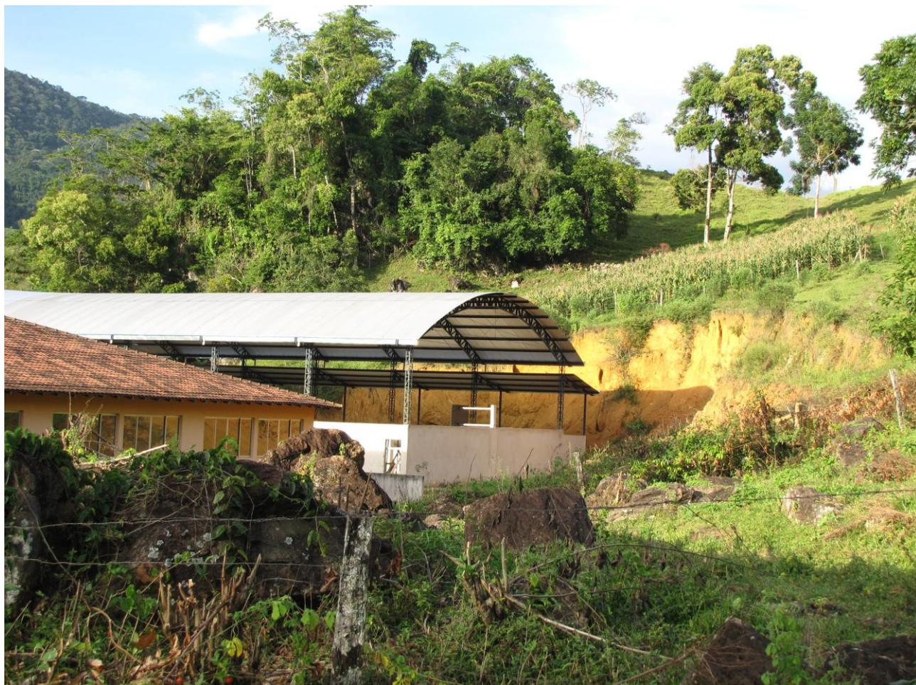
Foto 42 – Talude verticalizado com solo exposto adjacente a quadra de esportes.
