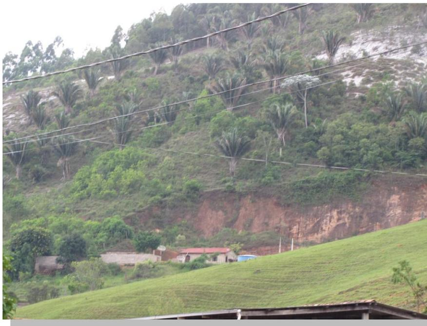
Foto 36 – Área de empréstimo com taludes verticalizados e ocupação posterior da base.
