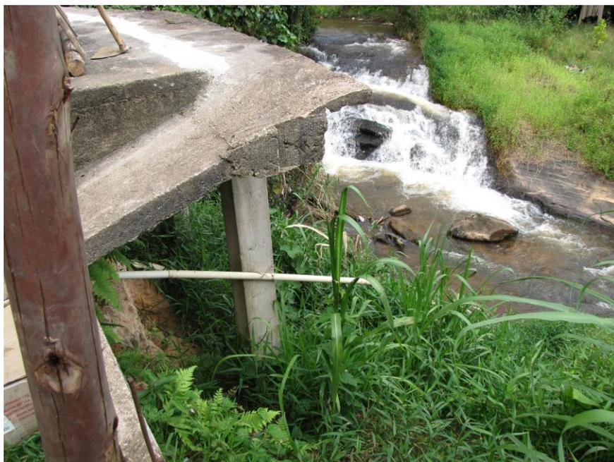
Foto 27 – Detalhe da relação entre as fundações e o regime fluvial tendo o domicílio sido construído em trecho que deveria ser considerado como não edificante.
