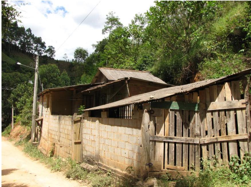
Foto 15 – Vista complementar a foto anterior com detalhe para o afastamento inferior a 1,0m entre o domicílio e a face do talude.
