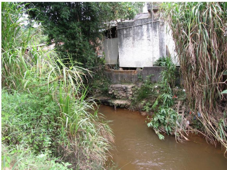
Foto 18 – Solapamento em alguns trechos com exposição de fundações.
