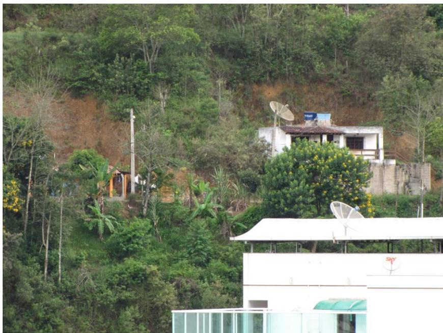
Foto 41 – Detalhe para a forma de ocupação por meio de cortes verticalizados não contidos.
