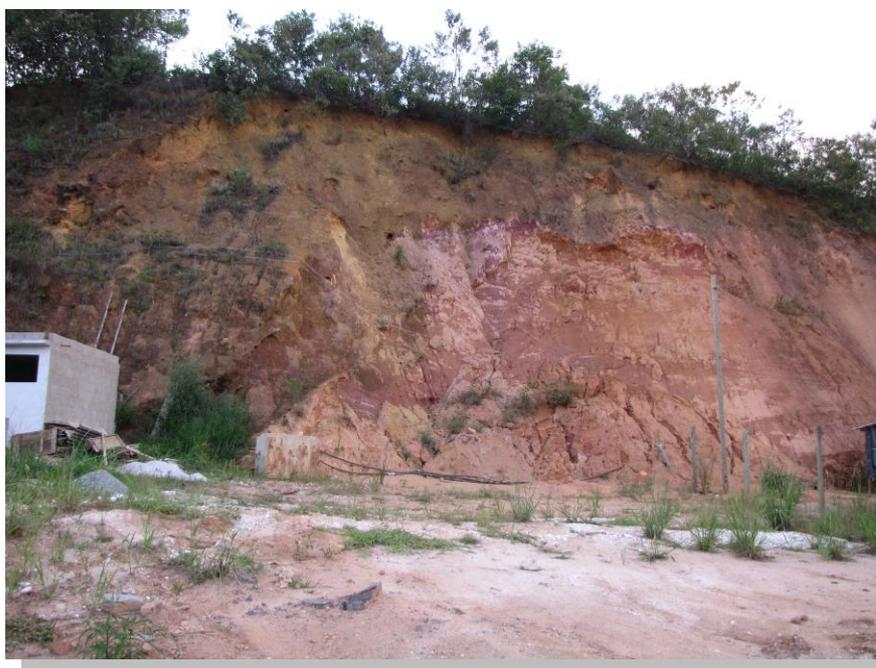
Foto 47 – Talude de corte instável com vários pontos de escorregamento ativos.
