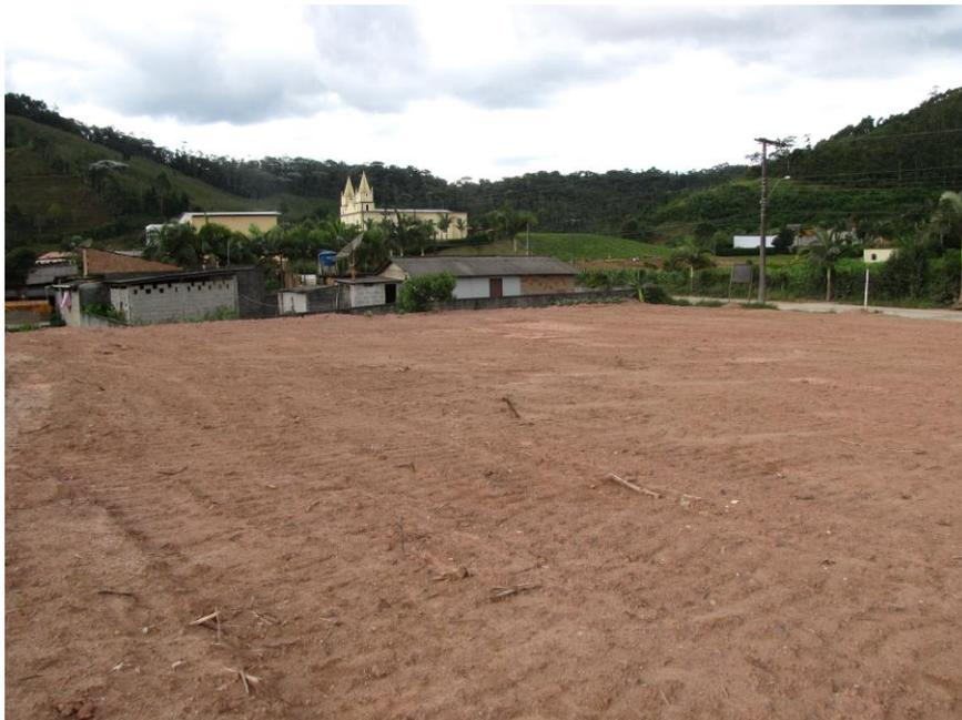
Foto 24 – Construção de um aterro no distrito de Castelinho que poderá ocasionar a elevação do nível da água em períodos de chuva no entorno, bem como o número de domicílios atingidos.
