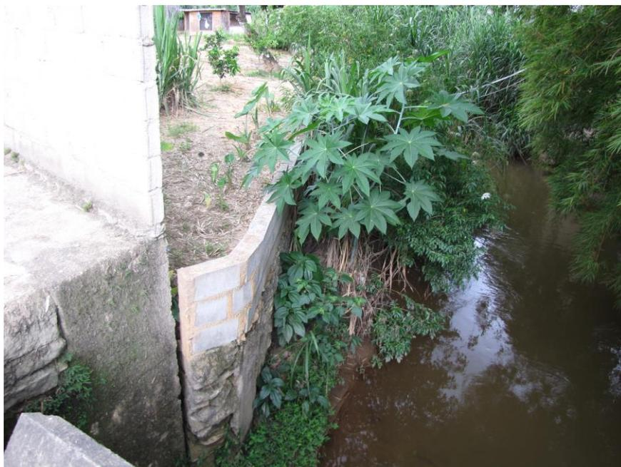
Foto 34 – Detalhe de uma construção sobre o canal com recalques em algumas estruturas.
