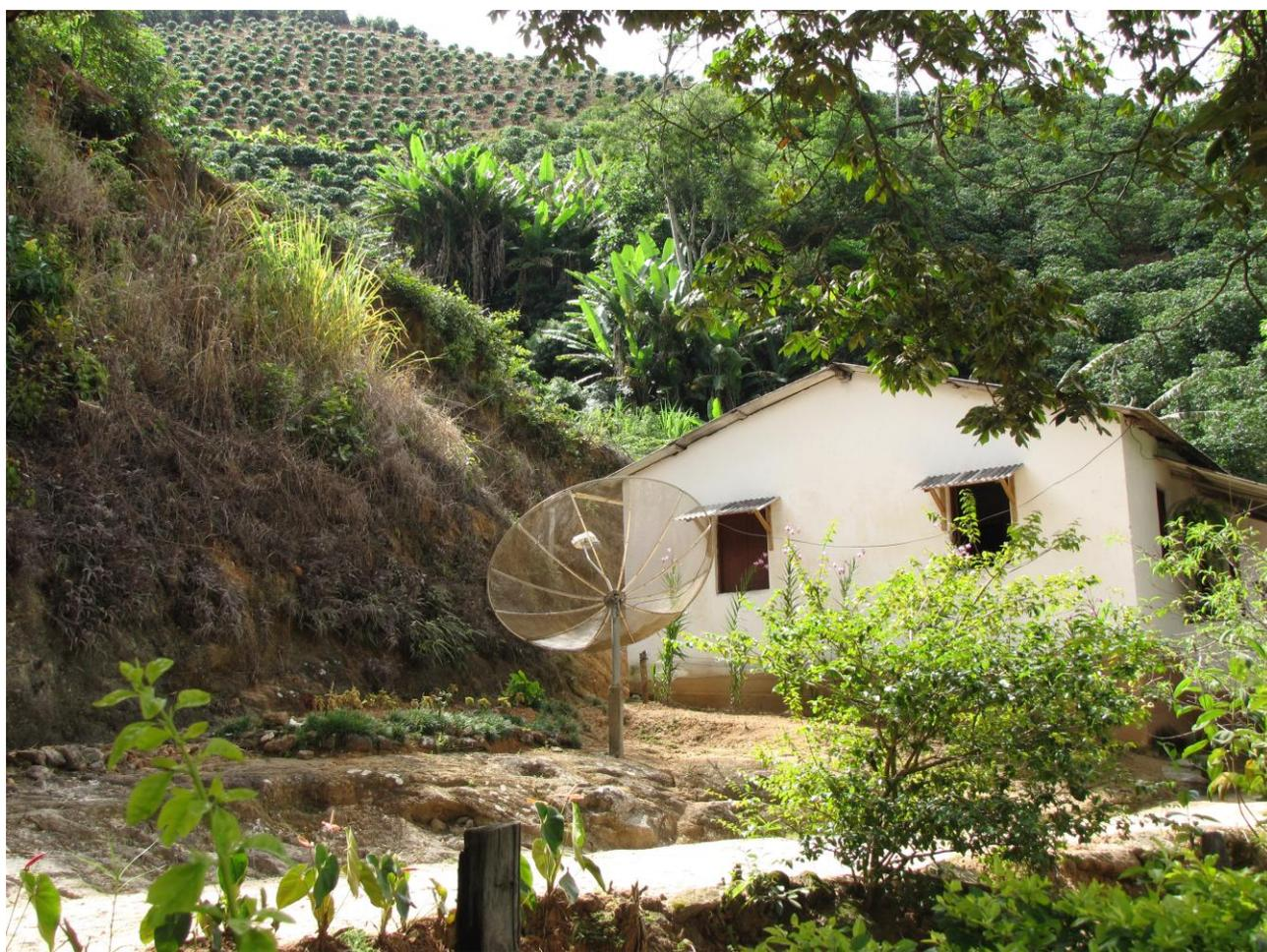
Foto 30 – Vista lateral do setor. Domicílio construído próximo ao talude de corte. Indícios de que já ocorreram escorregamentos anteriores no mesmo local.
