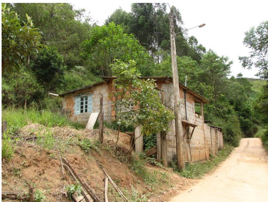
Foto 14 – Padrão construtivo baixo do domicílio construído após execução de talude de corte.
