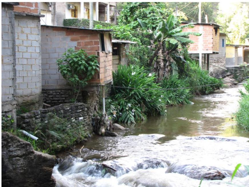
Foto 54 – Domicílios construídos adjacentes ao canal em trecho suscetível a enxurradas e solapamento.
