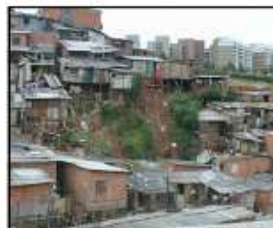
Moradias próximas da orla do talude de corte, podendo ser atingidas por futuros eventos de escorregamentos Favela Pedra sobre Pedra
