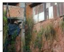
Cicatriz de escorregamento. O terreno ainda apresenta sinais de instabilidade Favela Paraisópolis
