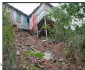
Escorregamentos em taludes de corte, mobilizando solo e atingindo moradias Jardim Andrade Pulmann
