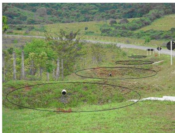
**Figura 7-4:** Bacias de contenção instaladas às margens de rodovia pavimentada.
