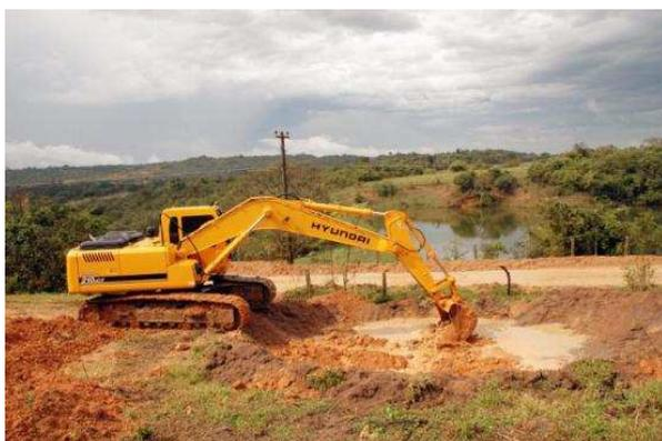
**Figura 7-5:** Implantação de uma bacia de contenção às margens de uma estrada vicinal
