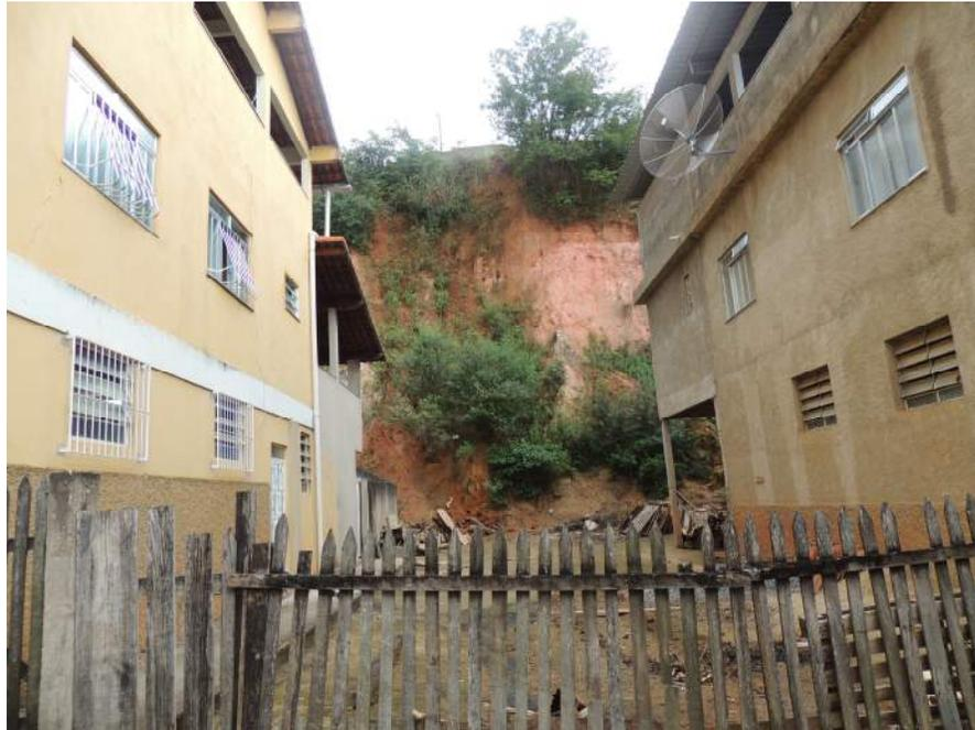
Foto 2 – Detalhe para um trecho do talude de corte para visualização da geometria do mesmo e indícios de instabilidade.
