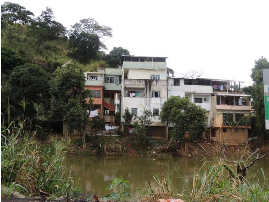
Foto 9 - Construções dentro do canal em trecho naturalmente suscetível a solapamentos.
