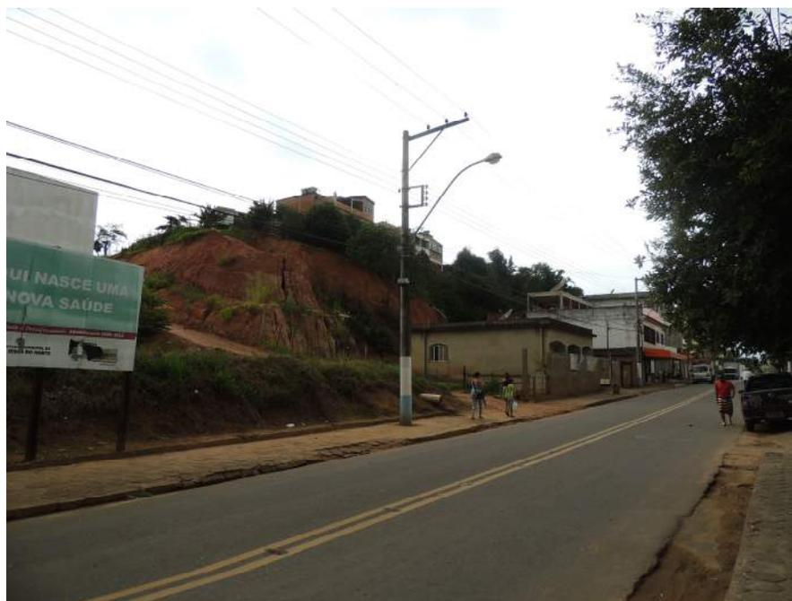
Foto 01 – Vista parcial do setor de risco. Domicílios ocupando a base e a crista de um talude de corte vertical com 10,0m de altura em solo residual.
