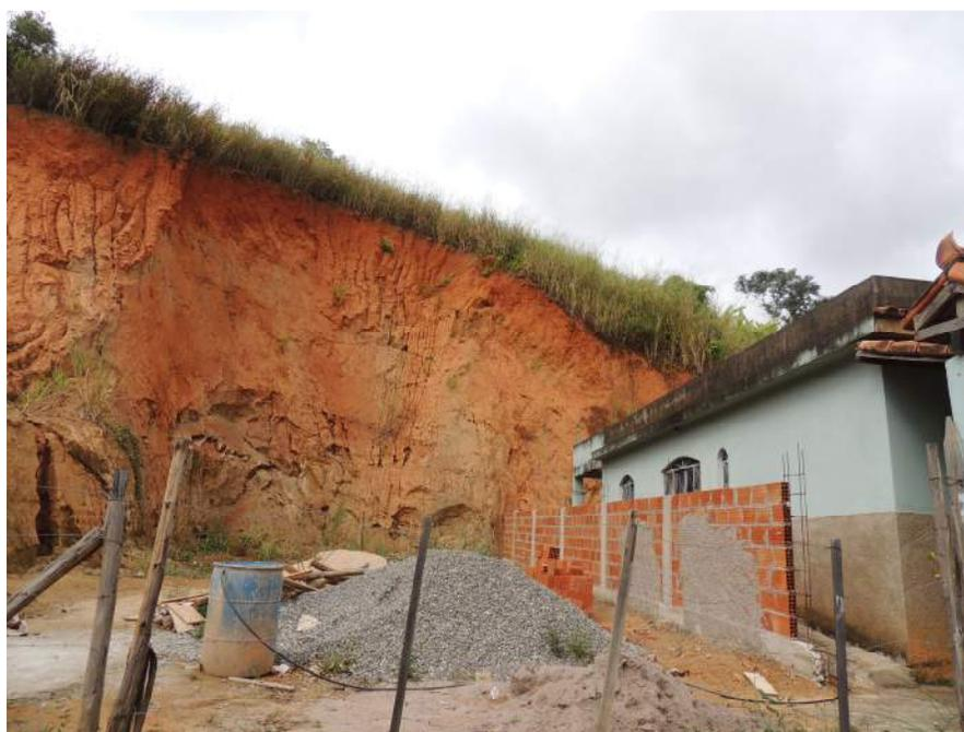
Foto 3 – Vista parcial do setor com detalhe para o talude de corte instável existente e proximidade do domicílio em relação ao mesmo.
