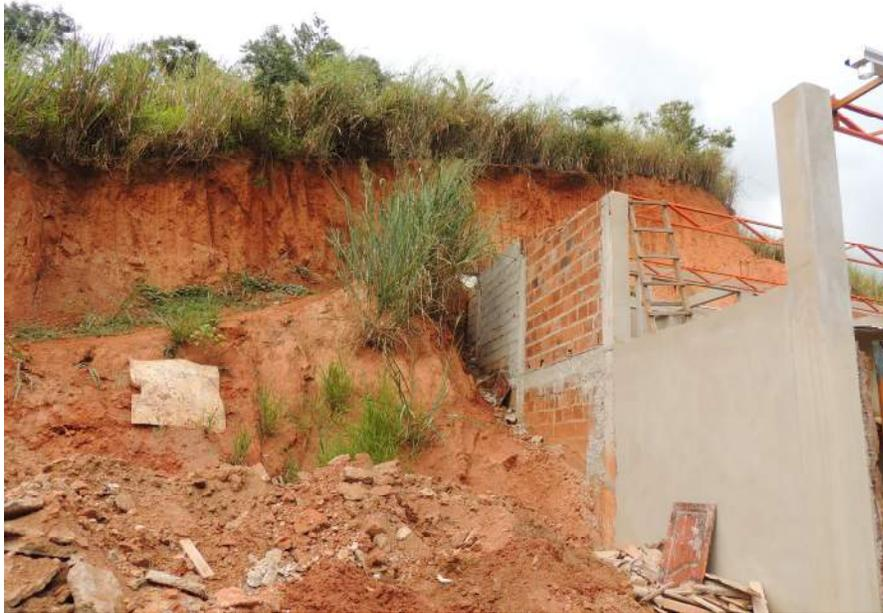
Foto 4 – Continuação do setor 2 de risco geológico com detalhe para nova ocupação e taludes não estabilizados.
