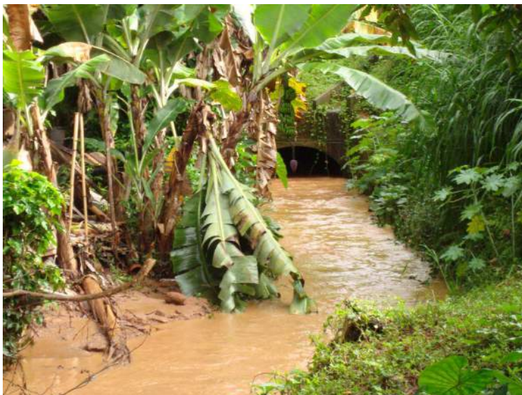
Figura 6-8: Galeria semicircular através da qual o córrego Montevidéu atravessa a BR 482.
