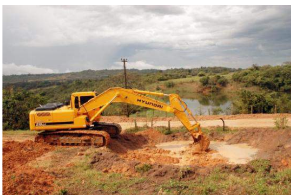
Figura 3-4: Implantação de uma bacia de contenção às margens de uma estrada vicinal
