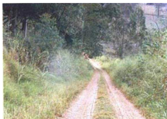
Figura 3-5: Taludes de corte e aterro e áreas não transitáveis recobertos com espécies herbáceas em estrada vicinal.
