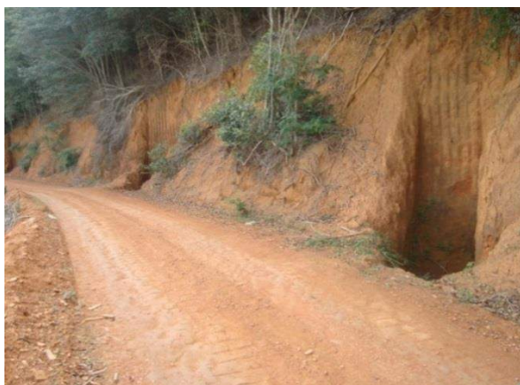
Figura 3-2: Caixas secas implantadas em estrada vicinal no município de São Roque do Canaã- ES.
