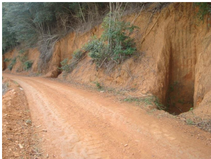
Figura 3-1: Caixas secas implantadas em estrada vicinal no município de São Roque do Canaã- ES.
