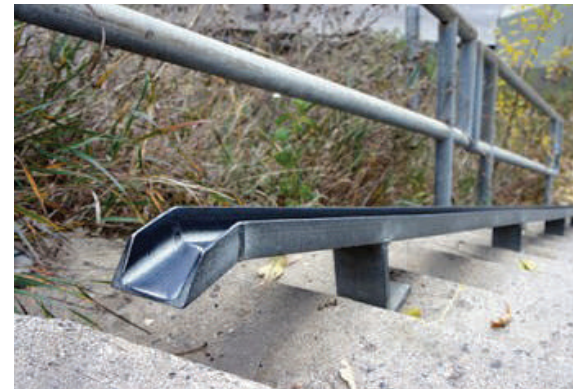
Figura 63 - Exemplos de dispositivos para bicicletas em escadarias Fonte: http://imaginefazerassim.blogspot.com.br/
