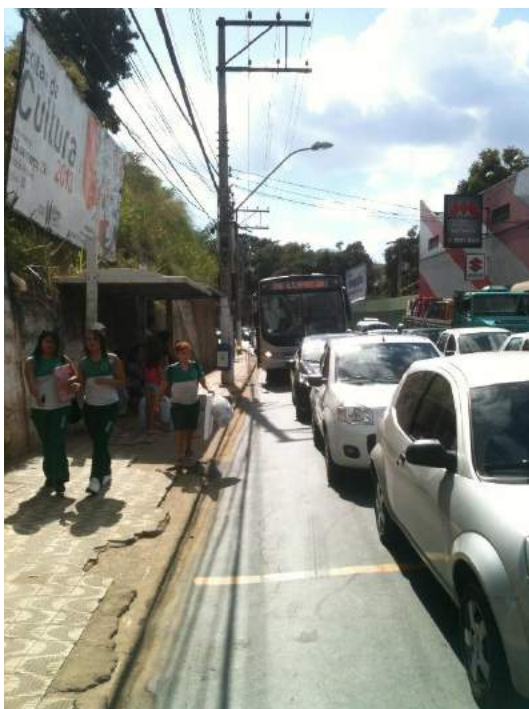
Figura 25 - Calçadas em mau estado de conservação
