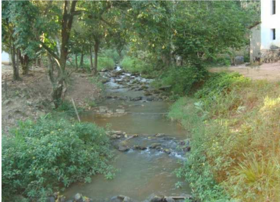
Figura 6-15: Aspecto do leito do Córrego Santa Marta em seu trecho urbano.
