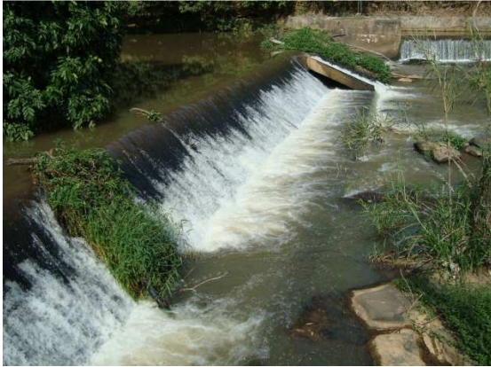
Figura 6-9: Barramento existente no rio Muqui do Sul a jusante da sede urbana do município.
