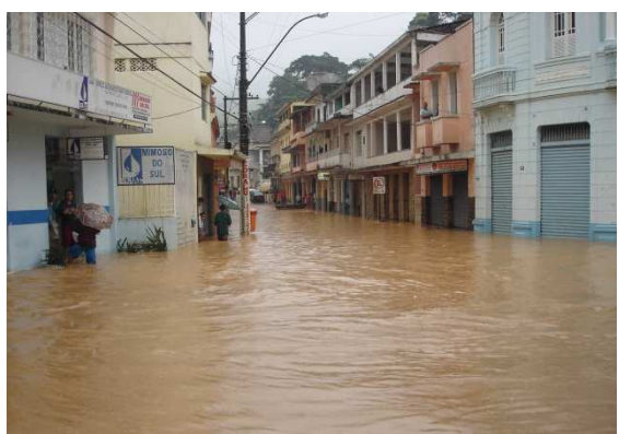
Figura 6-19: Janeiro/2005. Rua Espírito Santo, bairro Centro. Bacia do Córrego Belo Monte.
