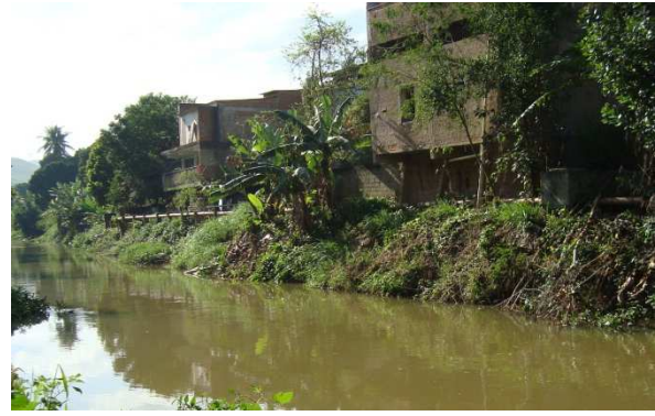
Figura 6-6: Construção de casas as margens do Rio Muqui do Sul.
