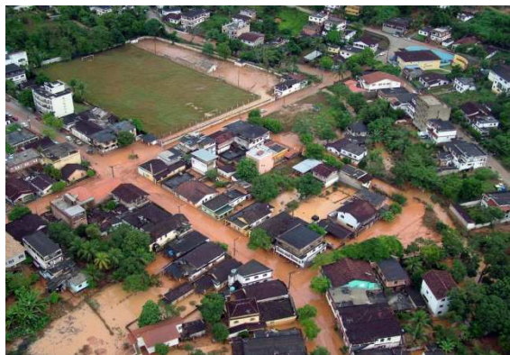
Figura 6-17: Janeiro/2005. Bairro Serrano, na bacia do Córrego da Serra.
