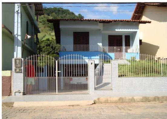
Figura 6-25: Rua Nenimato Paiva. Bacia do Córrego Santa Marta. De acordo com o depoimento do morador, a casa foi construída no segundo andar, devido a uma grande inundação.
