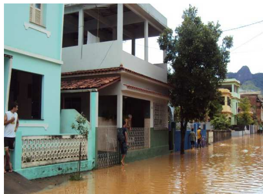
Figura 6-26: Rua Clarindo Vivas. Bacia do Córrego da Serra. Casas acima do nível da rua para evitar alagamentos.
