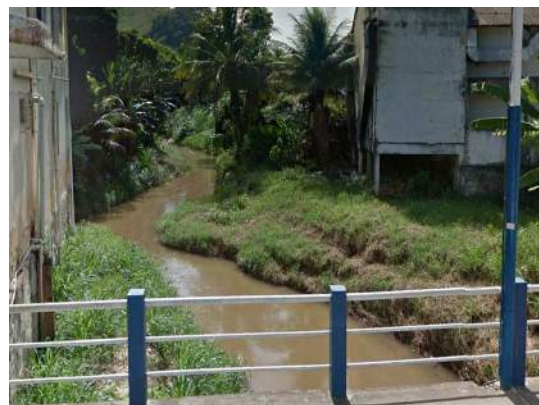
Figura 6-14: Vista da ponte sobre o córrego Belo Monte. Rua Espírito Santo.
