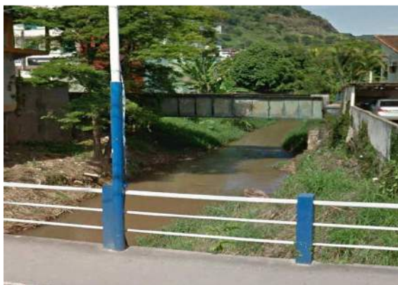
Figura 6-13: Travessia da estrada de ferro sobre o córrego Belo Monte.
