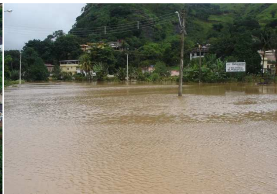
Figura 6-18: Novembro/2006. Área proposta para a futura rodoviária, ao lado do rio Muqui do Sul na Rua Antenor Navara.
