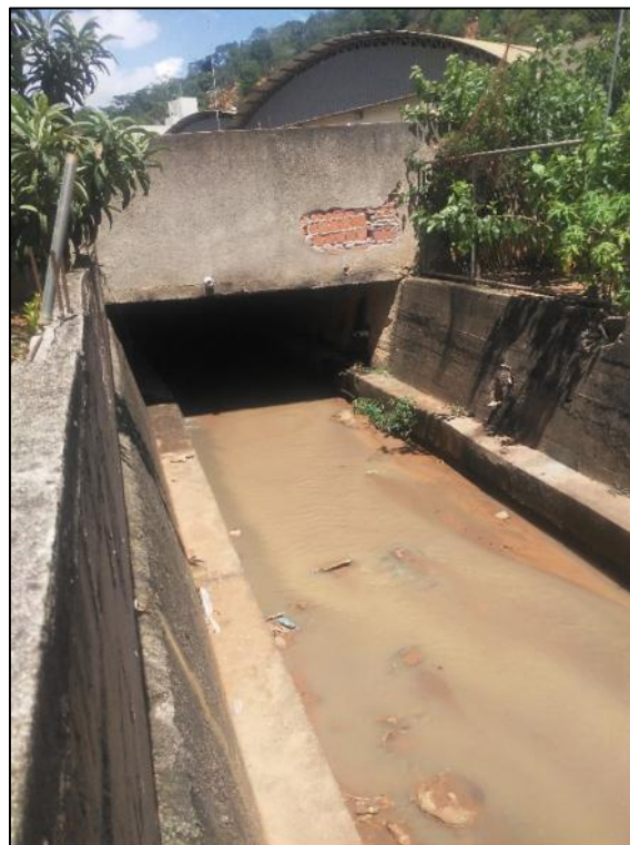
Foto 27-Vista do canal do Córrego São Silvano – Trecho 01 Montante
