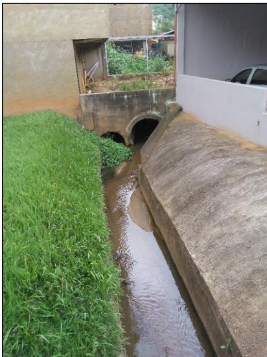
Foto 23-Vista canal a céu aberto dentro da empresa Café Meridiano
