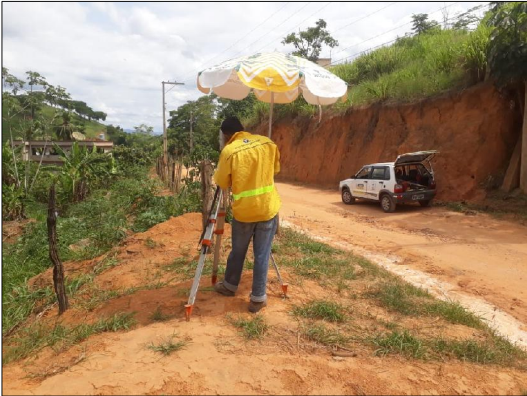
Foto 13-Vista da Rua Erondina Diniz Farias na estaca 00 da canalização projetada
