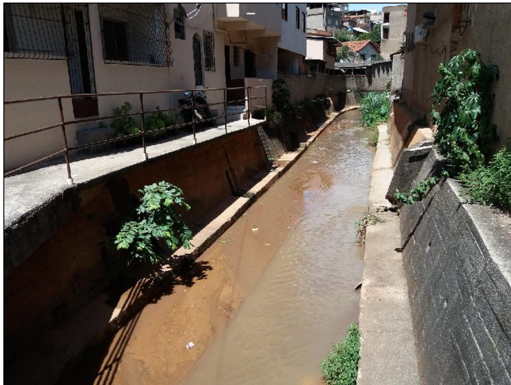
Foto 35-Vista do canal do Córrego São Silvano – Trecho 04
