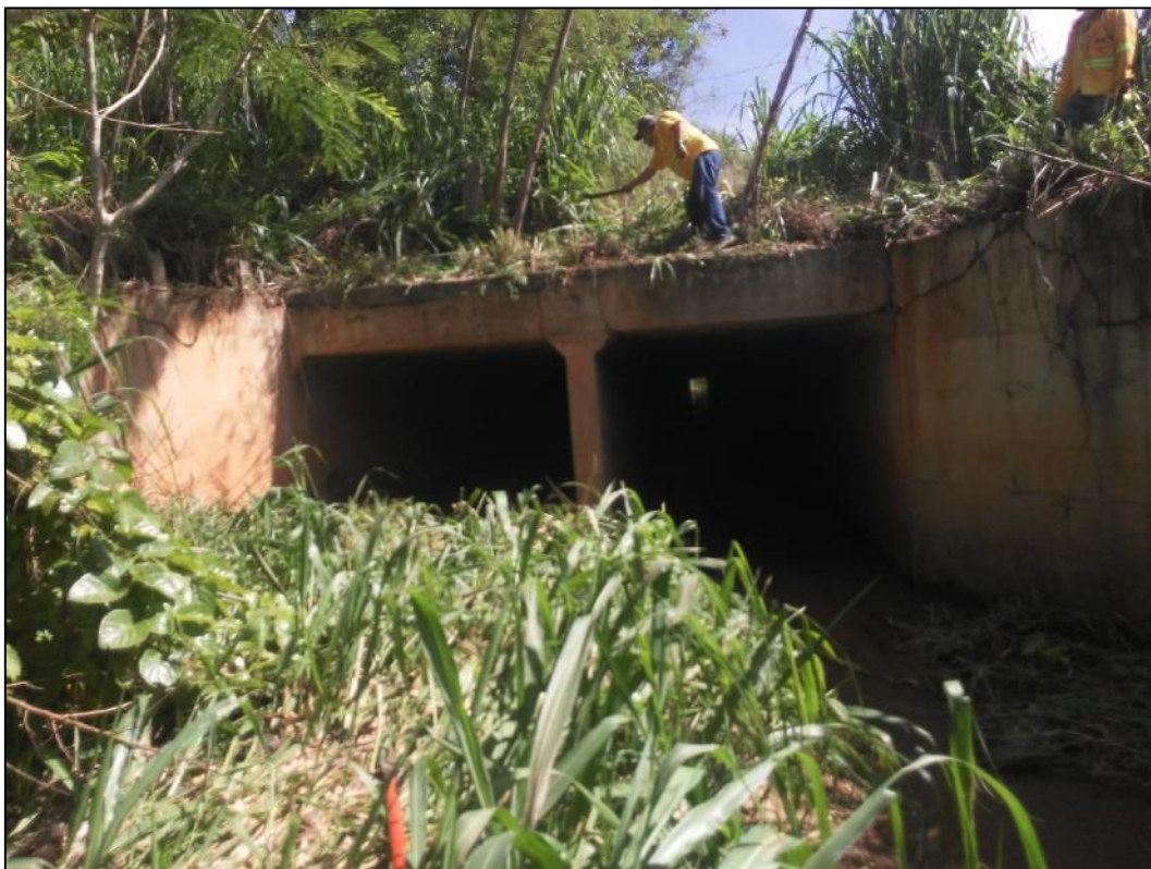
Foto 21-Vista da montante do BDCC 2,50 x 2,50m que atravessa a BR-259
