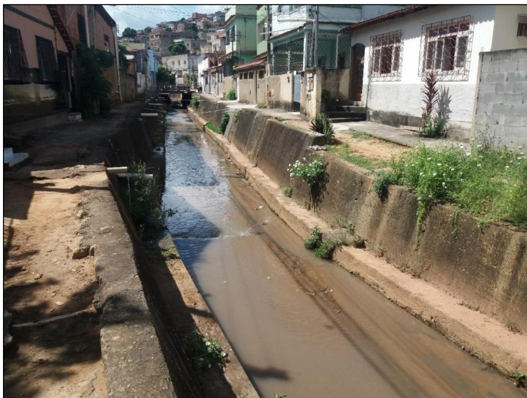
Foto 28-Vista do canal do Córrego São Silvano – Trecho 03
