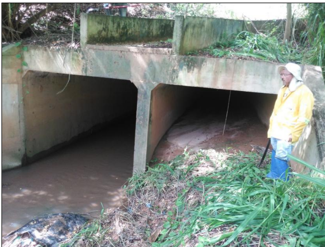
Foto 22-Vista da jusante do BDCC 2,50 x 2,50m que atravessa a BR-259
