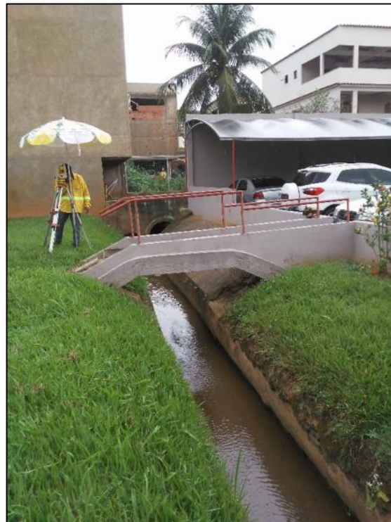
Foto 24-Vista canal a céu aberto dentro da empresa Café Meridiano
