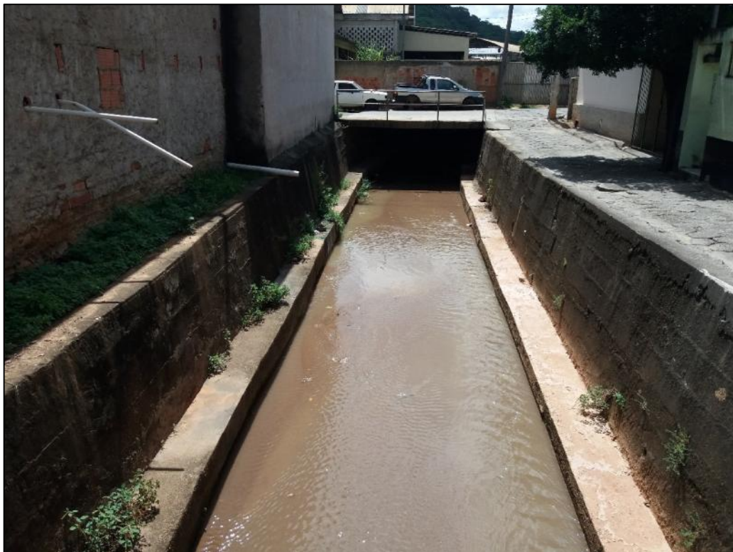
Foto 33-Vista do canal do Córrego São Silvano – Trecho 05
