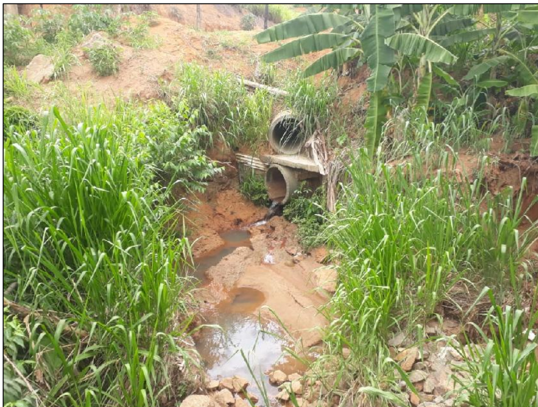
Foto 16-Vista do lançamento da rede de drenagem que desce do bairro Vicente Soela e da bacia 30 – estaca 00
