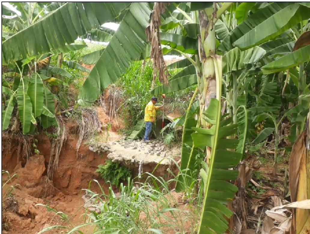
Foto 15-Vista do lançamento da rede de drenagem pluvial que desce do bairro João Meneghelli – estaca 00
