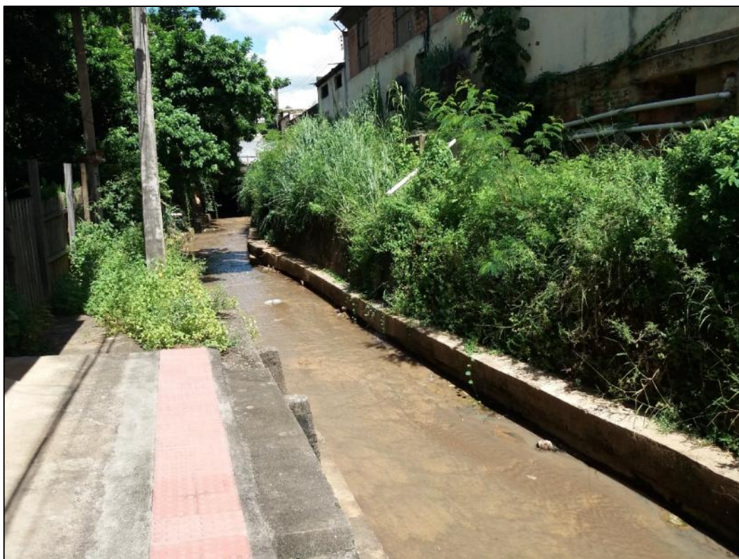
Foto 32-Vista do canal do Córrego São Silvano – Trecho 02
