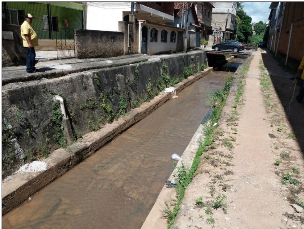
Foto 31-Vista do canal do Córrego São Silvano – Trecho 02
