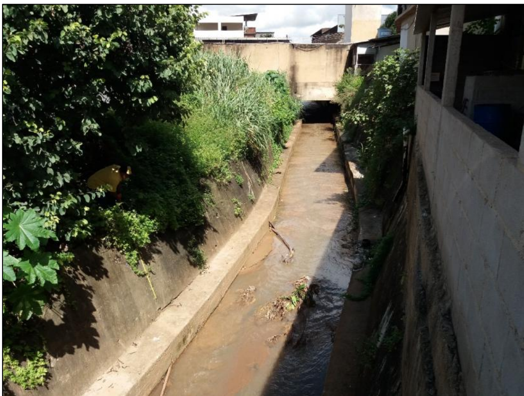
Foto 30-Vista do canal do Córrego São Silvano – Trecho 06
