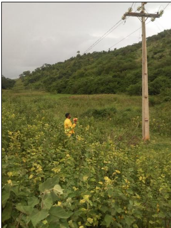
Foto 09-Vista do local previsto para implantação da barragem da bacia 41
