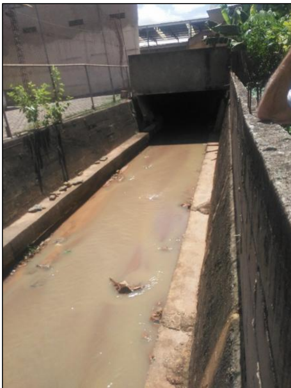
Foto 26-Vista do canal do Córrego São Silvano – Trecho 01 Jusante
