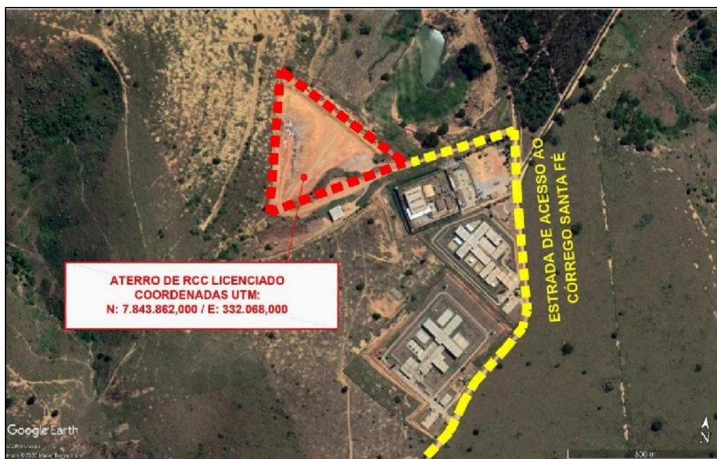
Figura 6 – Foto aérea do aterro de RCC licenciado no município de Colatina-ES Fonte: Google Earth – Tonon Projetos
