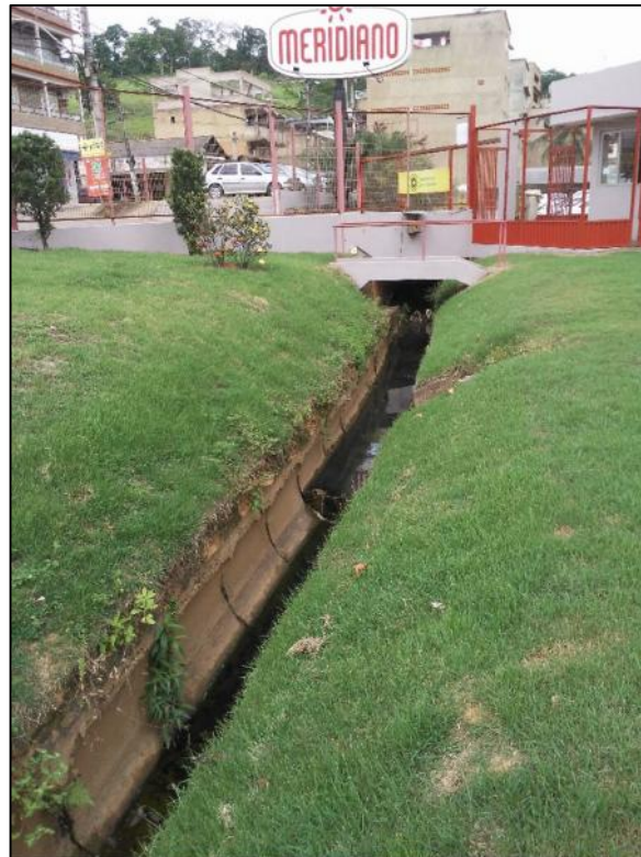
Foto 25- Vista canal a céu aberto dentro da empresa Café Meridiano
