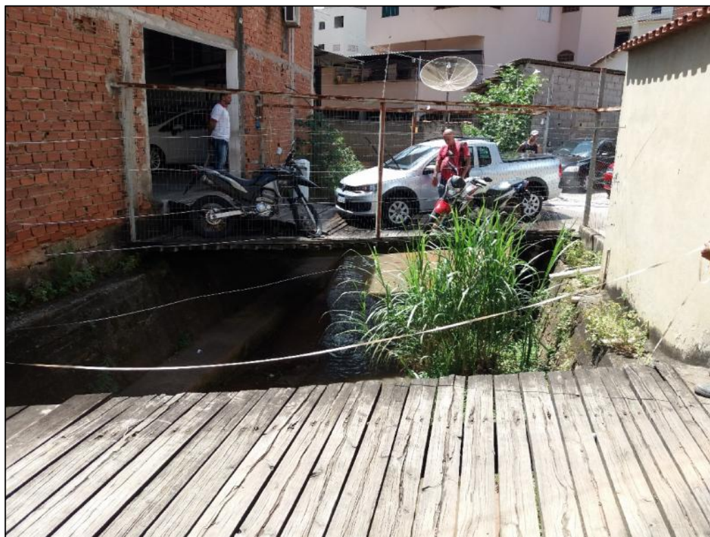
Foto 36-Vista do canal do Córrego São Silvano – Trecho 04
