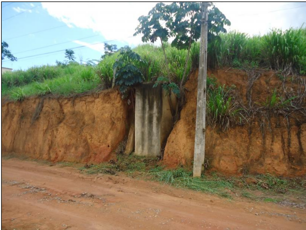
Foto 14-Vista da caixa da drenagem que desce do bairro Vicente Soela – estaca 00
