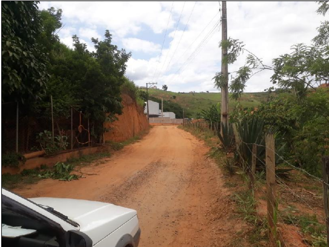
Foto 17-Vista da Rua Erondina Diniz Farias – trecho sem pavimentação
