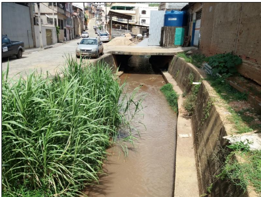
Foto 34-Vista do canal do Córrego São Silvano – Trecho 05
