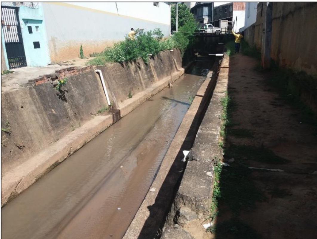
Foto 29-Vista do canal do Córrego São Silvano – Trecho 03
