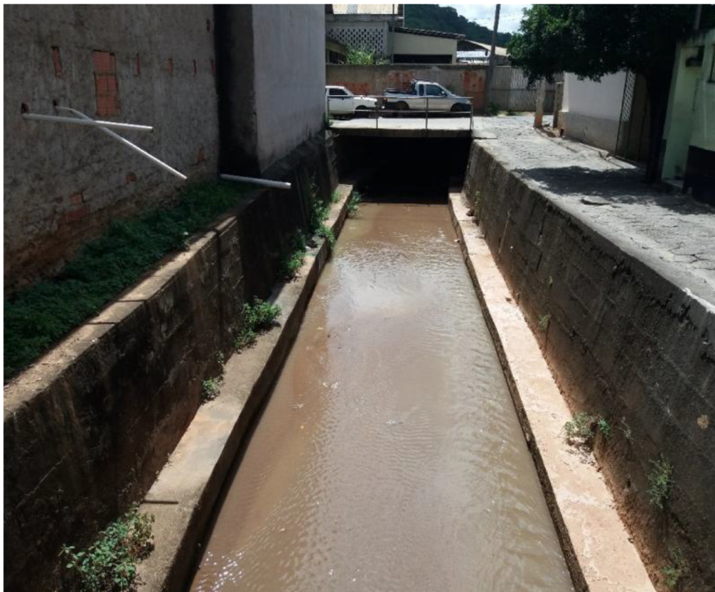
Figura 12 – Calha do Córrego São Silvano revestida com concreto.
