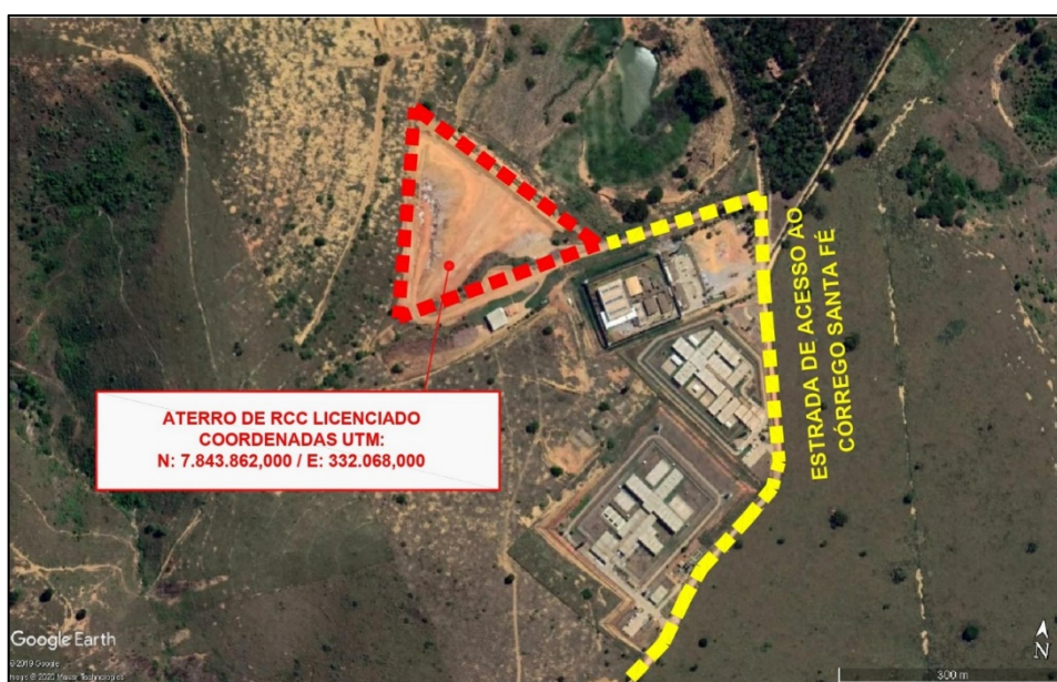
Figura 36 – Aterro de RCC licenciado no município de Colatina/ES
