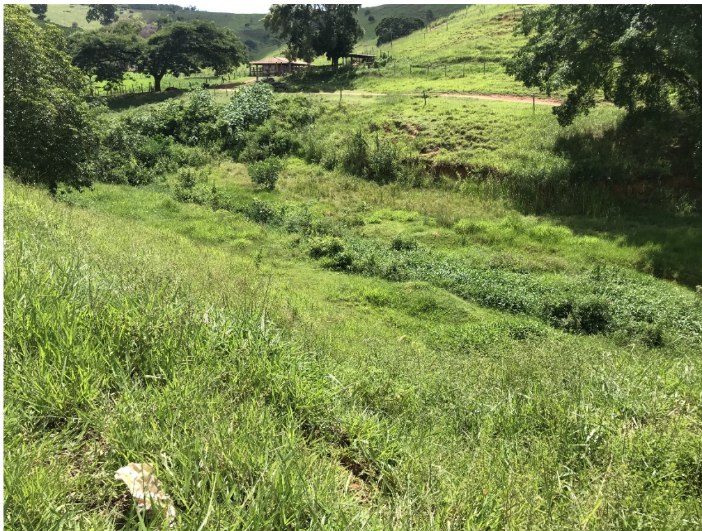
Figura 11 – Bacia de inundação, perímetro imediato ao barramento. Fonte: O autor, 2020.
