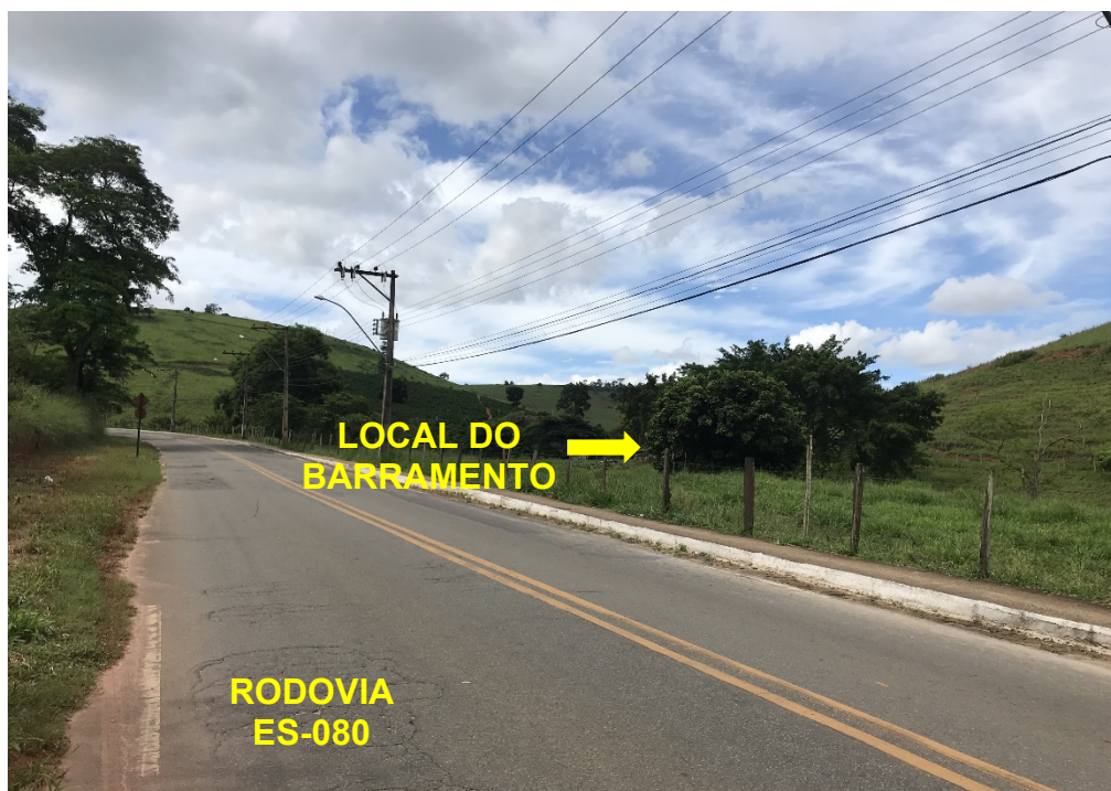
Figura 1 – Local de construção da barragem B-17 às margens da rodovia ES-080.
