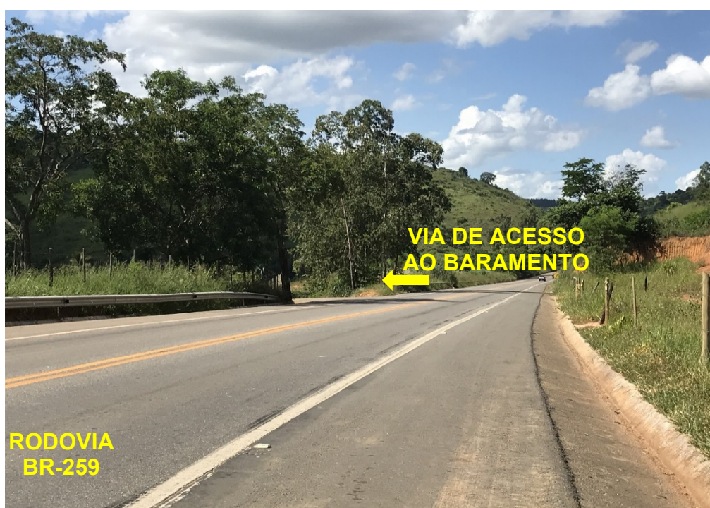
Figura 5 – Acesso ao local de construção da barragem B-41. Fonte: O autor, 2020.
