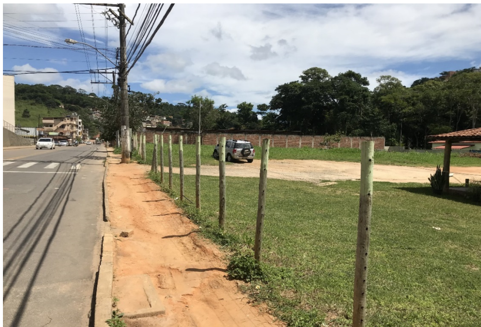
Figura 28 - Local para instalação do canteiro de obras a margem da ES-080.
