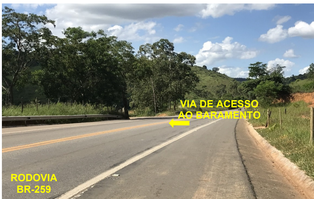
Figura 1 – Acesso ao local de construção da barragem B-41.
