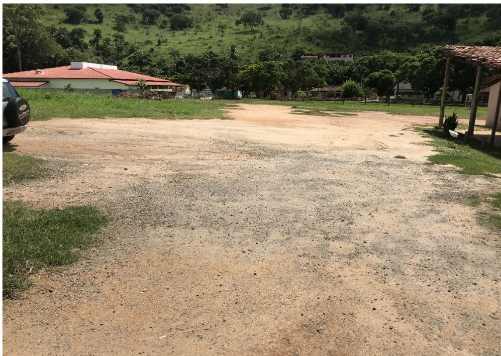
Figura 17 – Instalações do canteiro de obras. Fonte: O Autor, 2020
