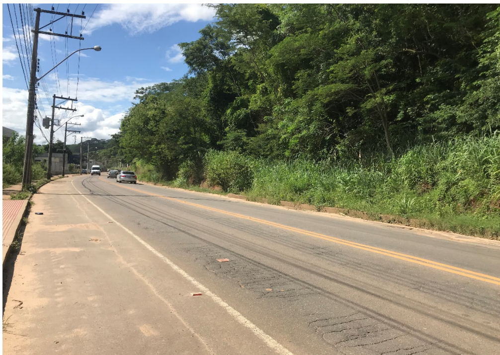
Figura 13 – Perfil do solo na rodovia ES-080 Fonte: O Autor, 2020
