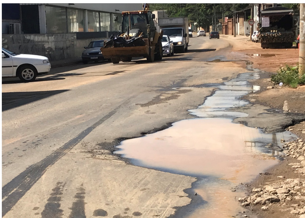
Figura 1 – Trecho da Rodovia ES-080, próximo ao Oba Superatacado.
