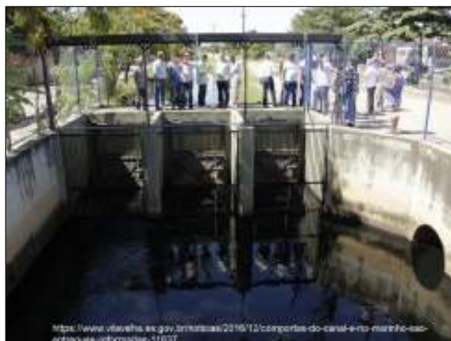
Figura 11 - Comporta no Canal Marilândia – Canal Marinho,
