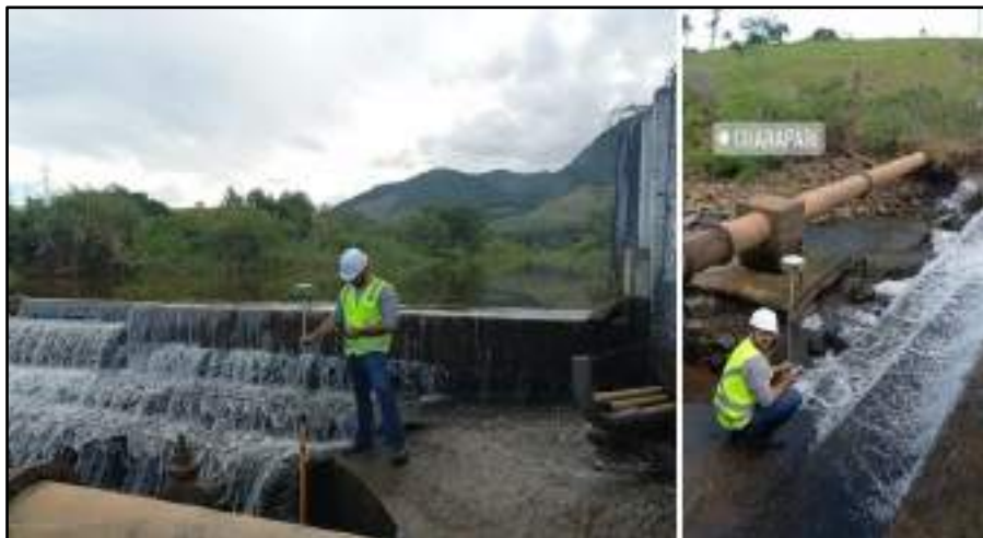
Figura 44 – Localização da estação e imagens do cadastramento da barragem para regularização de nível d'água na estação de captação da CESAN no Rio Jabuti.
